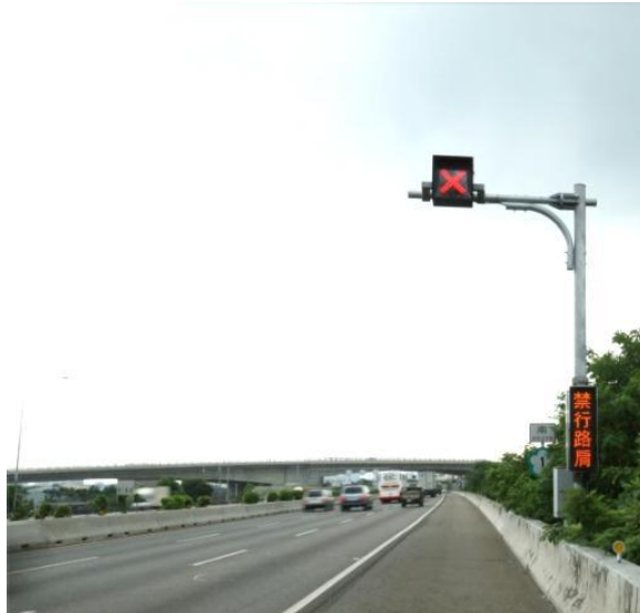
圖 4.1-8 CMS 搭配車道管制號誌顯示內容
