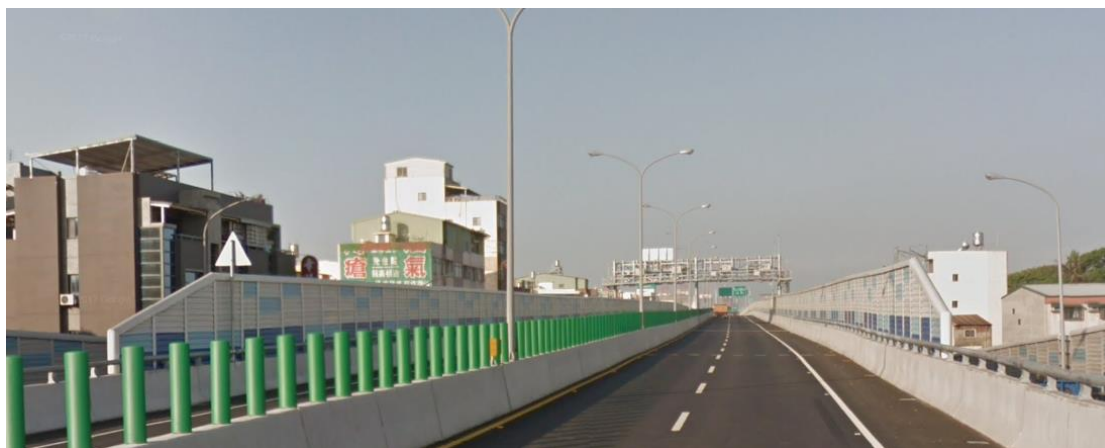
圖 5.1-34 增高型中央鋼筋混凝土護欄案例
