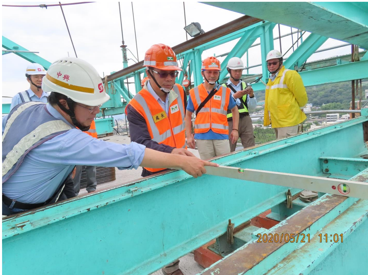
圖 1 為國道 4 號豐潭段 C714 標橋樑施工安全，郭處長親自檢視懸臂工作車相關檢查結果，並確認坡度掌握與穩固
