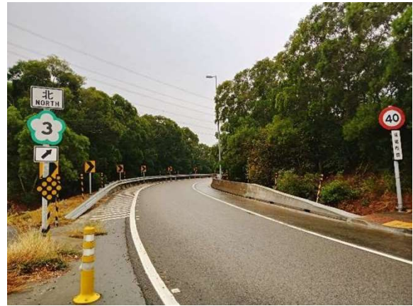
圖 4.1.3 護欄端末漸變辦理成果
