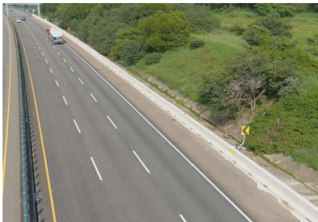
國道 3 號北上大山—竹南路段 鋼板護欄改為 RC 護欄、增加 LED 輔 2 標誌及外側護欄增加反光浪板、導標
