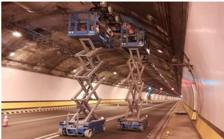
圖 4.1.14 國道 3 號蘭潭隧道電力、照明及火警系統改善
