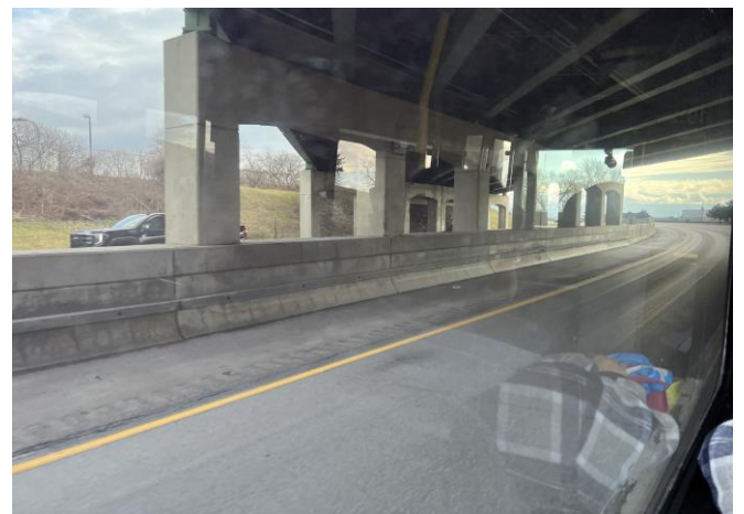
洲際道路中央分隔帶護欄與跨越橋橋墩空間充分結合
