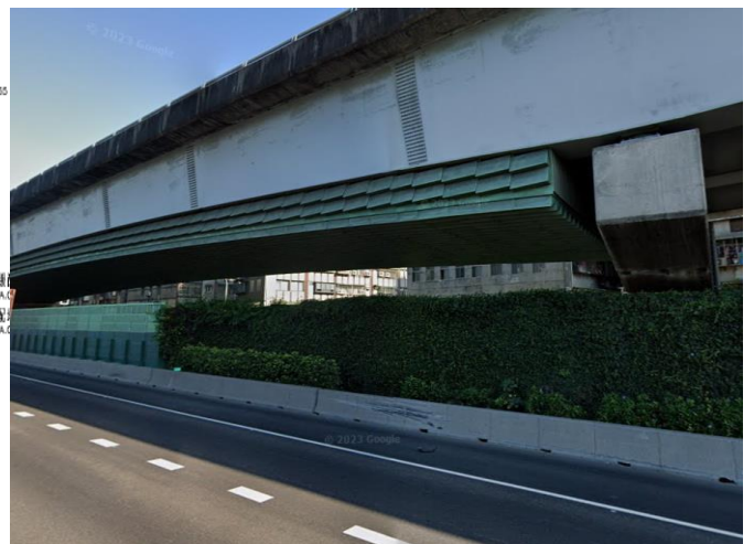
國1汐五高架下方之倒吊型金屬吸音板
