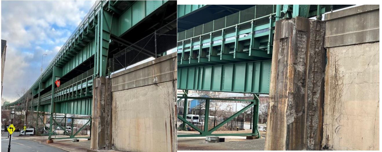
主要橋梁柱混凝土嚴重剝落及鋼筋外露銹蝕嚴重
