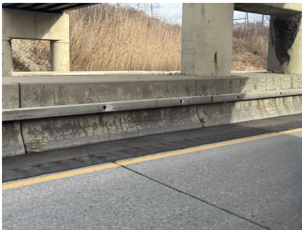
洲際道路中央分隔帶護欄與跨越橋橋墩空間充分結合
