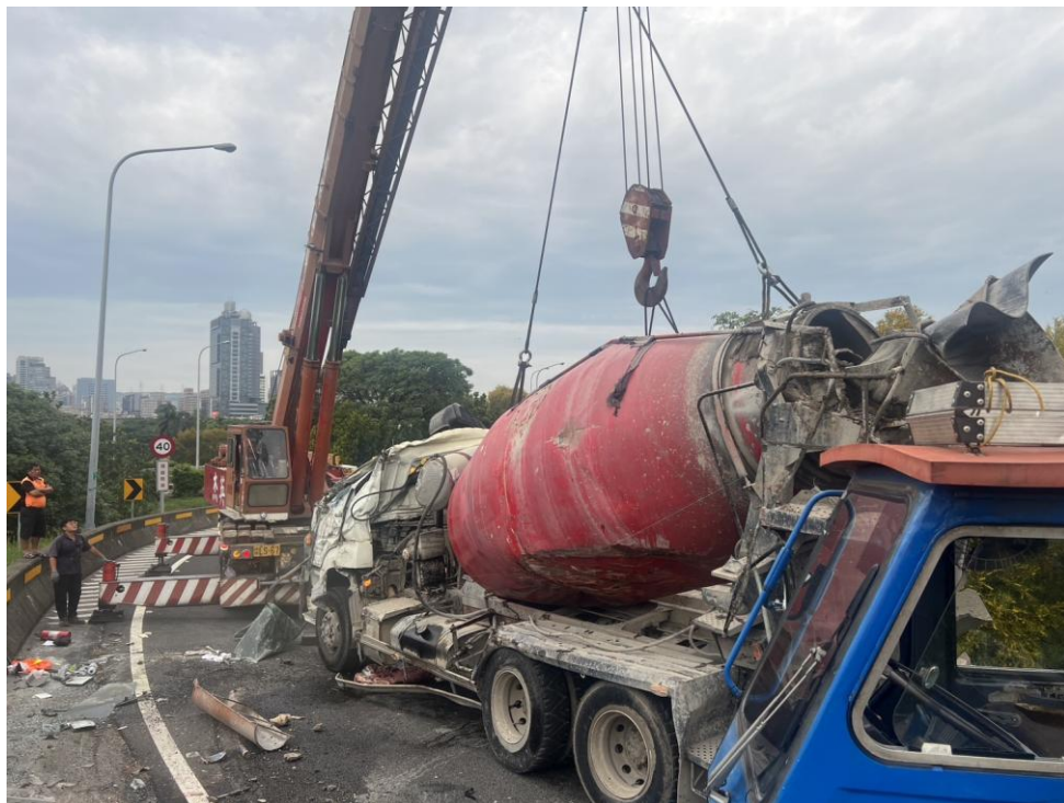
附圖 2 國 1 南向 178k 台中交流道出口 115 年 5 月 4 日 混凝土預拌車自撞事故排除作業
