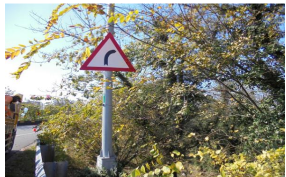
國道 1 號南向豐原出口，進匝道速限牌面下游燈桿處加設「警 1」
