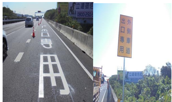
國 1 南向台中系統豐原路段每 200 公尺劃設 1 組「出口專用」標字；並設置「外側車道 出口專用」牌面
