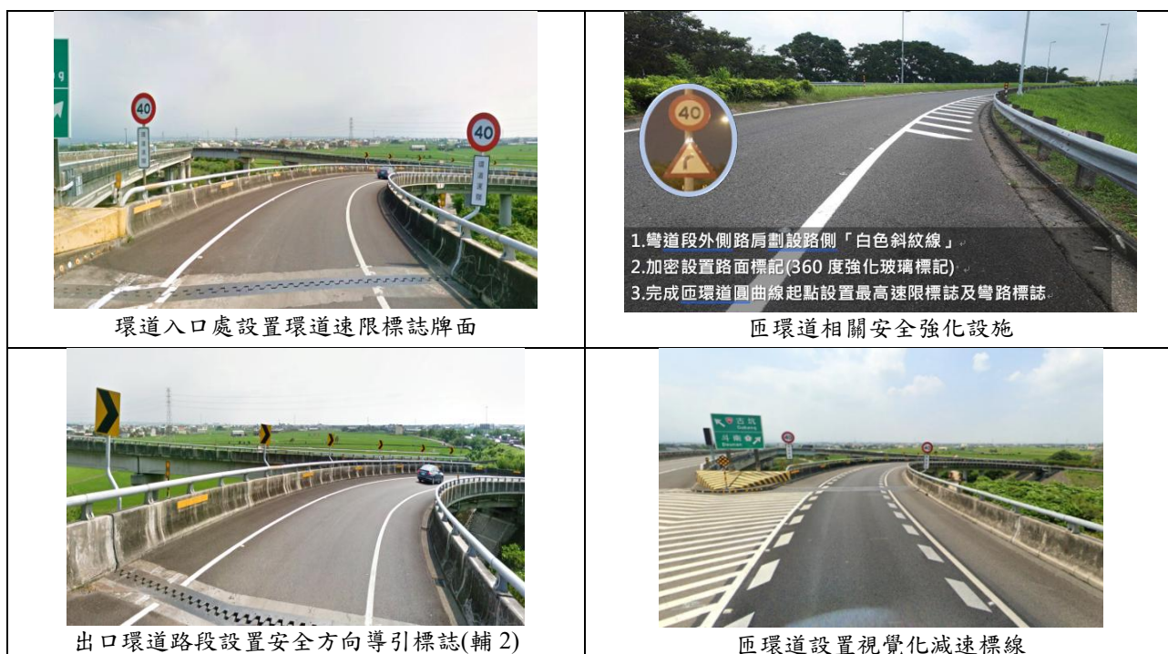
圖 4.1.4 匝環道安全交通工程設施
