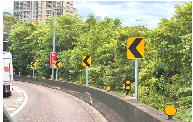
國 3 北向中和交流道出口匝道彎道增設安全方向導引標誌「輔 2」
