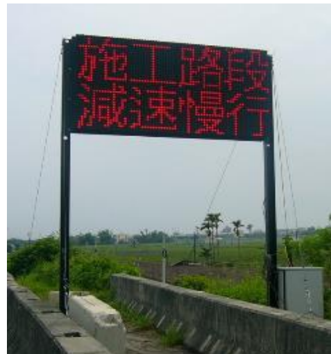
路面設置式移動式 LED 標誌板相片例
