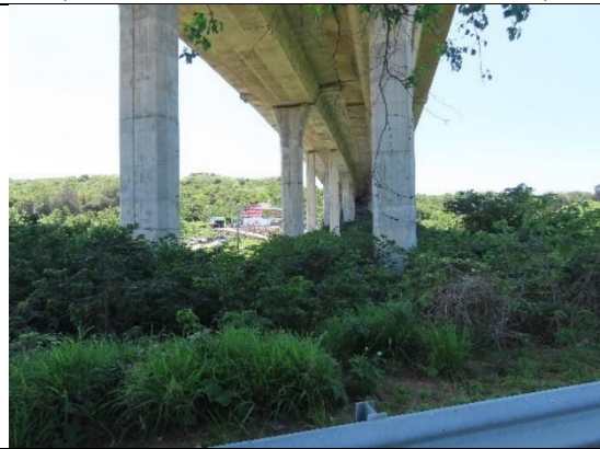
後龍一號高架橋下南岸次生林 (X : 228847.412, Y : 2721893.843)
