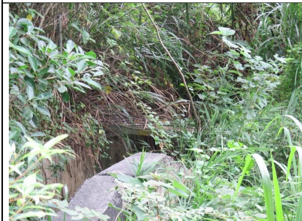
通霄一號高架橋下水溝既有動物通道 (X : 223242.82, Y : 2714180.63)
