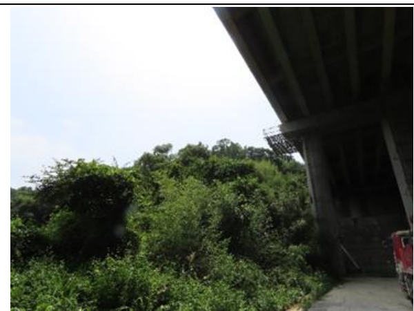
通霄二號高架橋旁東側次生林 (X : 222263.08, Y : 2713045.71)
