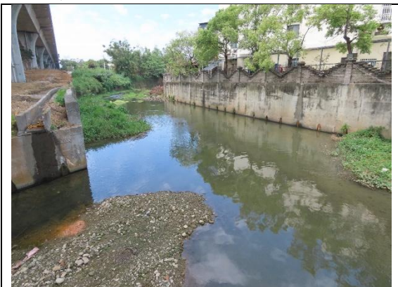
冷水坑溪水域棲地
