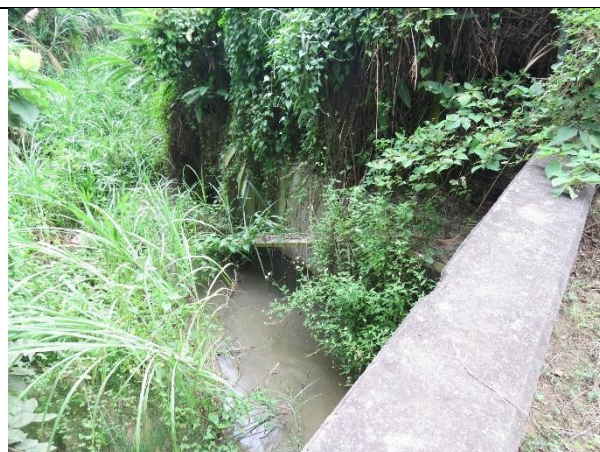
通霄一號高架橋下水溝既有動物通道 (X : 223245.76, Y : 2714197.68)
