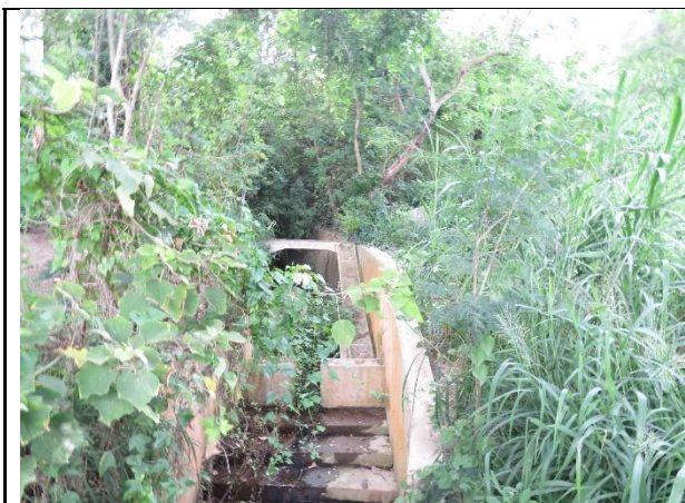
通霄一號高架橋下水溝既有動物通道 (X : 223305.52, Y : 2714244.07)
