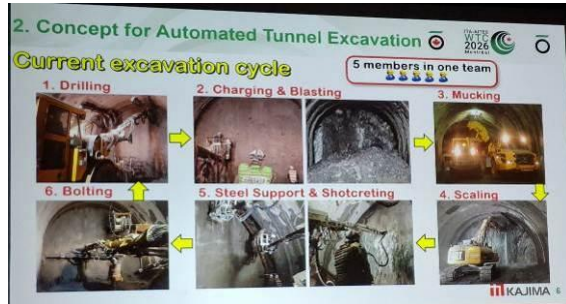
圖 40 目前開挖之施工流程
