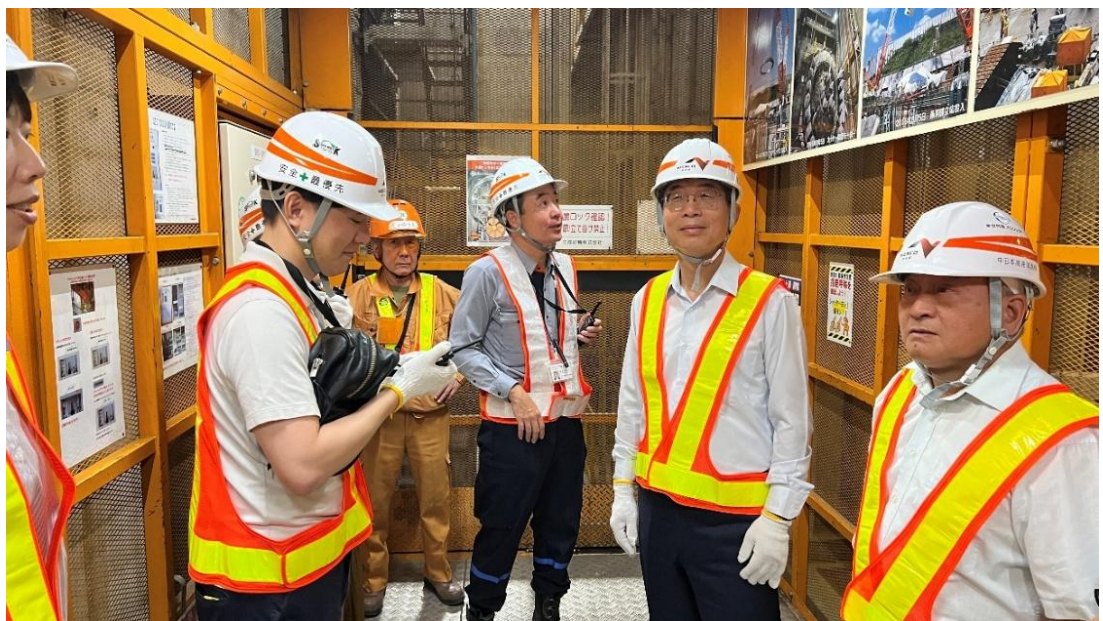
圖4-8 搭乘電梯前往地下40公尺深的潛盾隧道工地現場
