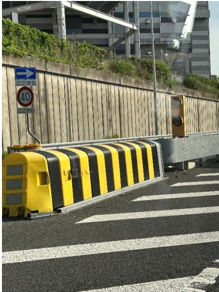
圖4-26 出口鼻端之警示或碰撞防護設施
