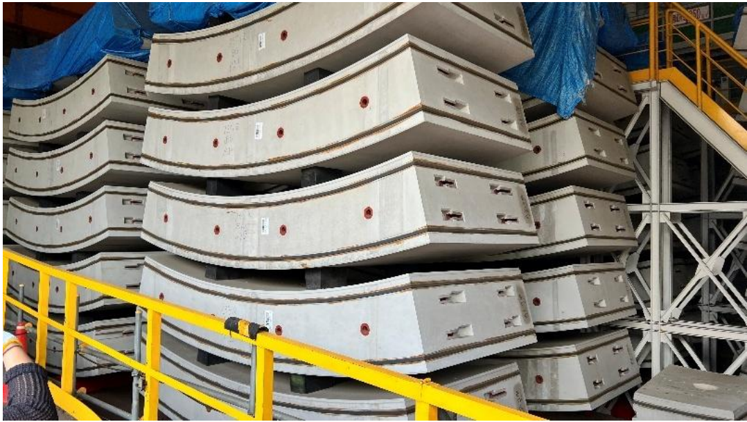
圖4-6 一般路段使用的標準預鑄RC環片
