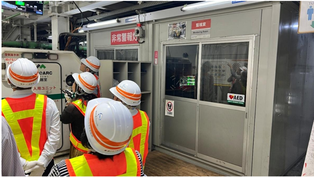
圖4-13 開挖面旁控制室
