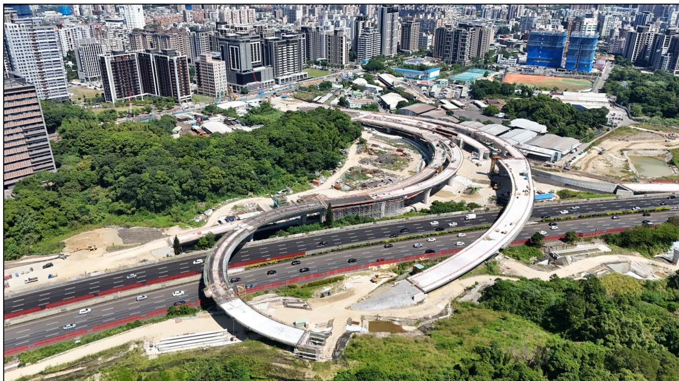
附圖 2、國道 3 號增設金城交流道工程施工現況，匝道橋梁已逐步成形
