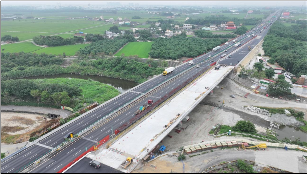
附圖 5、石龜溪橋施工現況，工程於維持國道 1 號交通功能下，透過交維替代道路及分階段轉換南、北向車流方式辦理橋梁改建
