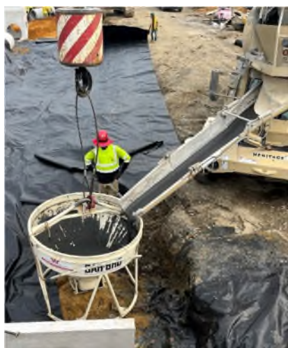
圖51 超高性能混凝土澆置
