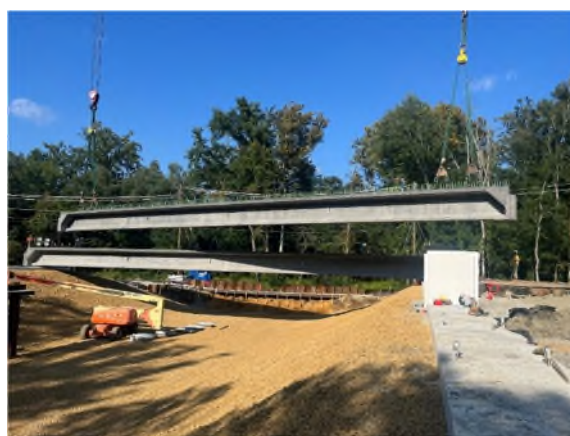
圖50 預鑄球根T形梁吊裝
