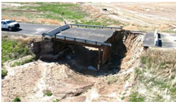
圖37 沙溪144號大道橋因洪水而損害 狀況(1)
