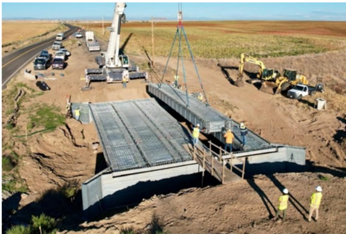
圖43 結構板安裝順序
