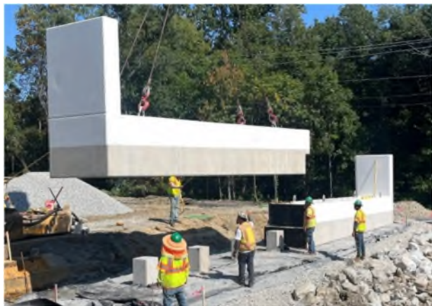
圖49 預鑄混凝土橋台安裝
