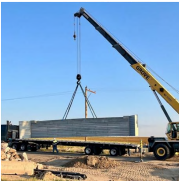
圖41 預鑄橋台自運送車起吊
