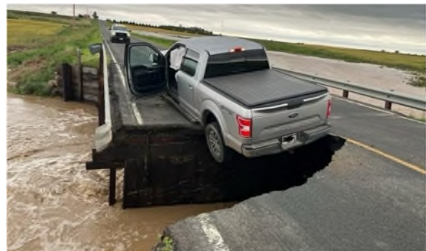
圖38 沙溪144號大道橋因洪水而損害 狀況(2)
