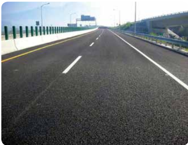
圖 6 - 臺中生活圈 4 號線工程使用改質瀝青鋪面路段
