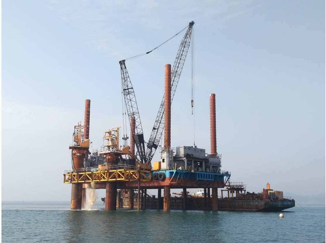
圖 3：P48_鋼箱圍堰下放
