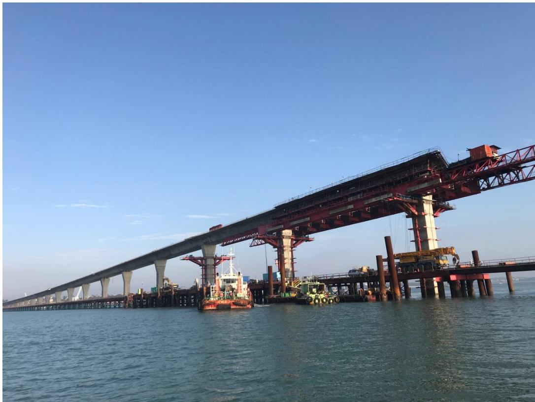
圖 4：金端引橋上構全部完成
