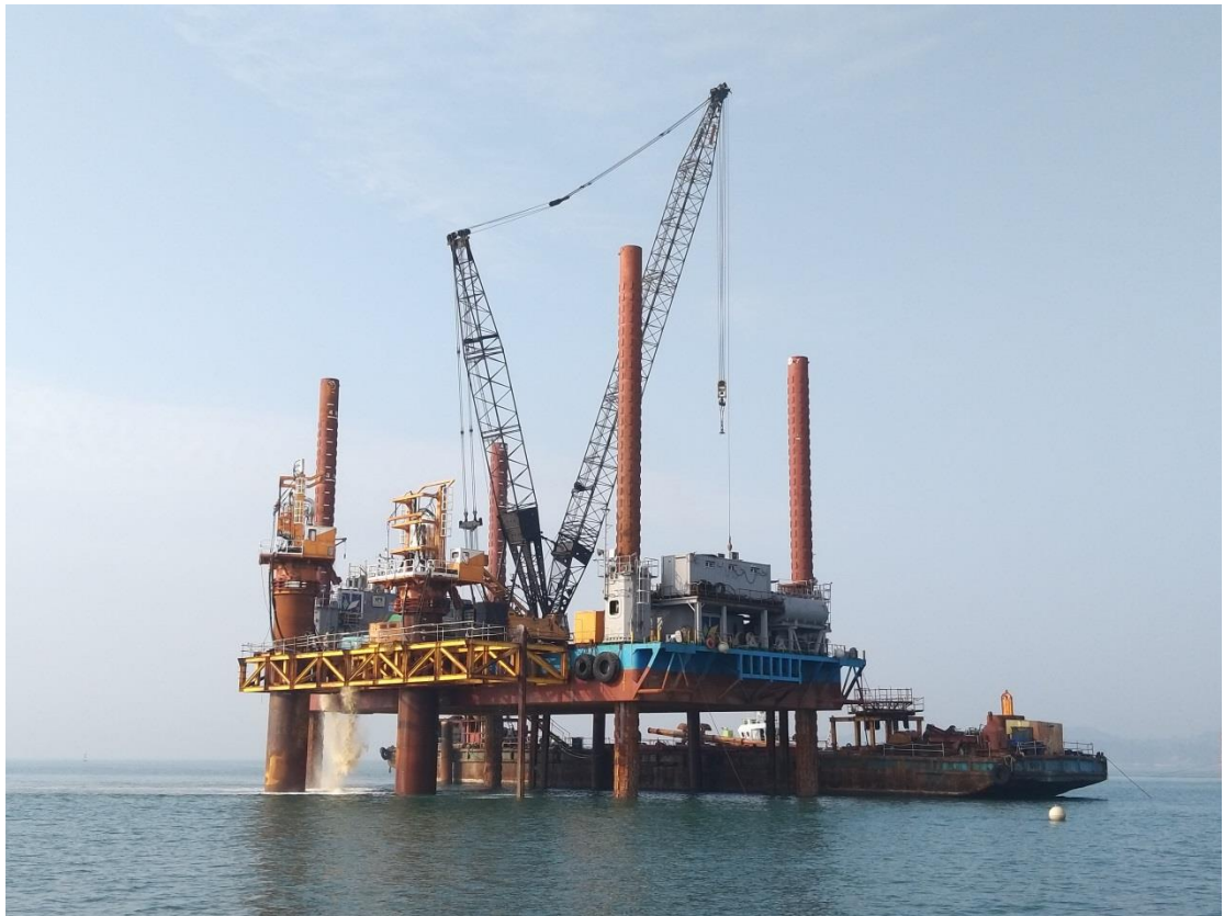
圖 2：P45 基樁鑽掘出渣情形
