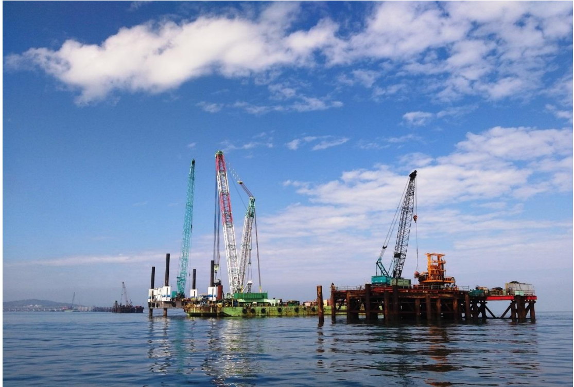
圖 1：P43, 44 基樁鑽掘作業
