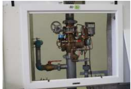
圖 4-58 隧道內消防水加壓幫浦設備
