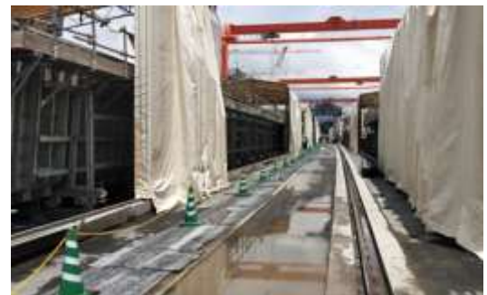
圖 3-49U 型梁預鑄場蒸氣養生設備
