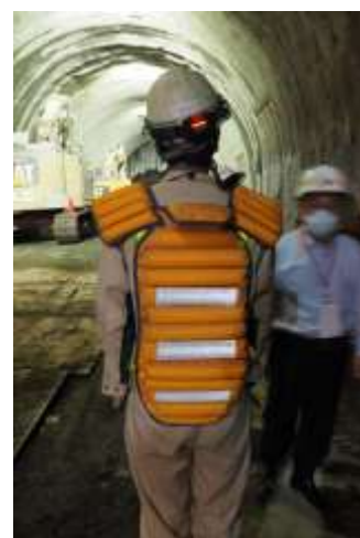
圖 3-64 隧道開挖最前端施工人員 加裝防止落石墜落保護背心
