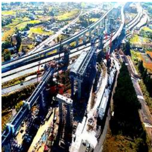
圖 3-50 跨越高速公路吊裝鋼梁前、後工程現況
