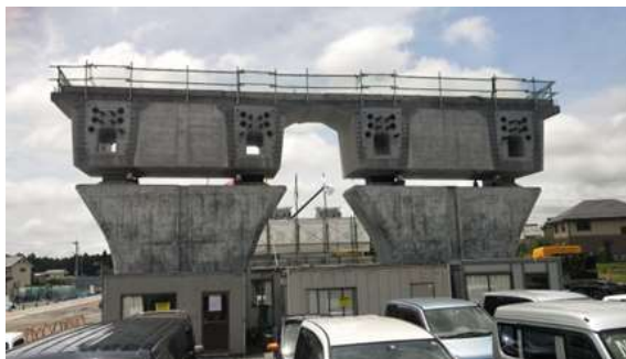
圖 3-48 型梁敦柱柱頭節塊施工情形
