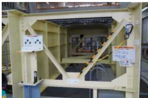
圖 4-53 報廢箱型梁橋梁結構
