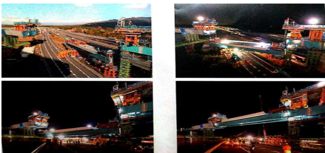
圖 3-52 跨越高速公路鋼梁吊裝施工情形
