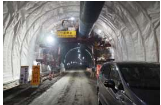
圖 3-60 隧道施工襯體防水膜施工情形
