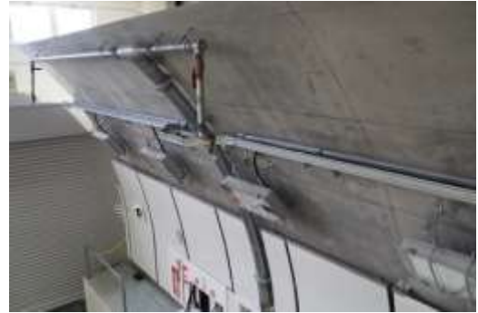
圖 3-17 隧道模型上方襯體、照明及管線設備
