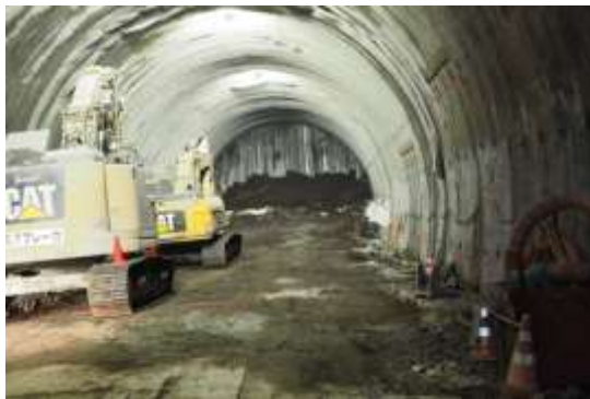
圖 3-59 隧道內施工開挖情形
