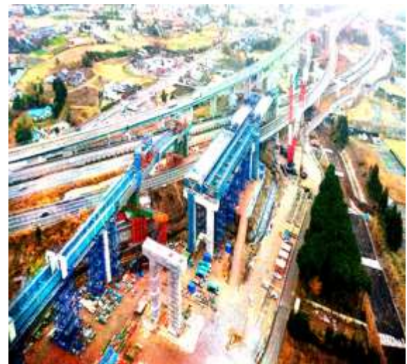
圖 3-50 跨越高速公路吊裝鋼梁前、後工程現況
