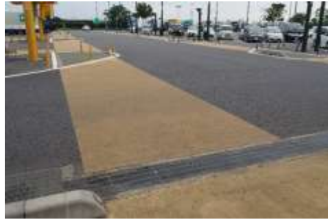
圖 4-74 彩色水泥與瀝青混凝土上之半剛性鋪面
