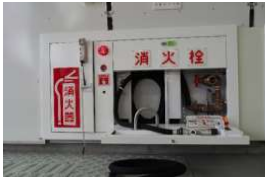
圖 4-57 隧道內消防栓設備
