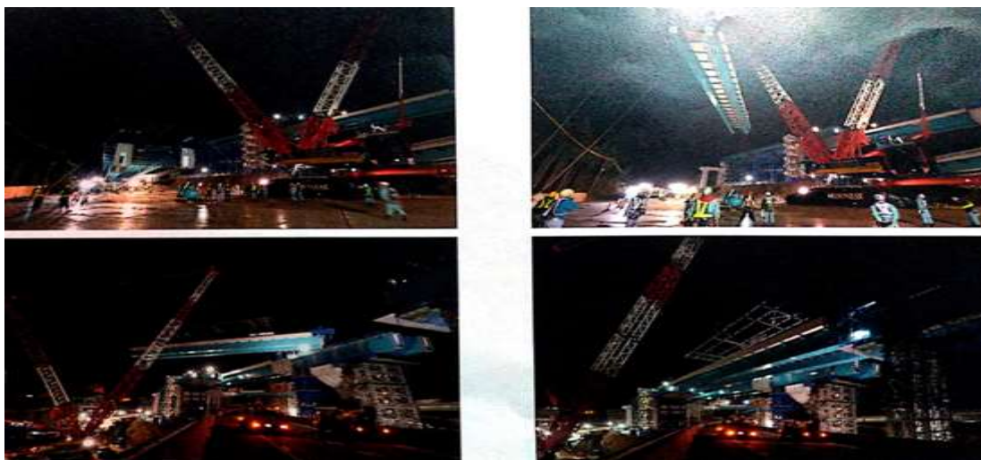
圖 3-51 跨越高速公路鋼梁吊裝前夜間起重機施工情形
