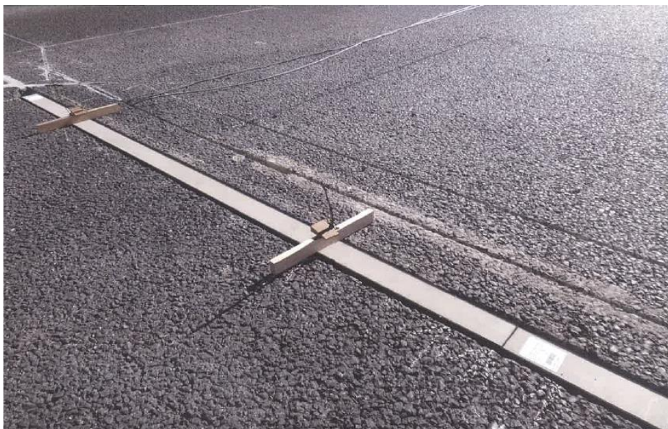
圖 3-3-19 動態地磅施工中狀況
