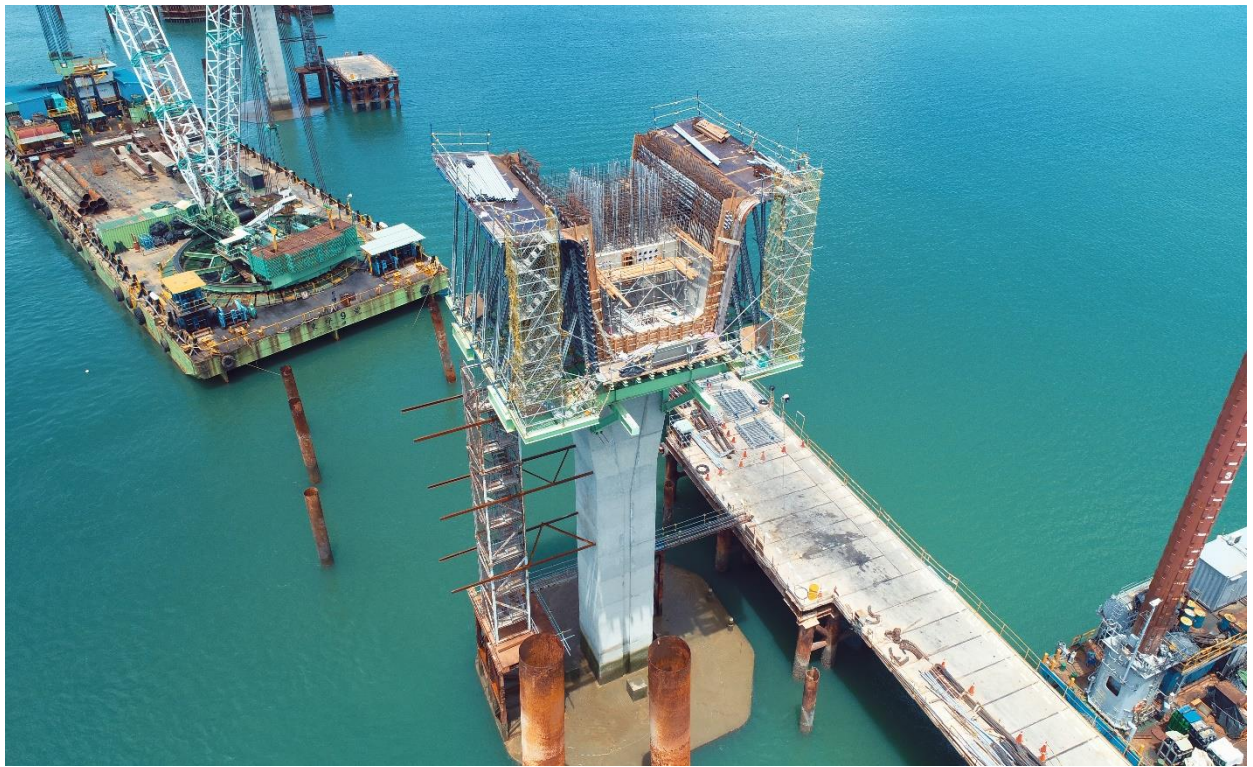
P51 墩柱柱頭版施工
