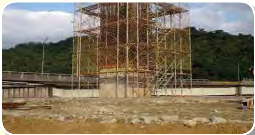
大華系統交流道工程－EP14 樁基礎墩柱搭設施工架鋼筋綁紮作業
