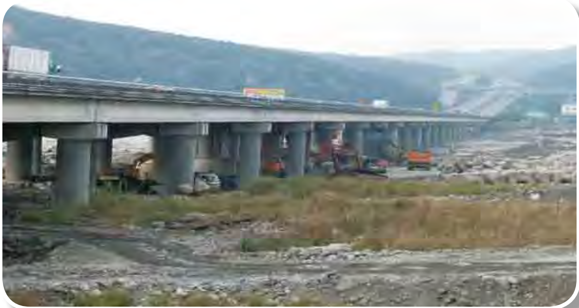
第 M15A 標烏溪橋耐震補強鋼鈑包覆
