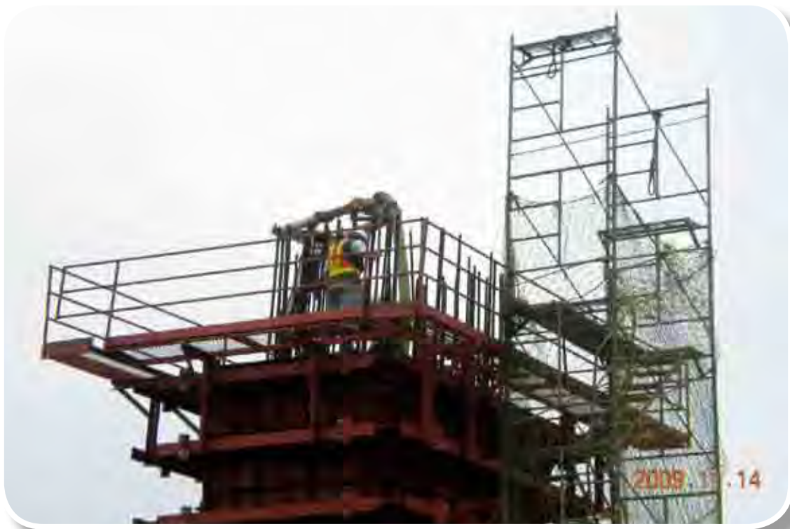
第 H21A 標墩柱灌漿作業
