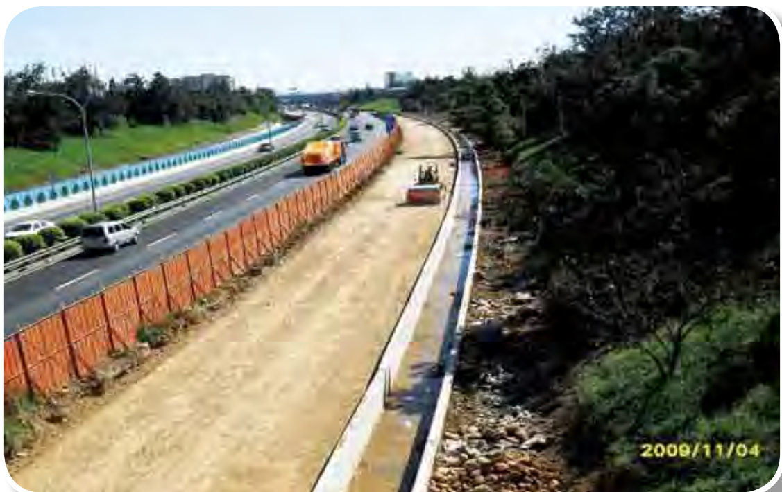
第 H21B 標東行線路堤填築
