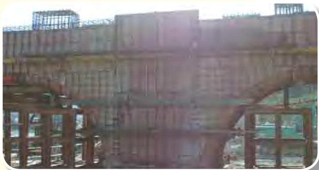
大華系統交流道工程－H2P6 帽樑鋼模組立作業
