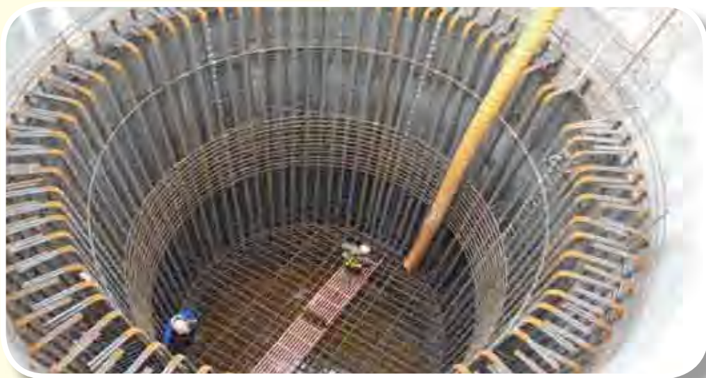
大華系統交流道工程－EP8 井筒式基礎筒身鋼筋綁紮作業
