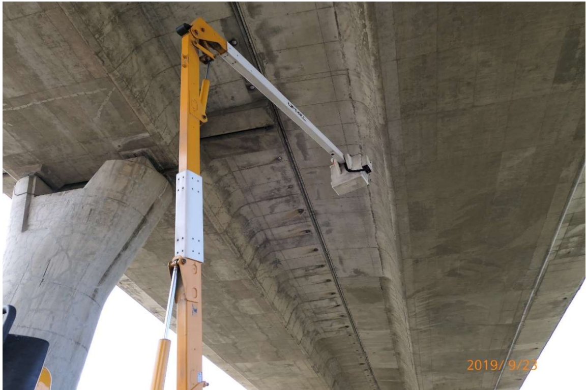
圖 2.4-8 利用高空作業車進行橋梁檢測作業情形
