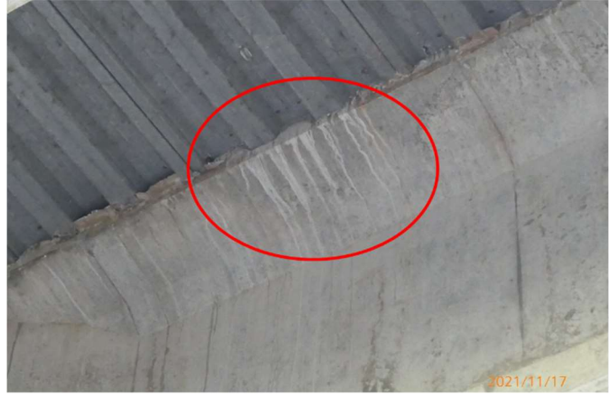
圖 3.2-3 混凝土表面殘留之漿體
