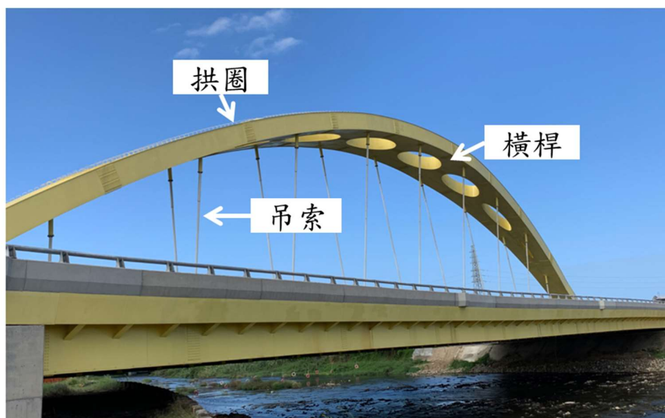
圖 3.4-5 國 2 甲鋼拱橋檢測構件位置示意圖
