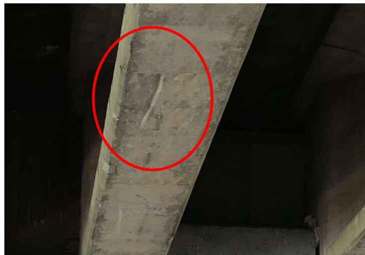
圖 3.2-5 PCI 梁底部輕微波浪狀
