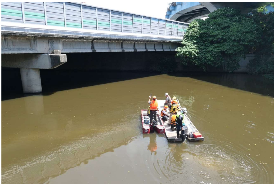
圖 2.4-7 跨河橋梁利用橡皮艇進行橋梁檢測作業情形
