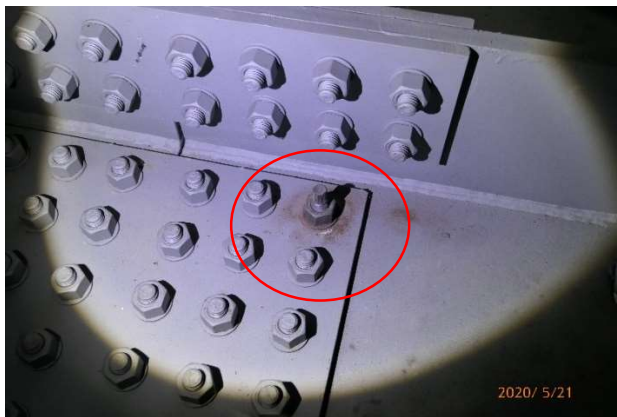
圖 3.2-4 扭力螺栓未斷尾及焊道瑕疵
