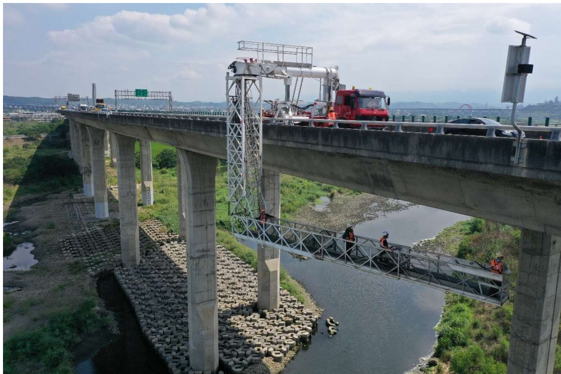
圖 2.4-9 利用橋梁檢測車進行橋梁檢測作業情形
