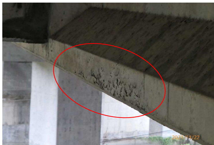
圖 3.2-1 混凝土澆置不良之瑕疵
