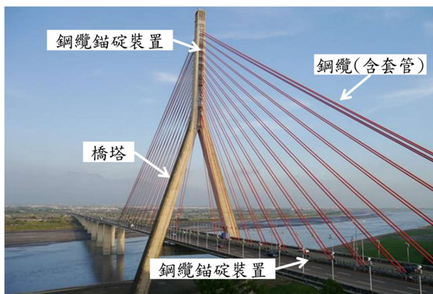
圖 3.4-3 高屏溪斜張橋檢測構件位置示意圖
