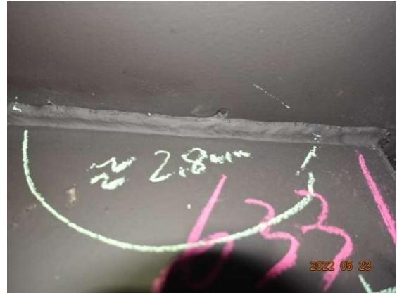
圖 3.2-4 扭力螺栓未斷尾及焊道瑕疵
