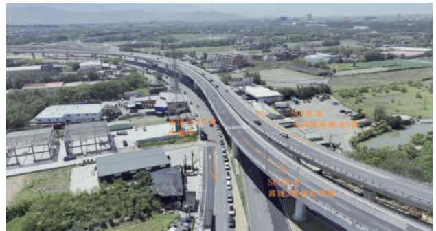
圖 2.148 第 336 標 國道 3 號大溪交流道系統匝道 (省道 112 甲線)
