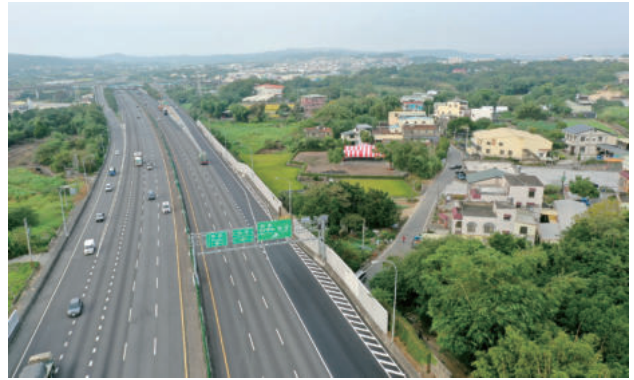
圖 3.10 國道 1 號銅鑼交流道北上出口多孔隙瀝青混凝土路面更新及排水調整
