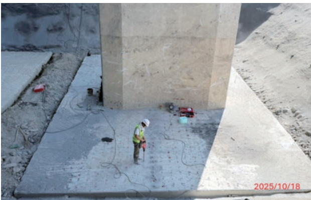
圖 2.126 第 M61 標 牛眠高架橋 P29 墩柱基礎補強植筋鑽孔
