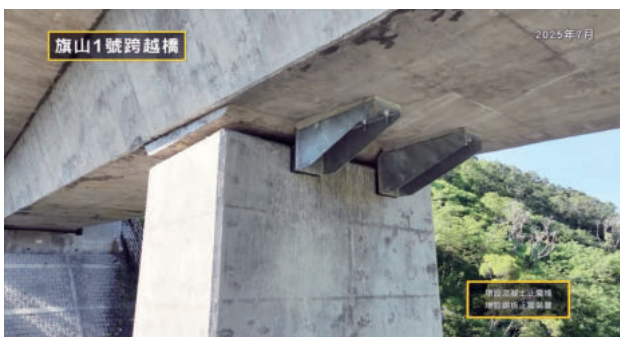
圖 2.151 第 M38G 標 國道 10 號旗山 1 號跨越橋增設鋼止震完成
