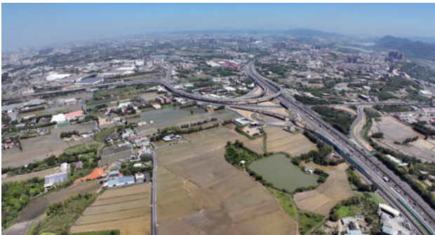
圖 2.145 第 336 標 施工全景圖 (2)
