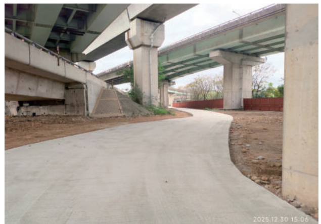
圖 2.87 第 I211S 標 第一工區第 2 出入口施工便道
