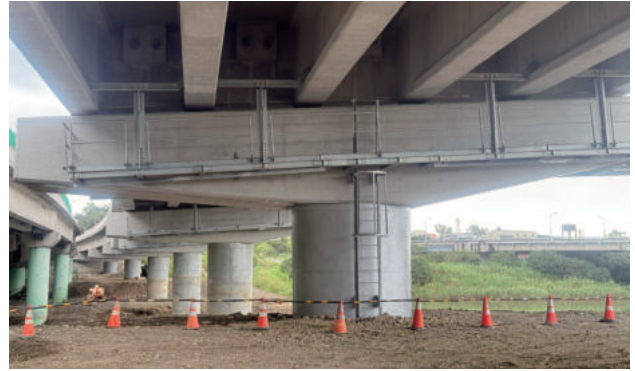
圖 2.141 第 B102S 標 橋梁檢修平臺
