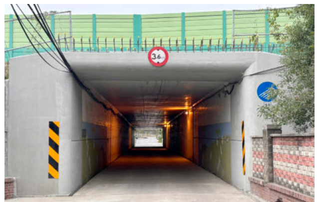
圖 2.73 第 I109R 標 北上側禮蘭路箱涵延伸作業
