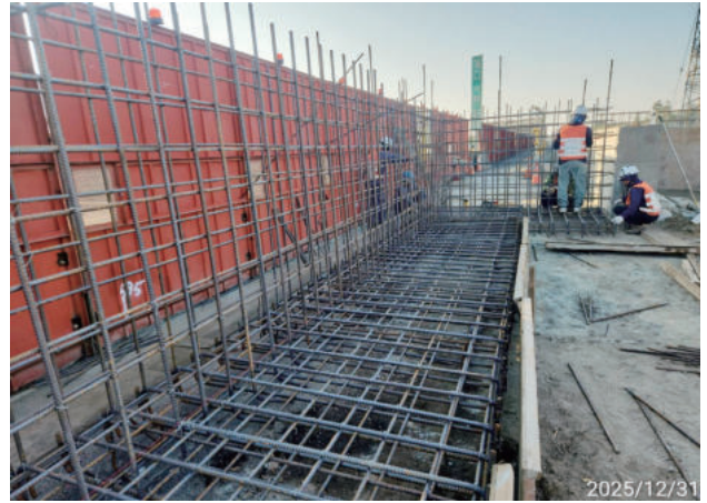
圖 2.49 國道 1 號石龜溪橋改善工程 南下線臨時 L 型擋土牆鋼筋綁紮
