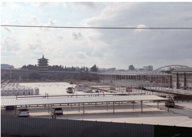
圖 2.109 第 X005X 標工地辦公室及工地實驗室建置
