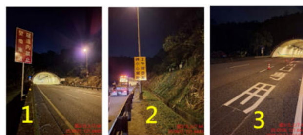
圖 5.9 國道 3 號南向瑪東系統至汐止系統路段，延長最外車道出口專用範圍；隧道前增設「上午常壅塞 / 請小心駕駛」黃底黑字標誌；CMS 加強宣導「前方外線壅塞 / 請小心駕駛」
