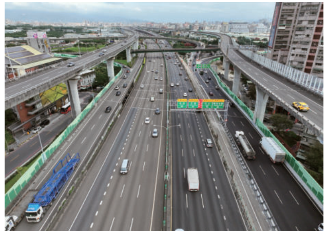
圖 2.37 第 103S 標 成泰橋拓寬完成
