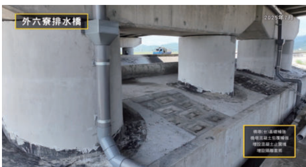
圖 2.155 第 M38G 標 國道 10 號外六寮排水橋墩柱包覆完成
