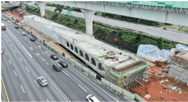
圖 2.41 第 I104S 標 林口 A 匝道北出車行箱涵施作完成
