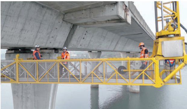
圖 3.3 橋梁檢測作業 1 - 橋檢車檢測
