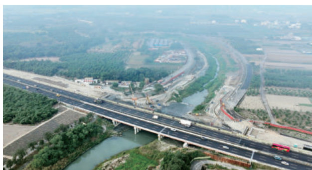
圖 2.56 國道 1 號石龜溪橋改善工程 石龜溪橋河中段
