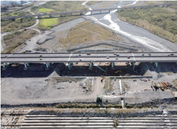
圖 2.113 第 M18A 標 大安溪北岸 P13 ~ P16 圍水圍堤施工
