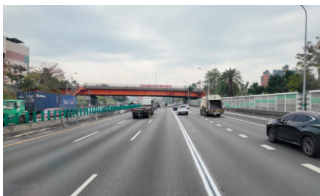
圖 5.6 國道 1 號南向鼎金系統入口路段於入口槽化線尖端 (南向 363k+240) 劃設雙白實線 100 公尺
