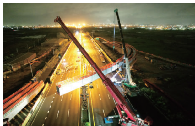
圖 2.58 第 I105S 標 L1U5 鋼橋吊裝
