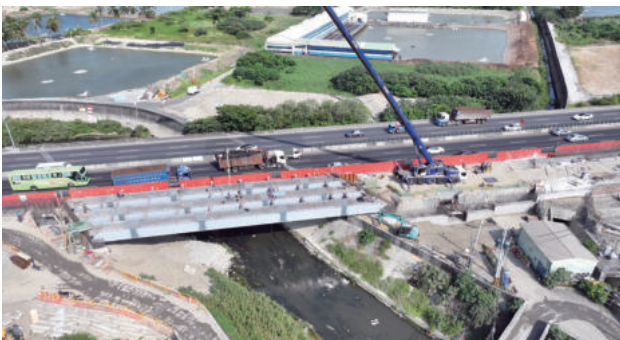
圖 2.66 第 B103 標 南下線鋼箱梁安裝
