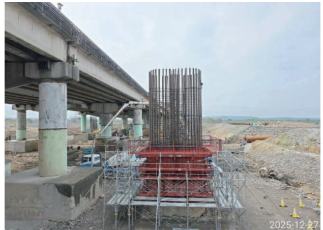
圖 2.116 第 M18A 標 大安溪橋墩柱施工
