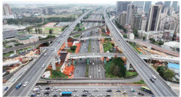
圖 2.42 第 I104S 標 國道 1 號跨主線段鋼橋吊裝完成
