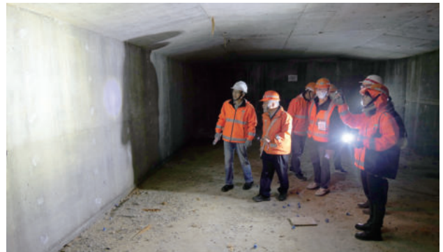
圖 3.4 橋梁檢測作業 2 - 箱型梁內部檢測
