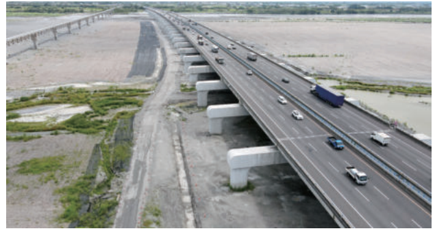
圖 2.135 第 M16 標 中沙大橋完工 (2)
