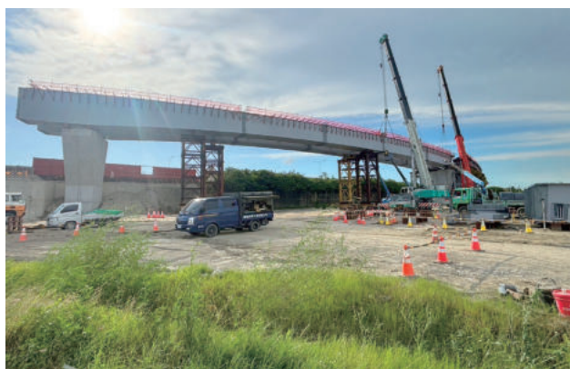
圖 2.61 第 I105S 標 L1P16 ~ L1P17 鋼箱梁吊裝作業
