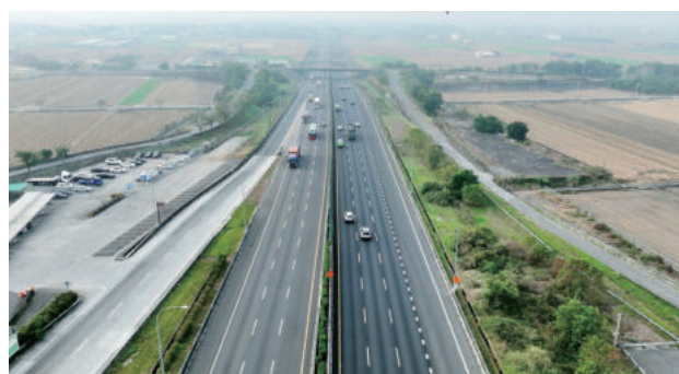
圖 2.57 國道 1 號石龜溪橋改善工程 石龜溪橋橋南段
