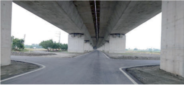
圖 2.157 第 M38F3 標 國道 3 號高屏溪河川橋竣工 - AC 道路復舊、標示界樁設置 (1)
