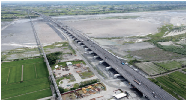
圖 2.134 第 M16 標 中沙大橋完工 (1)
