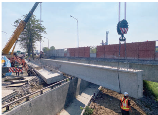
圖 2.64 第 I105S 標 R6 匝道 PCI 梁吊裝作業
