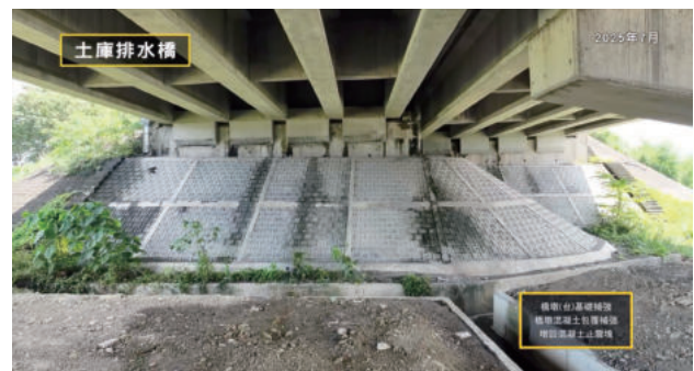
圖 2.154 第 M38G 標 國道 10 號土庫排水橋增設混凝土止震塊完成
