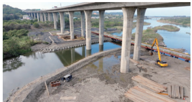
圖 2.117 第 M39A 標 後龍一號高架橋 P65R 施工情形
