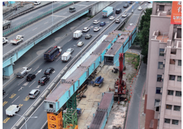
圖 2.31 第 103S 標 五股交流道增設北入匝道橋 NP06 鋼梁
