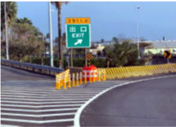
圖 5.20 國道 3 號九如南出匝道島頭改善
