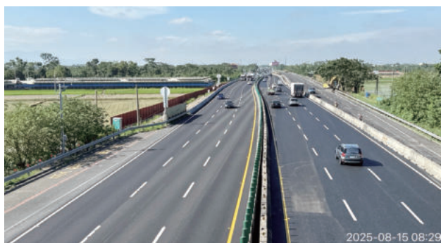
圖 2.54 國道 1 號石龜溪橋改善工程 新北上線改道後
