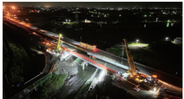
圖 2.65 第 B103 標 南下線鋼箱梁吊裝
