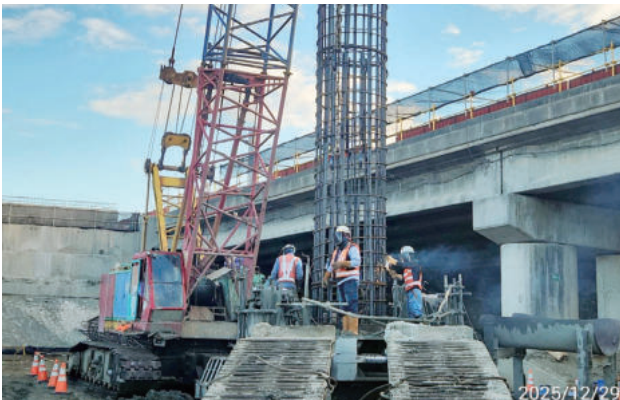
圖 2.52 國道 1 號石龜溪橋改善工程 南下線 P1R 全套管基樁施作
