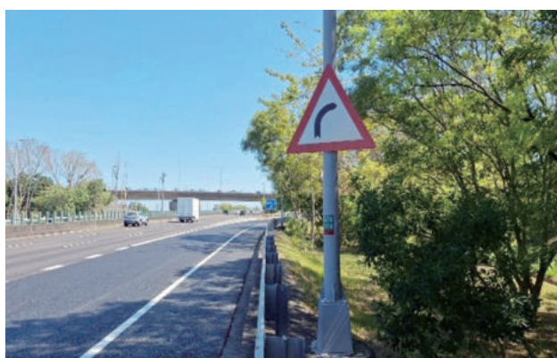
圖 5.8 國道 3 號往東山服務區北向出口匝道
