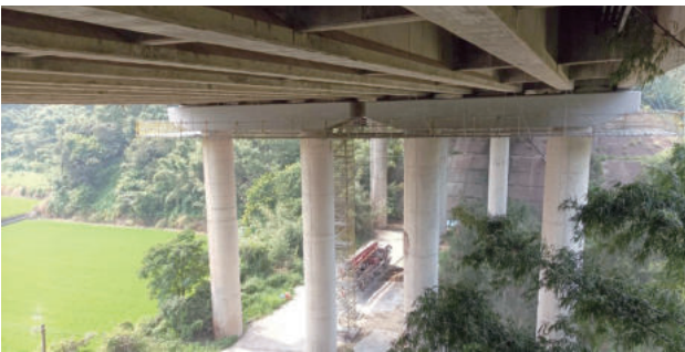
圖 2.122 第 M39A 標 通霄二號高架橋 P2 帽梁完成現況
