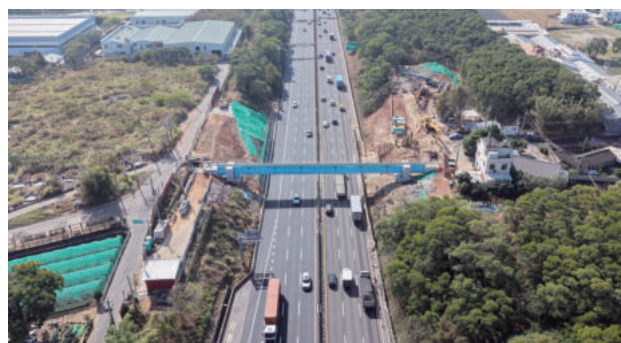
圖 2.77 第 B104S 標 施工中之舊社路跨越橋
