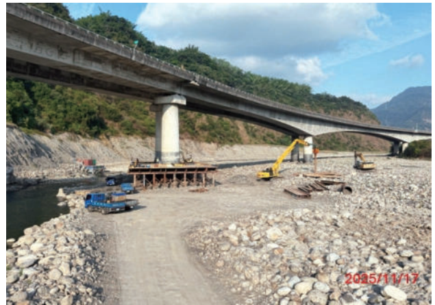
圖 2.133 第 M61 標 雙冬高架橋 P3 施工便道及鋼便橋施工
