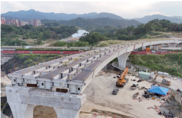
圖 2.88 第 I306S 標 主線鋼箱梁 L3B02 吊裝
