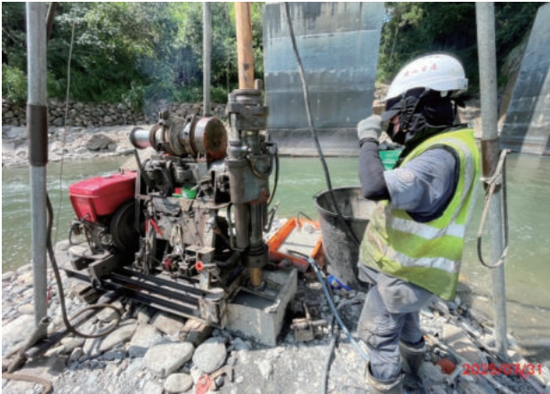
圖 2.130 第 M61 標 河曲高架橋補充地質鑽探
