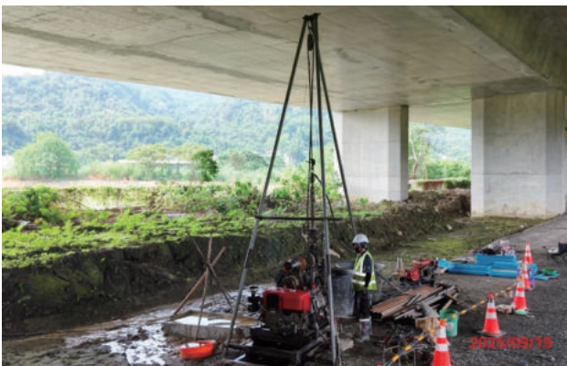
圖 2.128 第 M61 標 南港溪橋補充地質鑽探
