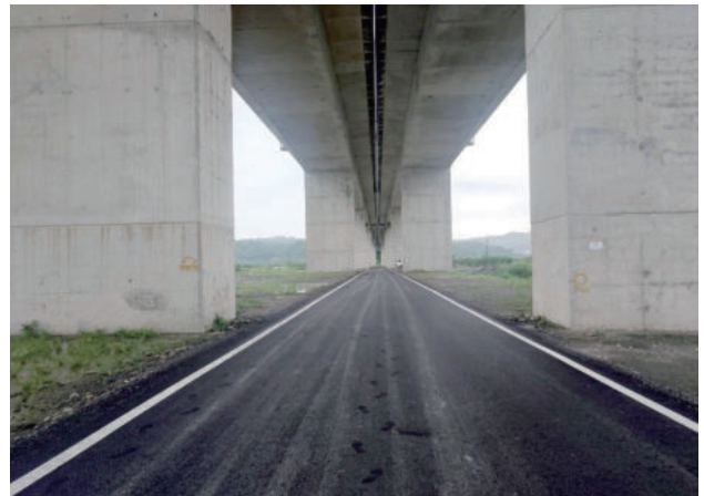
圖 2.160 第 M38F3 標 國道 3 號高屏溪河川橋竣工 - AC 道路復舊、標示界樁設置 (4)
