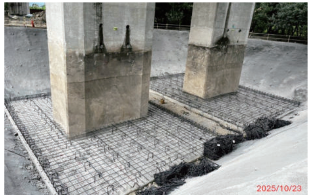
圖 2.127 第 M61 標 牛眠高架橋 P29 墩柱基礎補強鋼筋組立及植筋
