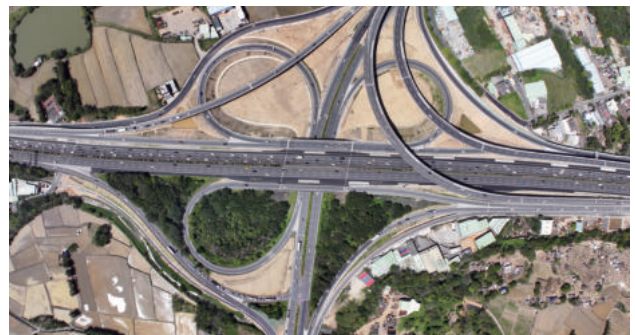
圖 2.150 第 336 標 國道 3 號大溪交流道匝環道區鳥瞰
