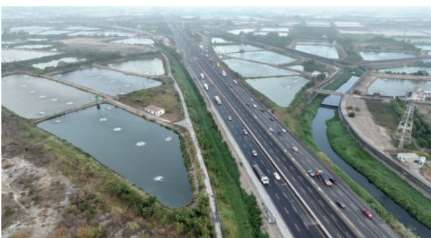
圖 2.68 第 B103 標 第 3 階段 (僅南下線) 交維改道完成
