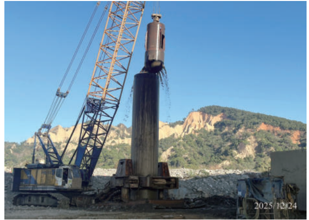
圖 2.114 第 M18A 標 大安溪橋全套管基樁施工
