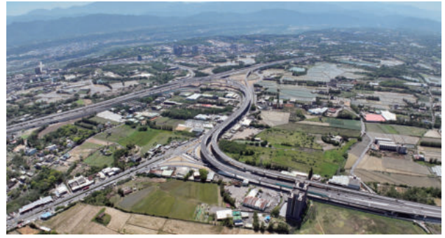
圖 2.144 第 336 標 施工全景圖 (1)
