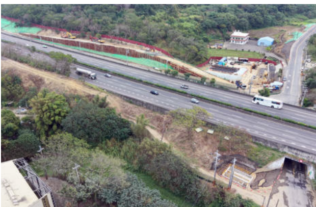
圖 2.72 第 I109R 標 北上側擋土排樁施作
