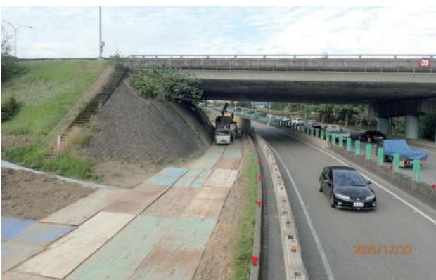
圖 2.28 第 I107SA 標 R3 圍籬設置
