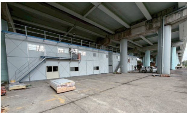
圖 2.26 第 I107SA 標 監造及督導工務所辦公室建置
