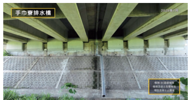
圖 2.156 第 M38G 標 國道 10 號手巾寮排水橋增設混凝土止震塊完成
