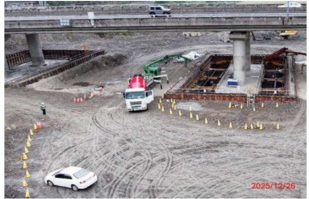
圖 2.125 第 M61 標 眉溪橋 P4 墩柱基礎補強混凝土澆置
