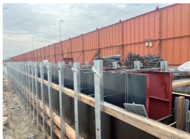
圖 2.95 第 I810R 標 DU5302 排水溝模板組立作業
