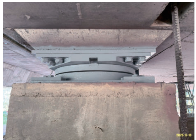
圖 2.121 第 M39A 標 苑裡高架橋 P16R 盤式支承油漆塗裝
