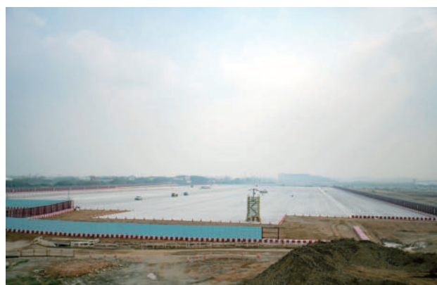
圖 2.105 第 X002X 標 臨時過夜機坪工程道面工程施工
