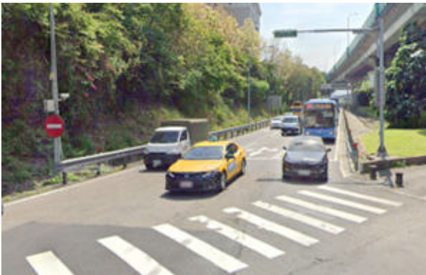
圖 5.10 國道 1 號內湖 B 南出匝道：禁止進入、地面停止線及指向線、反光導標等設施
