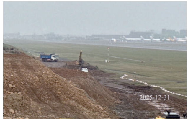
圖 2.108 第 X005X 標機場空側 N4 堆土區土方整理搬運
