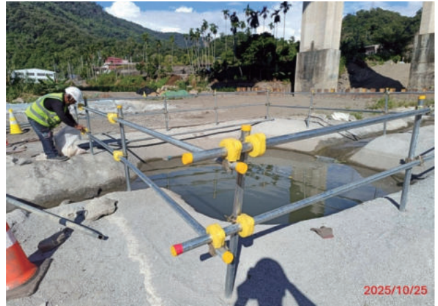
圖 2.131 第 M61 標 河曲高架橋簡易水保及護欄施工
