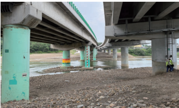
圖 2.142 第 B102S 標 完工後中港溪水水位情形
