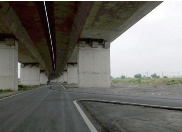
圖 2.159 第 M38F3 標 國道 3 號高屏溪河川橋竣工 - AC 道路復舊、標示界樁設置 (3)
