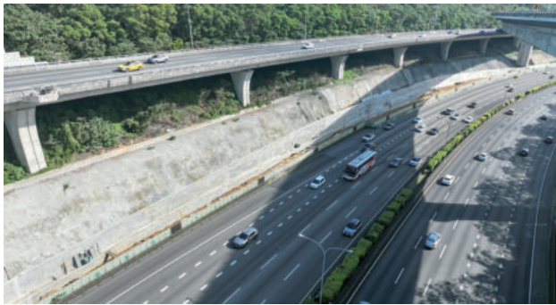
圖 2.39 第 I104S 標 國道 1 號主線南下擋土牆及排水結構物施作
