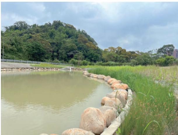
圖 3.17 木柵交流道綠美化成果 (左圖) 池畔栽植原生水生植物綠化成效良好 (右圖) 雨水儲留池擴大增加強降雨儲留量
