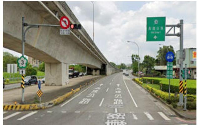
圖 5.11 國道 3 號安坑北入匝道，設置國道路線編號、行車方向指示、地面標字及「遵 23」等設施
