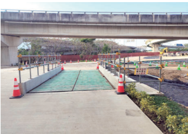
圖 2.86 第 I211S 標 第一工區第 2 出入口洗車臺
