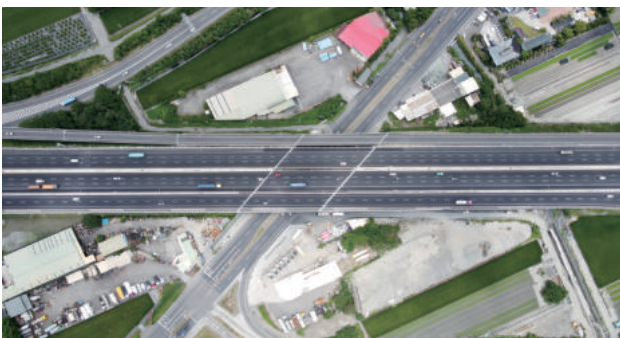
圖 2.138 第 M16 標 西螺交流道穿越橋完工 (2)
