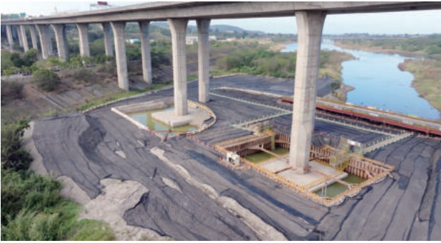
圖 2.118 第 M39A 標 後龍一號高架橋 P67L 施工情形
