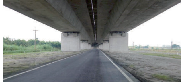
圖 2.158 第 M38F3 標 國道 3 號高屏溪河川橋竣工 - AC 道路復舊、標示界樁設置 (2)
