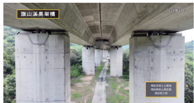
圖 2.152 第 M38G 標 國道 10 號旗山高架橋增設剪力樁完成
