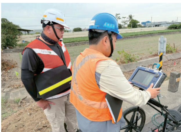
圖 2.94 第 I810R 標 地下管線透地雷達探測
