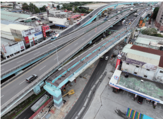
圖 2.32 第 103S 標 五股交流道增設北入匝道橋 NP04 ~ NP05 鋼梁
