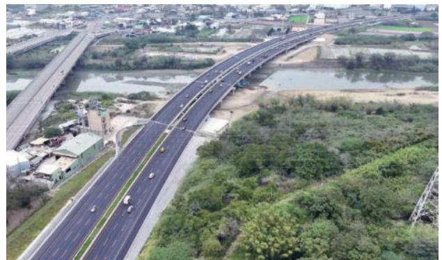
圖 2.143 第 B102S 標 整體竣工
