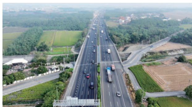
圖 2.55 國道 1 號石龜溪橋改善工程 石龜溪橋橋北段
