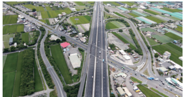
圖 2.137 第 M16 標 西螺交流道穿越橋完工 (1)
