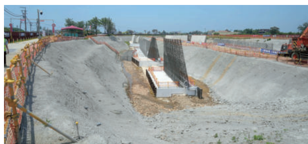
圖 2.103 第 X002X 標 埔心溪改道工程新建護岸擋土牆作業
