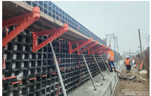
圖 2.51 國道 1 號石龜溪橋改善工程 南下線北側永久擋土牆施作
