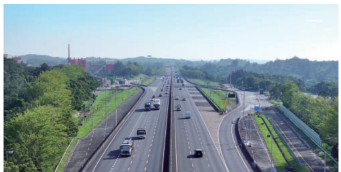
圖 3.18 國道 3 號後龍地磅站
