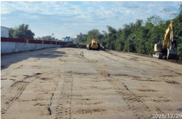
圖 2.50 國道 1 號石龜溪橋改善工程 南下線南側抬高段路堤填築及滾壓
