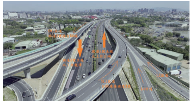
圖 2.146 第 336 標 國道 3 號大溪交流道北入及南出系統匝道銜接國道 3 號主線處
