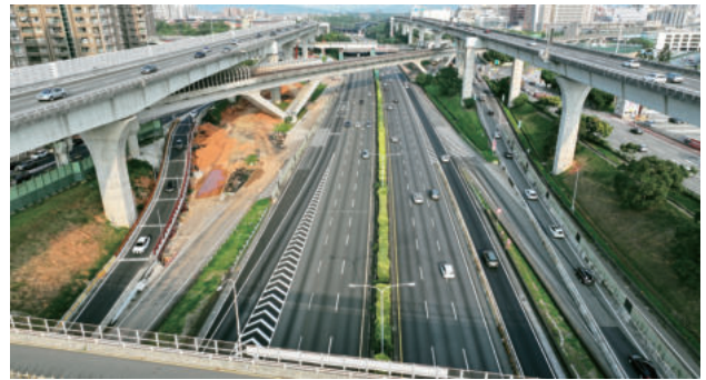
圖 2.40 第 I104S 標 林口 A 南下匝道集散道交織改善工程第四階段交織改道
