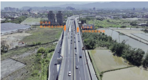
圖 2.149 第 336 標 國道 3 號大溪交流道系統匝道銜接台 66 線快速公路處
