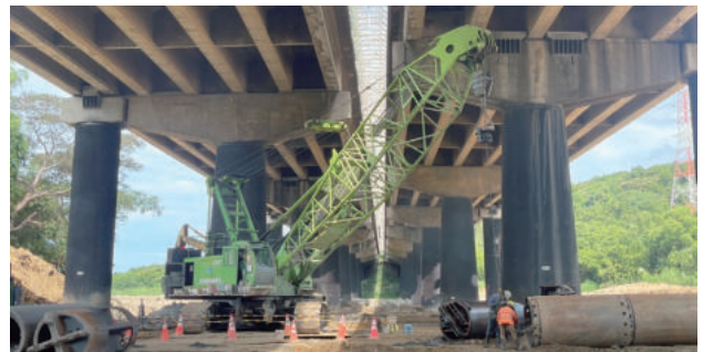
圖 2.123 第 M39A 標 大鳳山溪橋 P8 基樁施工
