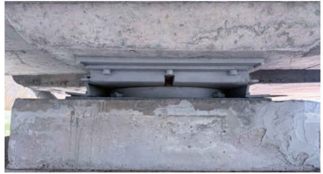
圖 2.119 第 M39A 標 中港溪河川橋 P13L 盤式支承油漆塗裝
