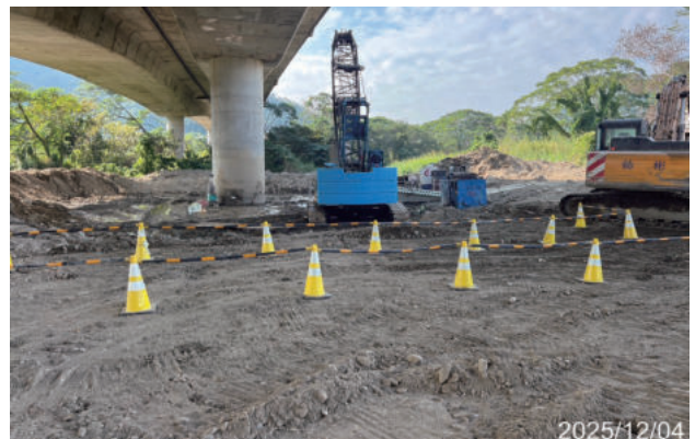
圖 2.129 第 M61 標 南港溪橋 P7 墩柱增設基樁混凝土澆置
