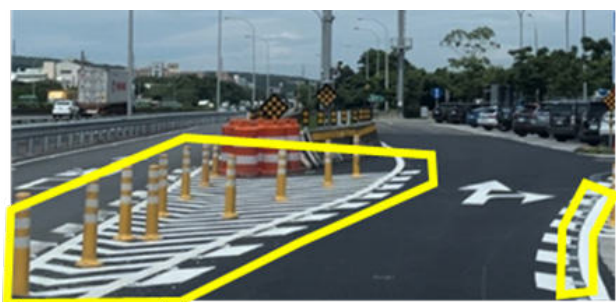
圖 5.4 國道 1 號高架南向楊梅休息站入口匝道，擴大左側槽化區
