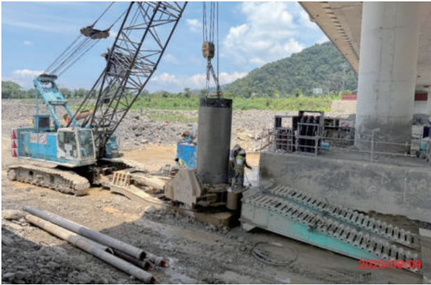
圖 2.124 第 M61 標 眉溪橋 P3 墩柱增設基樁混凝土澆置
