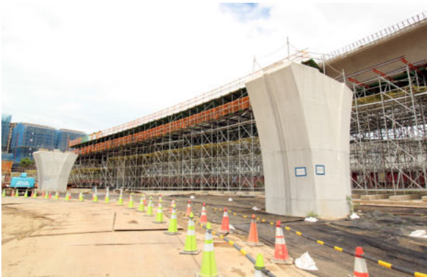
圖 2.90 第 I306S 標 預力箱型梁底 R2B01 腹板施作
