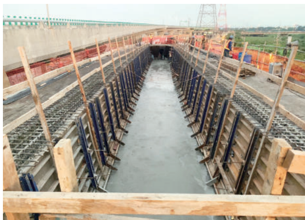
圖 2.63 第 I105S 標 LS05 底腹板澆置
