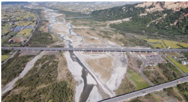
圖 2.111 第 M18A 標 大安溪橋工區往下游側
