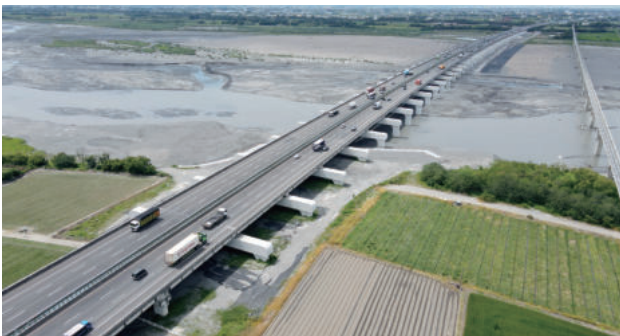
圖 2.136 第 M16 標 中沙大橋完工 (3)
