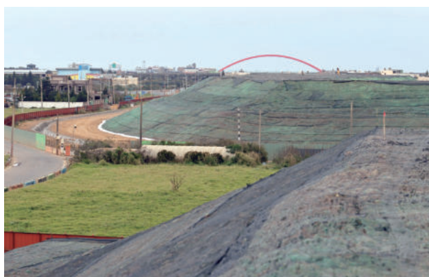
圖 2.104 第 X002X 標 優先整地工程土方填築作業
