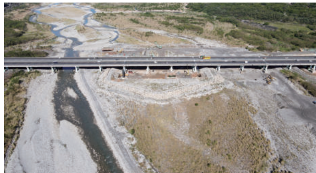
圖 2.112 第 M18A 標 大安溪北岸 P13 ~ P16 圍水圍堤施作
