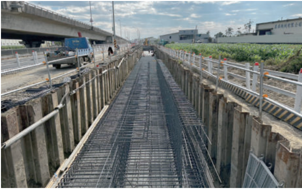
圖 2.96 第 I810R 標 二工區 (0k + 092 - 0k + 189) 擋土牆鋼筋綁紮
