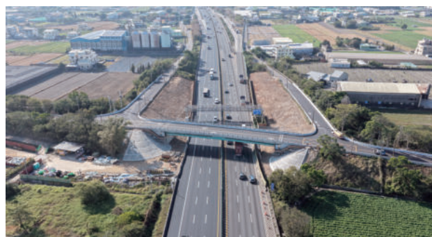
圖 2.75 第 B104S 標 三線路跨越橋完工
