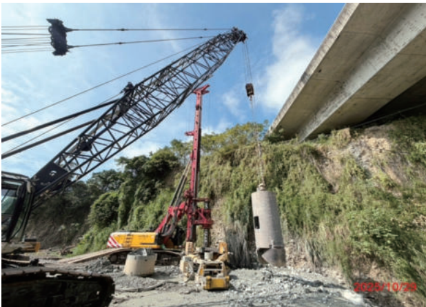
圖 2.132 第 M61 標 雙冬高架橋 A1 橋臺基樁鑽掘施工
