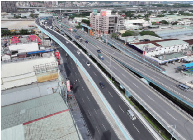
圖 2.30 第 103S 標 五股交流道增設北出匝道先行通車路段
