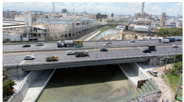
圖 3.5 國道 1 號後勁溪橋新建工程（已於 114 年完工）
