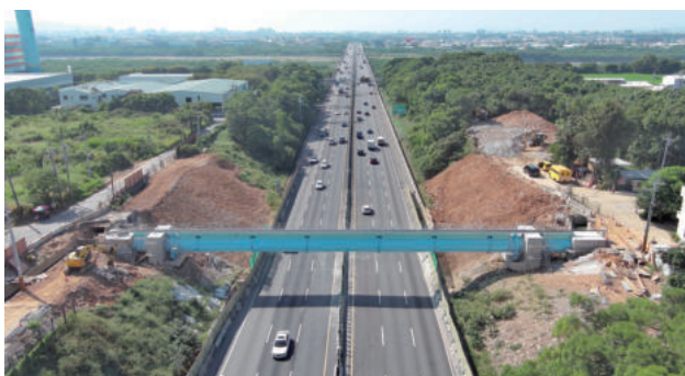
圖 2.76 第 B104S 標 內埔圳水管橋完成
