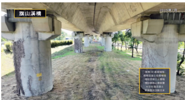
圖 2.153 第 M38G 標 國道 10 號旗山溪橋增設混凝土止震塊完成
