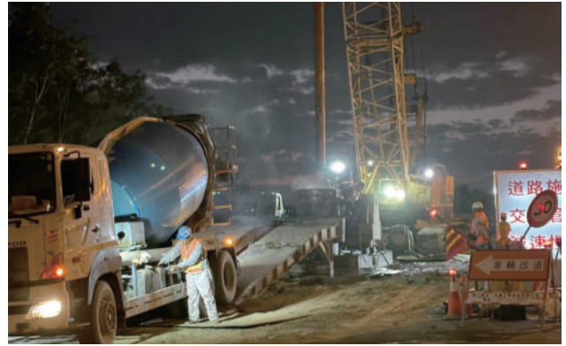
圖 2.97 第 I810R 標 四工區 133ES - P2.8 - 14 全套管基樁澆置作業
