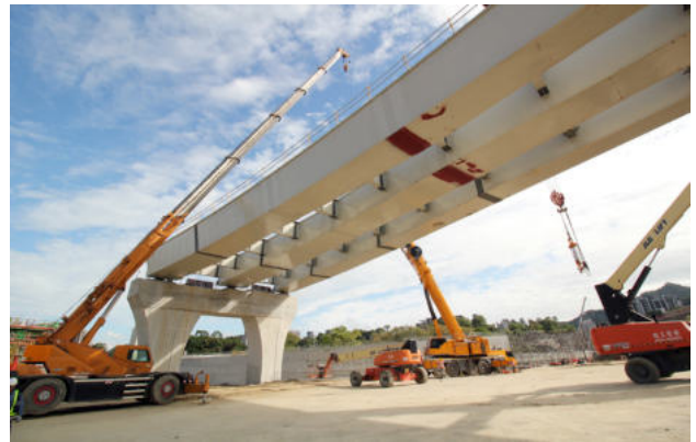
圖 2.89 第 I306S 標 鋼箱梁 L3B01 吊裝
