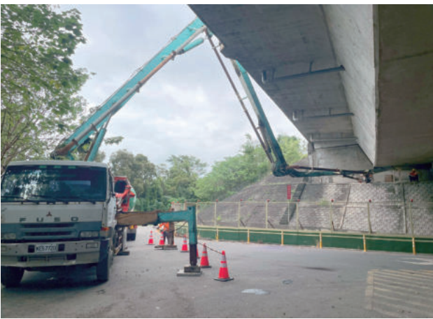
圖 2.120 第 M39A 標 中港溪河川橋 A1 橋臺止震塊混凝土澆置
