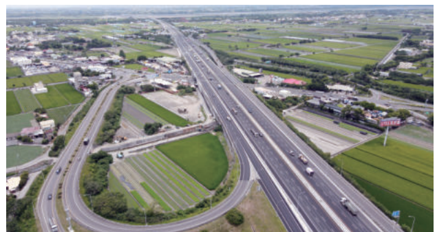
圖 2.139 第 M16 標 西螺交流道穿越橋完工 (3)
