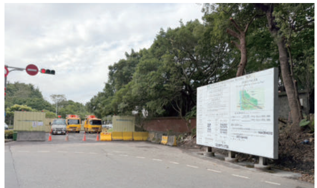
圖 2.27 第 I107SA 標 濱江街林安泰旁工程告示牌
