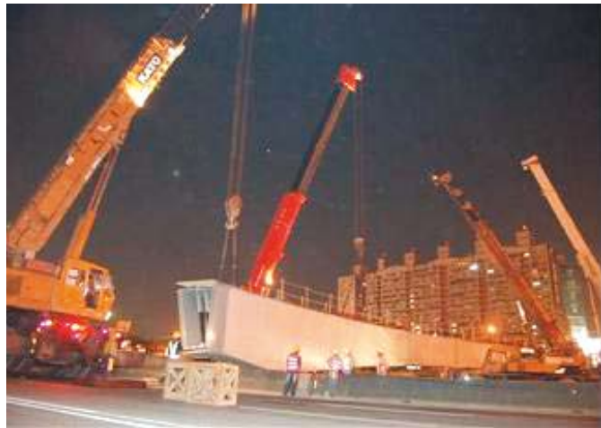
第204標—夜間施作單元C—01箱梁跨越新五路吊裝作業
