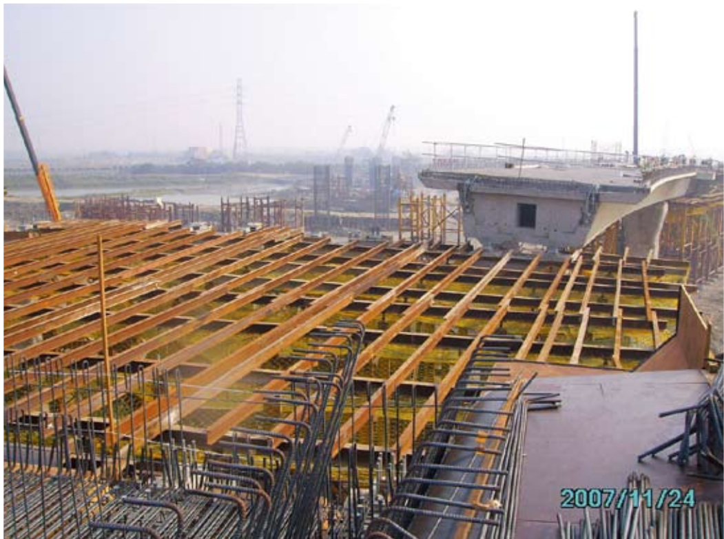
國道 1 號銜接路竹科園區新增交流道工程—橋面板施工
