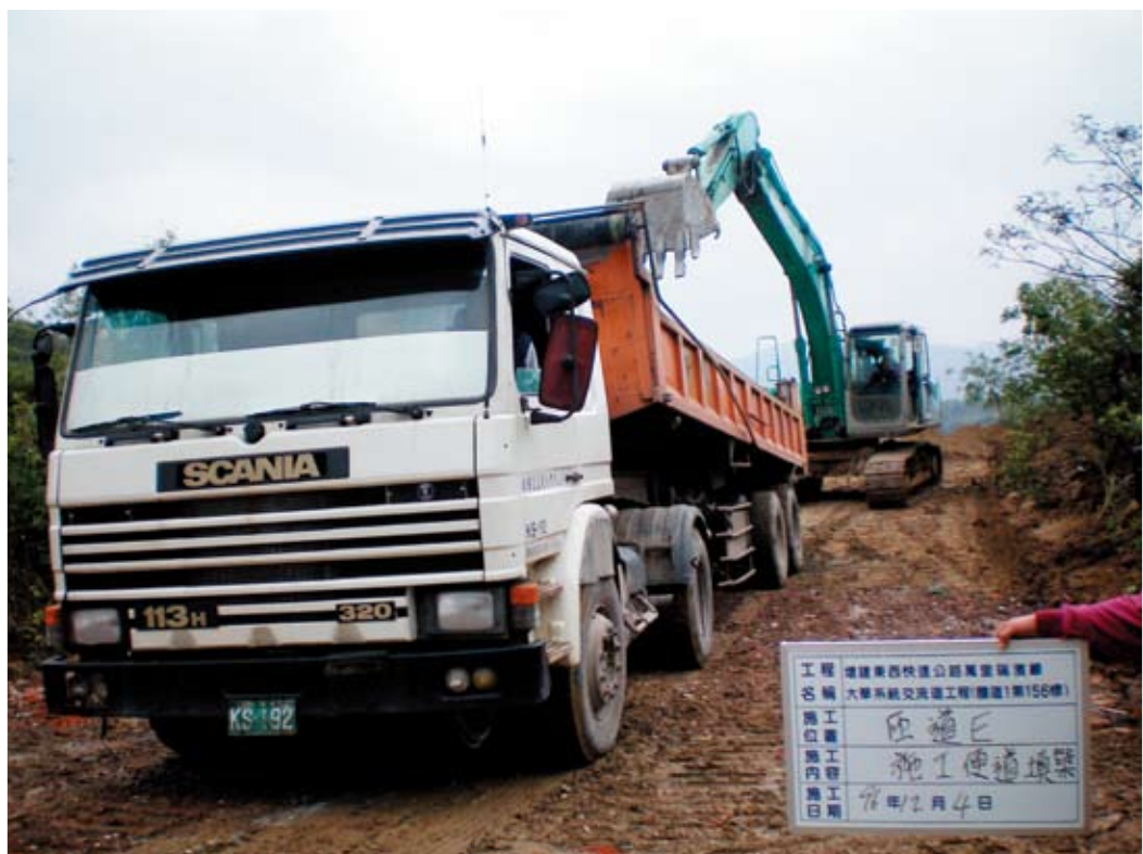
大華系統交流道工程—施工便道開挖作業
