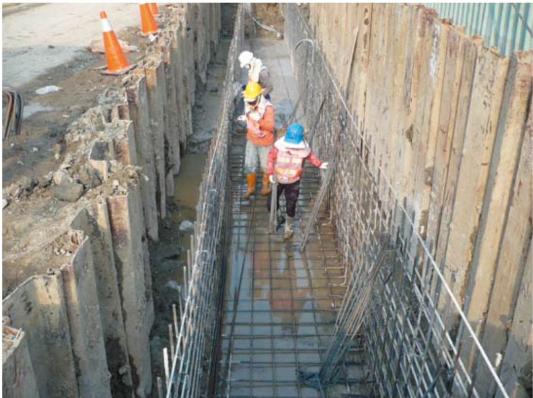
鼎金系統交流道增設南下右轉高架銜接國道10號匝道工程—擋土牆施工
