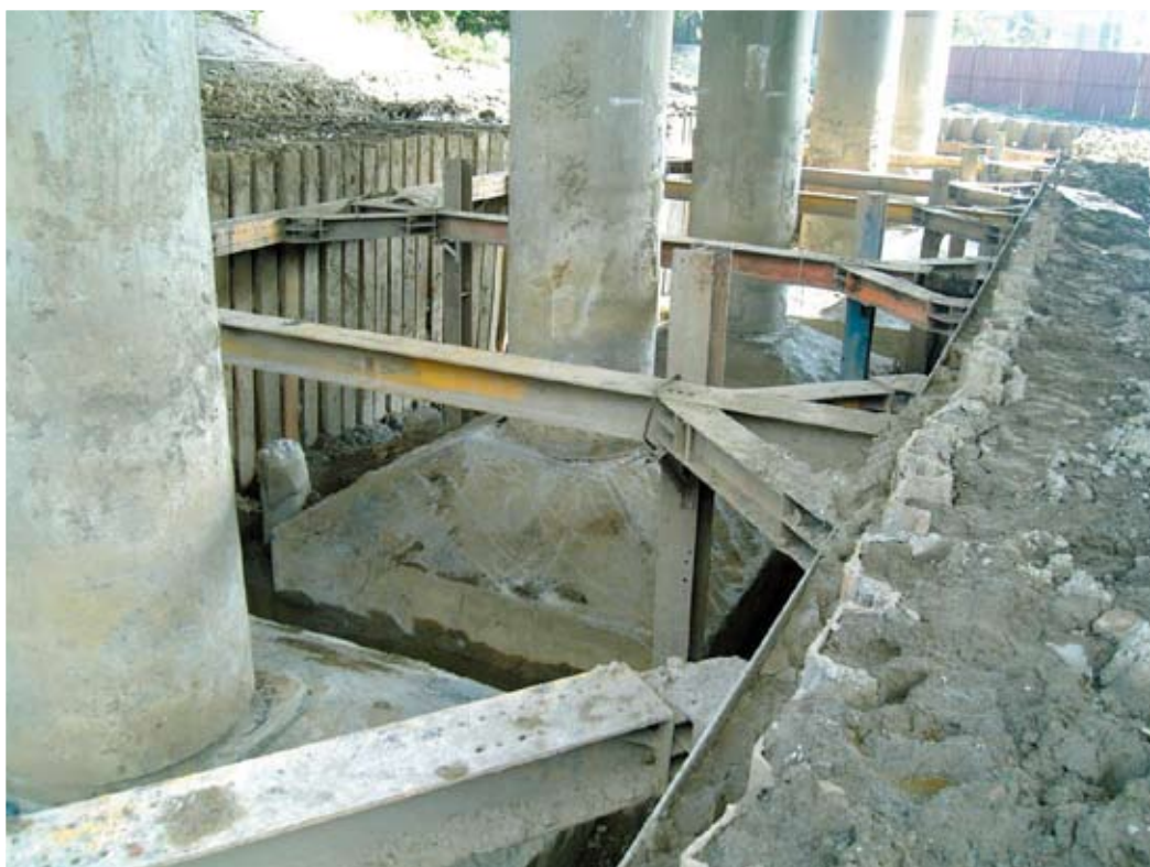
橋梁耐震補強工程—橋梁基礎補強開挖
