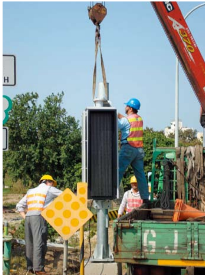
交控系統工程—匝道儀控安裝
