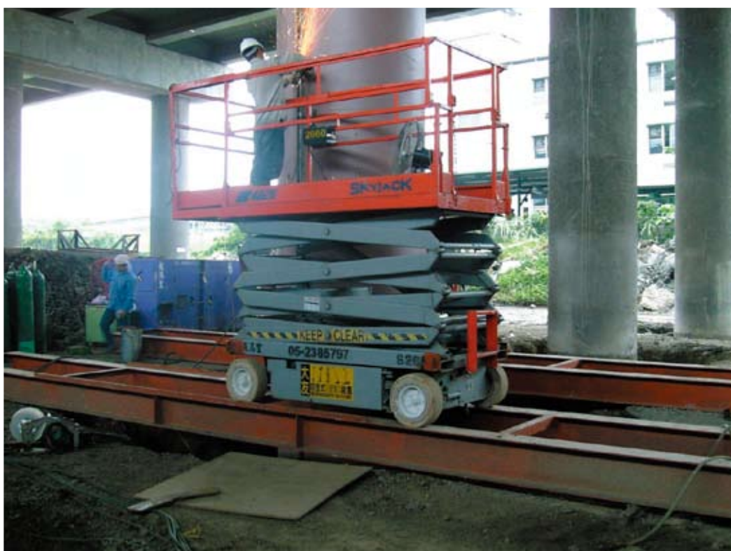
橋梁耐震補強工程—橋梁墩柱鋼鈹包覆
