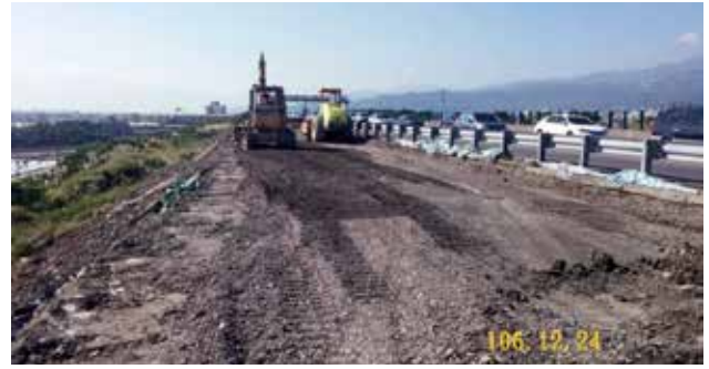
第 E14 標 L1 匝道第 1 區路堤填築
