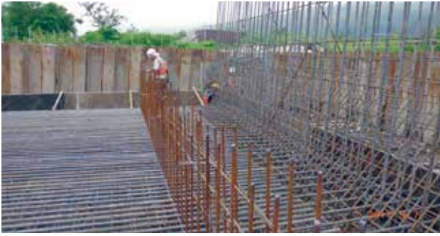
第 E14 標 R1 匝道穿越箱涵底板鋼筋綁紮
