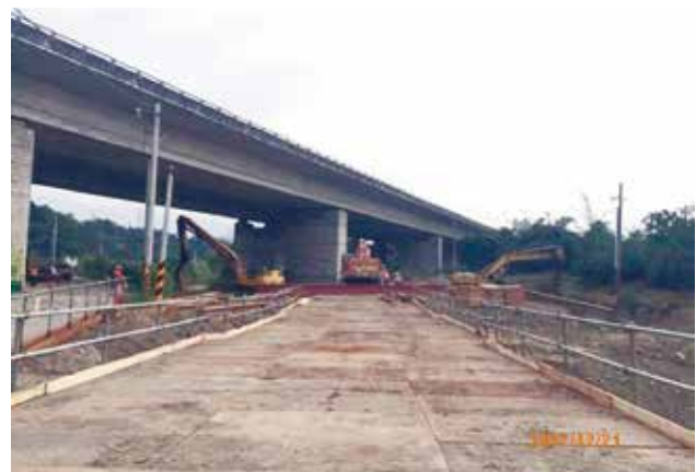
第 M37A 標 崙子溪河川橋便橋打設及 P5 圍堰
