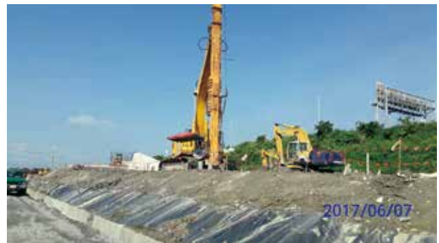
第 E14 標 L1 匝道排水帶工法打設排水帶
