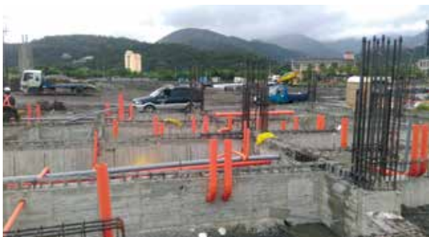
第 E251 標 西側廁所地梁排水管安裝
