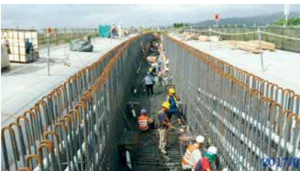
第 E14 標 L1 穿越橋箱型梁腹板鋼筋綁紮
