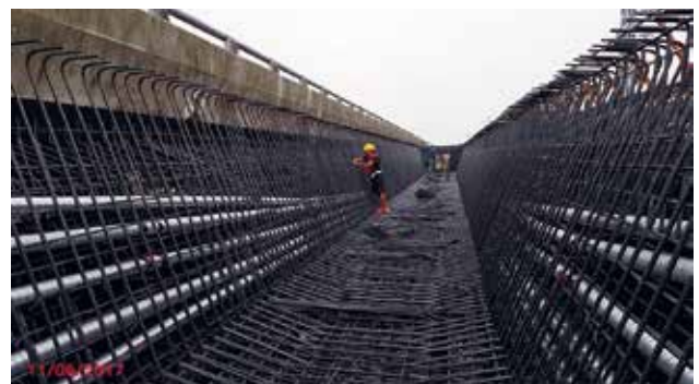
第 D44 標 鹽埔交流道北入匝道 PN1~PN3 箱型梁牆身及翼版鋼筋綁紮作業
