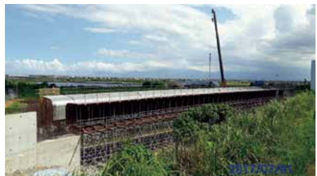
第 E14 標 L1 穿越橋箱型梁腹版模吊裝
