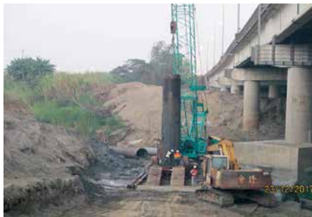
第 M37B 標 龜重溪河川橋 TP4 試驗樁施工
