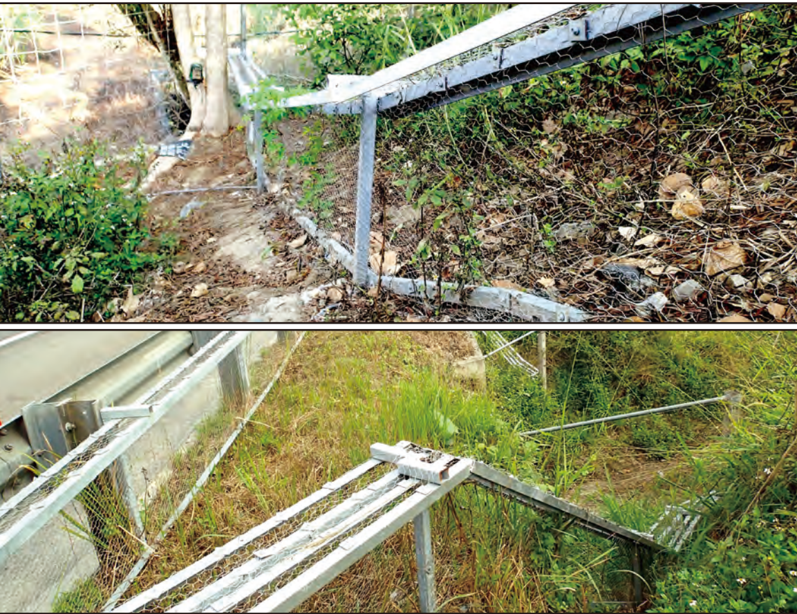
白河段國道 3 號新式的導引網採用與防護網相同的形式。
