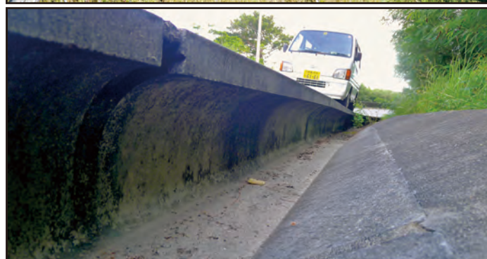
獨特的單側緩傾斜式側溝含飛簷式設計的路緣阻隔設施能有效防止小動物進入道路。拍攝於日本西表島。
