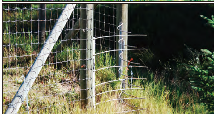
大型動物圍籬設置的脫困單向出口。拍攝於加拿大班夫。
