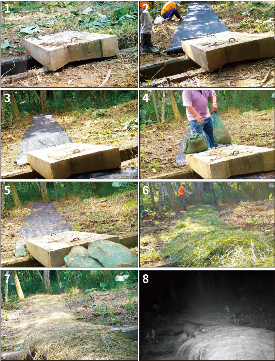
白河工務段為了改善切割跨越式動物通道的幾處排水溝，吊掛了廢棄不用的水溝蓋板作為跨橋，並於兩側堆放土包袋降低落差，鋪設帶狀雜草抑制蓆、草桿來降低後續維管頻度並使路徑景觀自然化。
