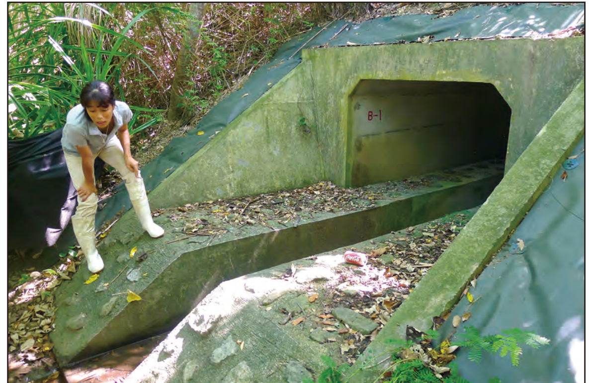
複式斷面穿越式動物通道設計 (日本西表島)。
