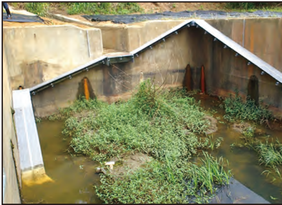
利用國道車損鋼板護欄設計大型沉砂池的動物坡道。
