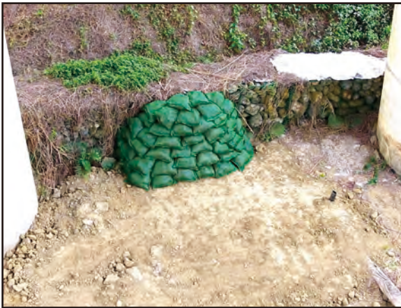
堆放土包袋可以提供方便攀爬的坡道，是簡易的動物坡道形式。
