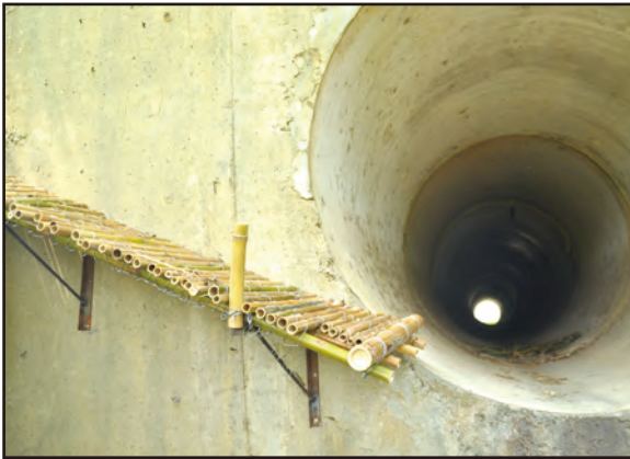
國道 3 號嘉義民雄的動物坡道，利用固定於壁面的角鋼、現地桂竹所製作。
