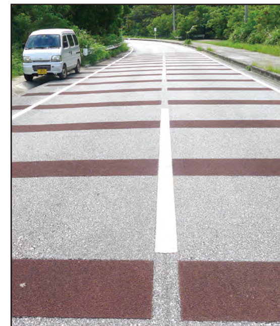
日本西表島所設置的噪音路面與減速標線，車輛駛過會發出明顯聲音。
