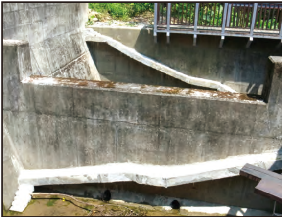
國 3 甲鄰近富陽公園路段滯洪池所設置的動物逃生坡，坡道角度、寬度等設計應視目標物種調整。
