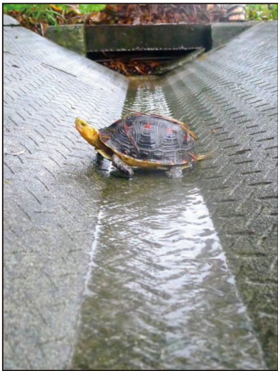
垂直壁面排水溝會造成掉落動物受困死亡(上)，設計成緩坡粗糙面不會影響動物通行(下)。拍攝於日本西表島。
