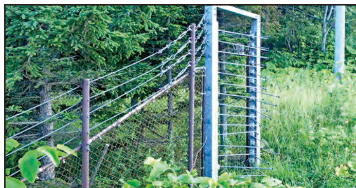
大型動物圍籬上設置有幫助動物脫困的單向出口。拍攝於日本北海道。
