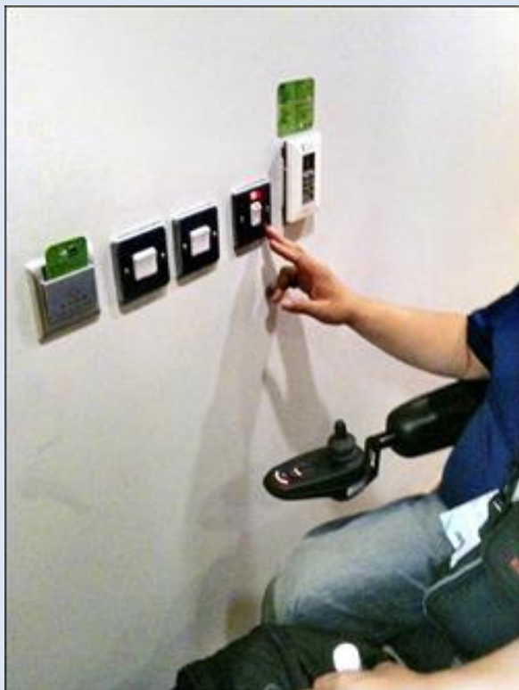
電器插座及開關 距地板面高 70-100 公分 距柱、牆角 30 公分以上
