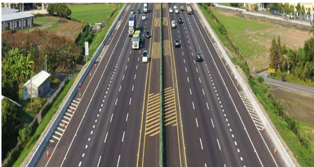
圖 4.1.7 國 1 彰化戰備道雙向增設外側護欄及 LED 路形導引設施
