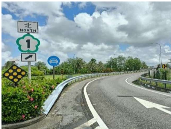
圖 4.1.3 護欄端末漸變辦理成果
