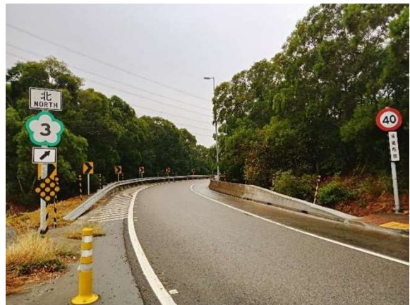
圖 4.1.3 護欄端末漸變辦理成果
