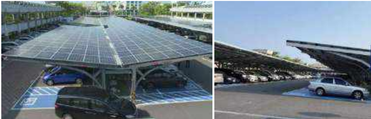
圖5.18 停車場太陽能光電設施案例
