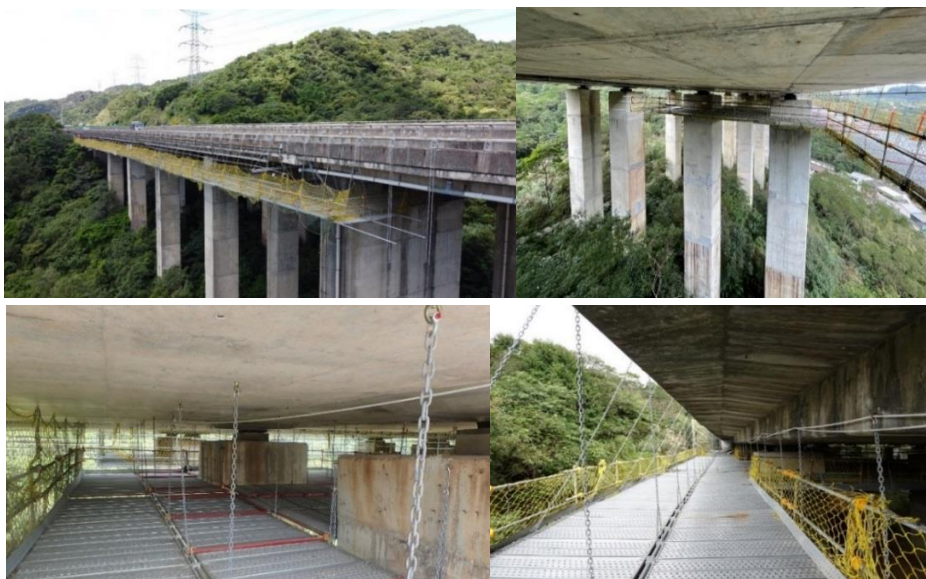
圖 6 懸吊式施工架
