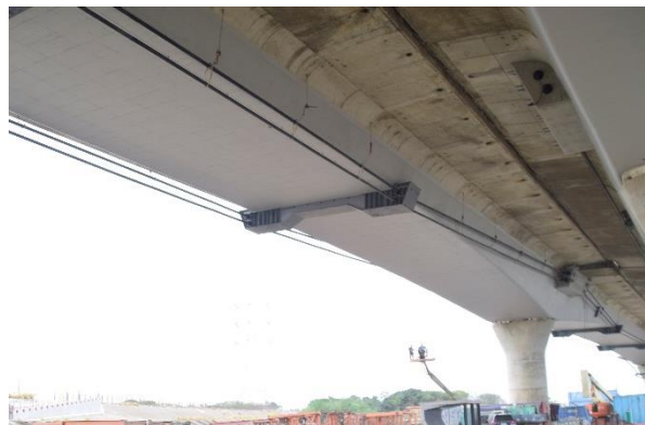
圖 8 箱形梁外增設外置預力補強
