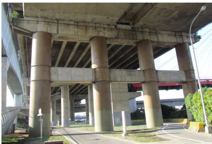
圖 8 圓山橋橋墩 N 補強完成照片
