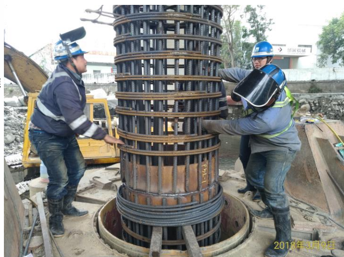
圖 3 基樁鋼筋籠之鋼套環銲接示意圖
