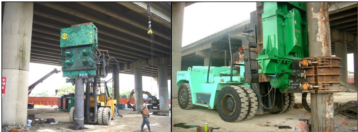
圖 4 鋼管樁施工示意圖
