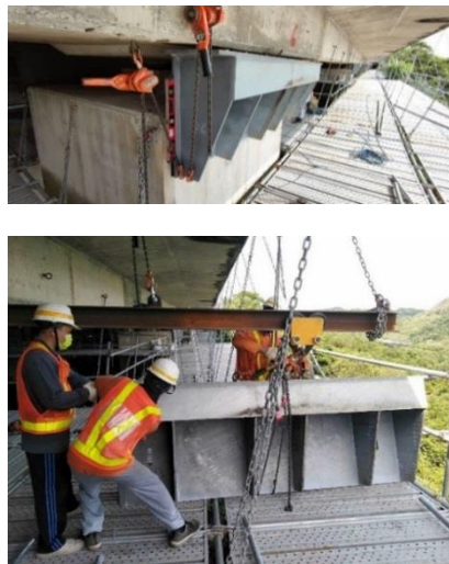
圖 10 鋼製止震塊施工流程圖
