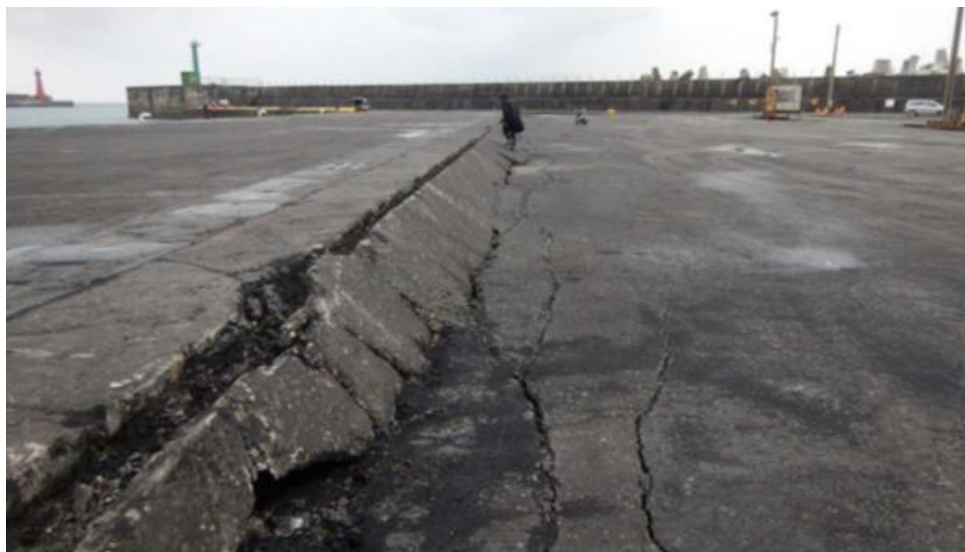
圖 1 花蓮港區沉箱與後線背填接合處地面沉陷
