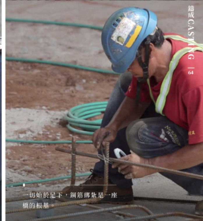
橋樑鋼筋的綁紮過程。
