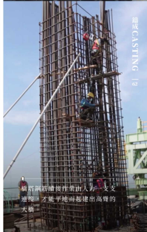
眾人團結施力完成鋼筋圍堰基樁 鋼筋綁紮。
