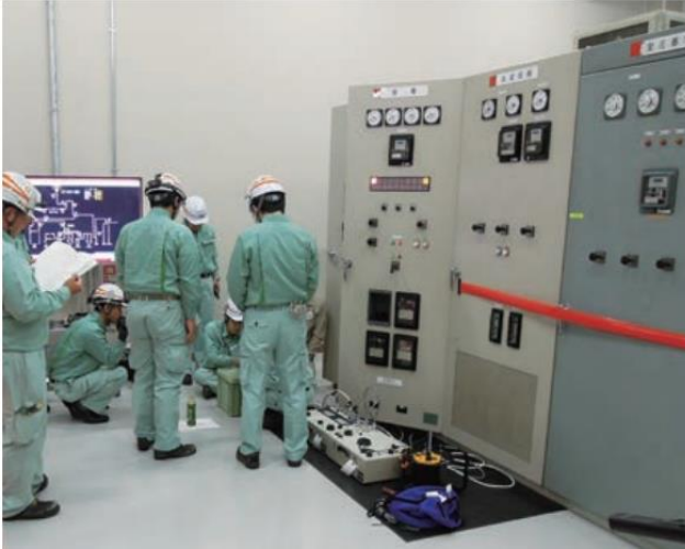
圖 41、受/配電設備檢修訓練
