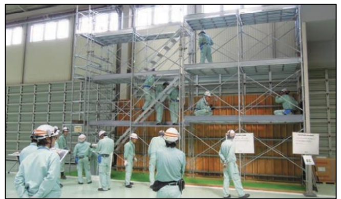
圖 34、使用施工架訓練
