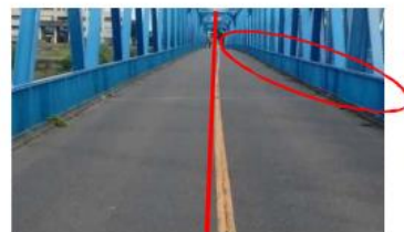
(川島大橋 橋面のゆがみ /岐阜県 HP)
