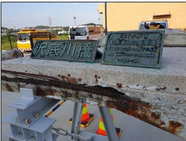
圖 58、道路結構物或設施損傷實物展示學習
