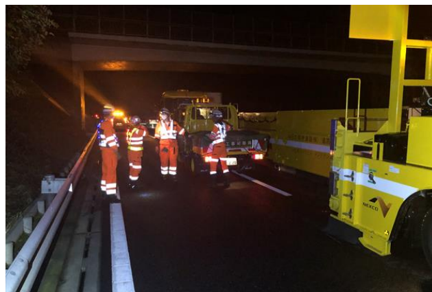
圖 73、使用大型移動式防護車輛施工（夜間）
