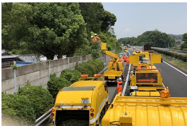
圖 72、使用大型移動式防護車輛施工（日間）
