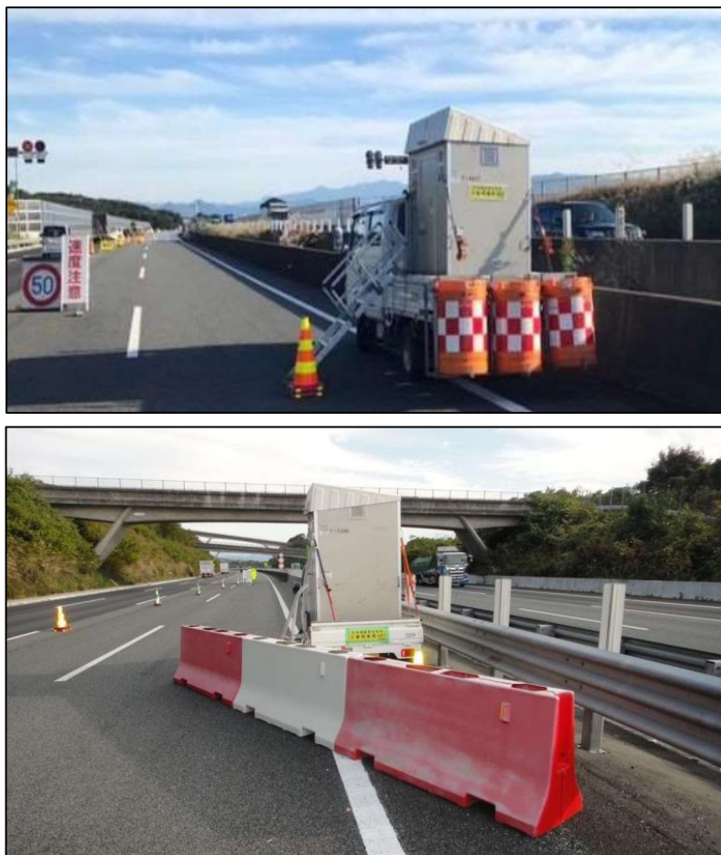
圖 108、車載式移動廁所（配置良好的上下設備及簡易型緩衝設施）
