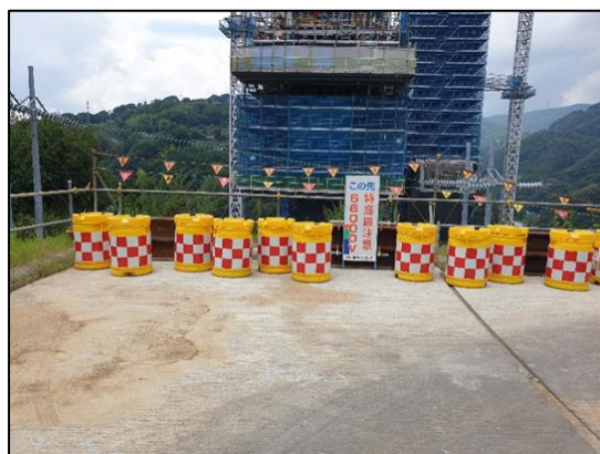
圖 146、設置型鋼式車擋及交通筒
