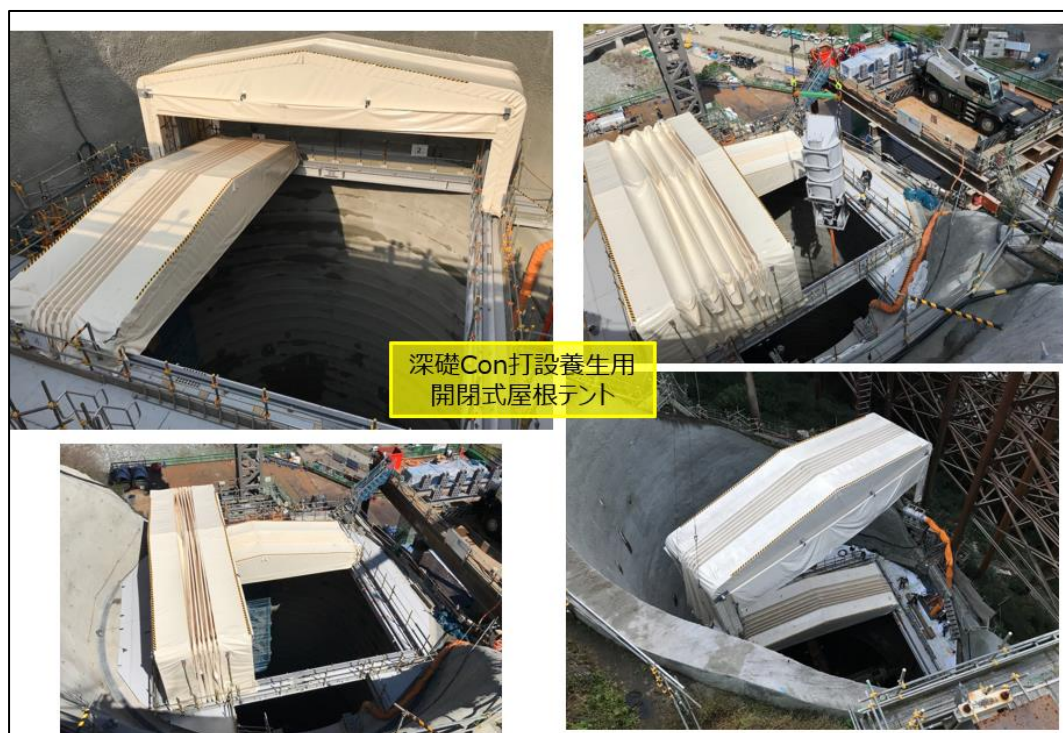
圖 130、大口徑深基礎坑上方設置可伸縮式頂篷
