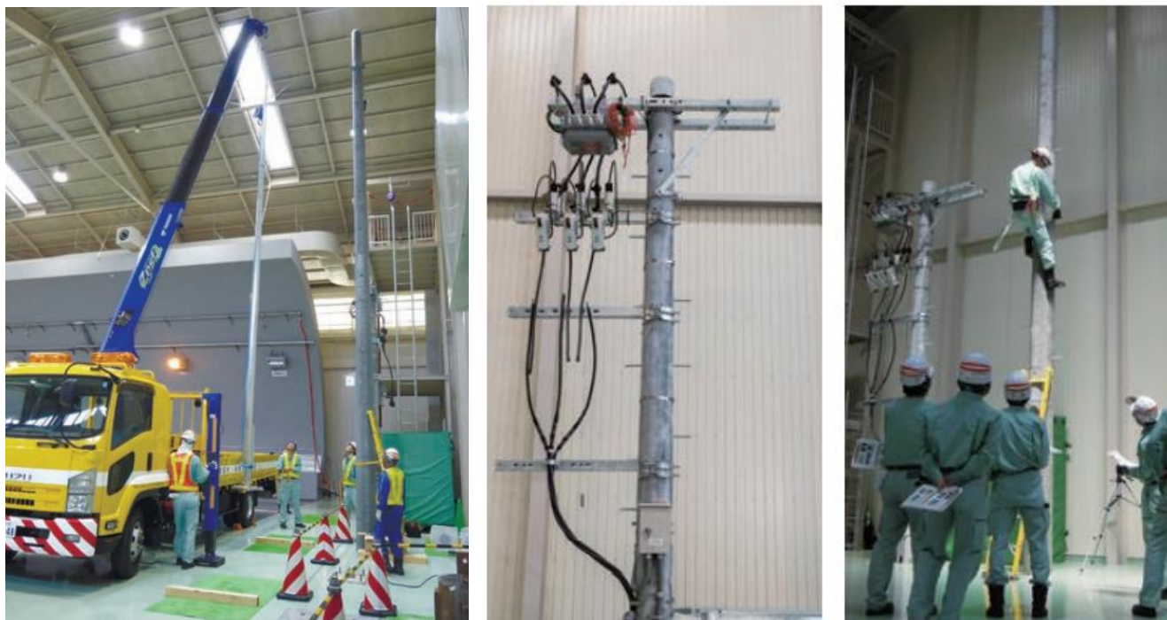
圖 47、路燈及電桿檢修訓練（含使用移動式起重機訓練）
