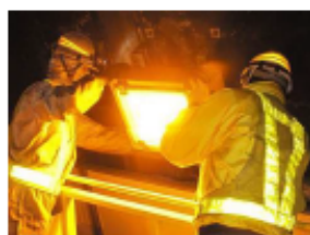
トンネルの点検 近接目視
