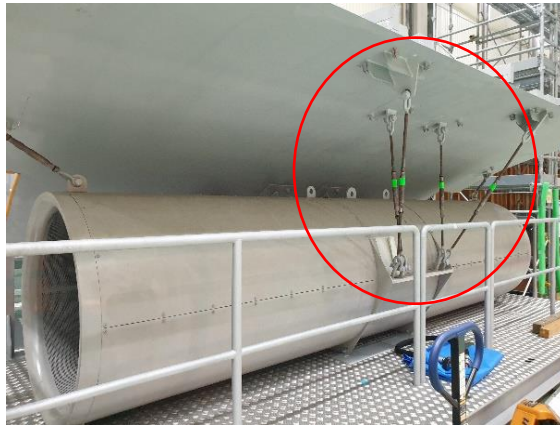
圖 36、噴流式風機採用 2 道防落安全設計
