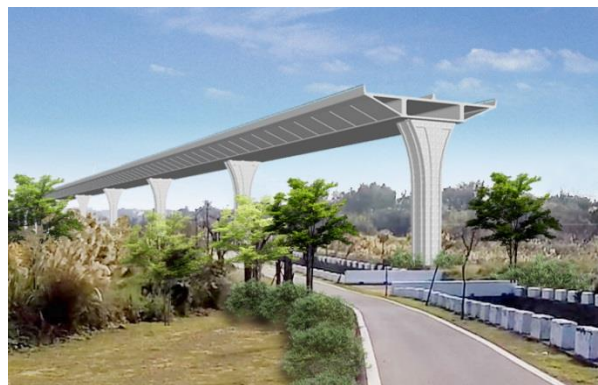
方案四：波形鋼腹板合成梁橋
