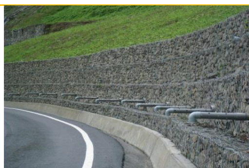
圖 4.6.6-2 石籠擋土牆
