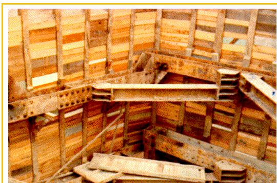
圖 4.6.7-1 鋼軌樁擋土工法
