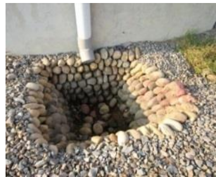
橋下落水口與砌石集水井設計
