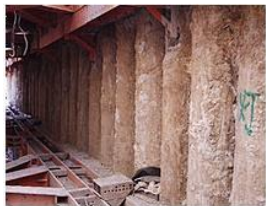
圖 4.6.7-2 鄰近既有構造物施工時以排樁擋土工法提升安全性
