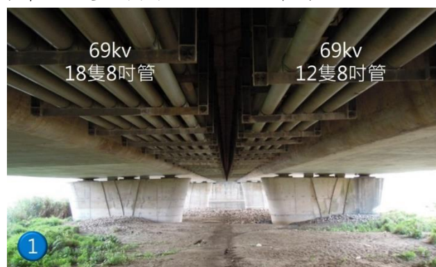
圖 3.3.2-31 航翔路橋下特高壓輸電線
