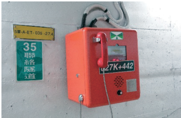
圖 1.3-19 緊急電話 (人行 (車行) 聯絡隧道)
