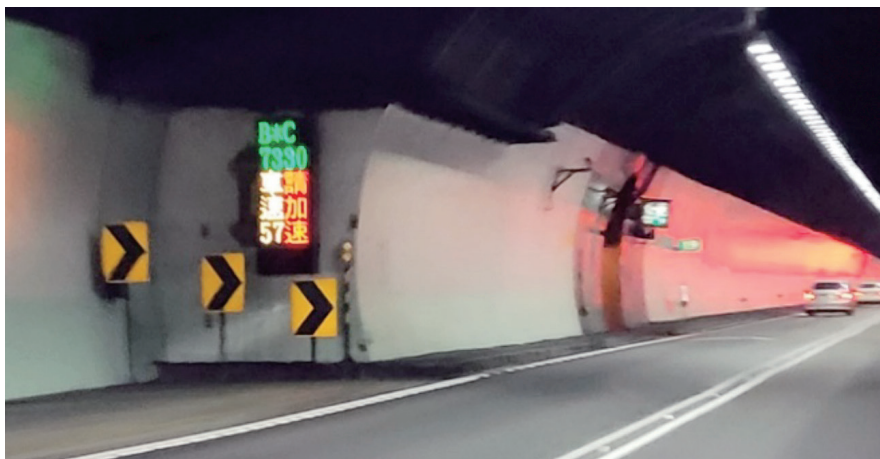
圖 1.3-15 慢速車示警系統
