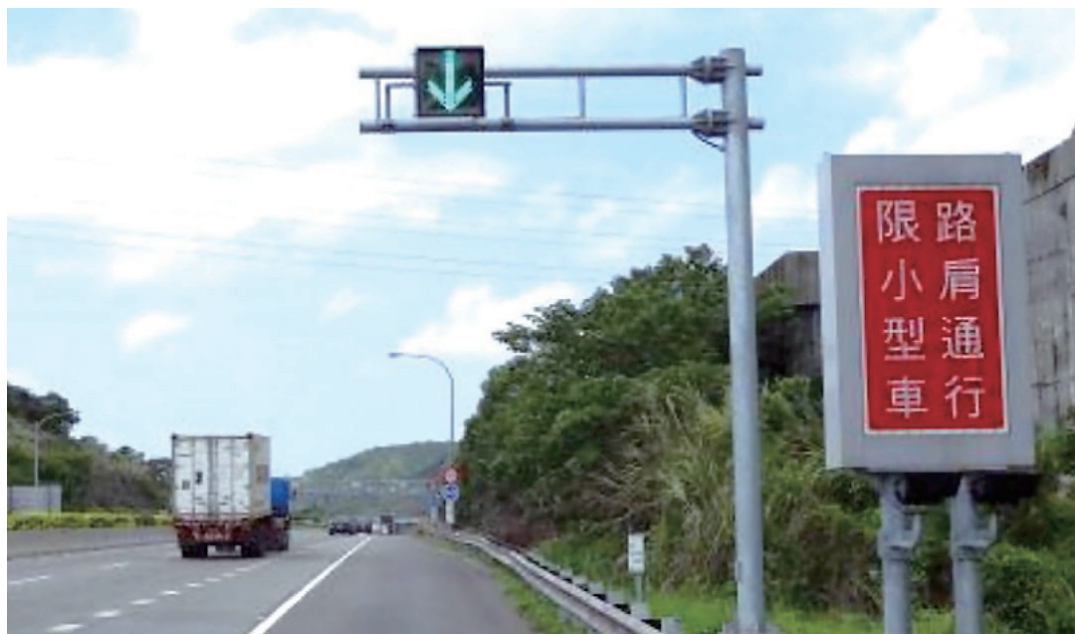
圖 5.1-5 國道主線開放路肩起點三面轉板及車道指示標誌
