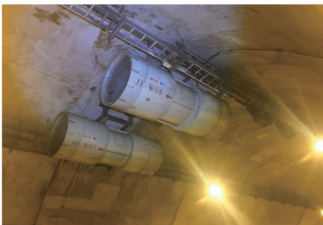
圖 1.3-10 隧道頂拱噴流式風機
