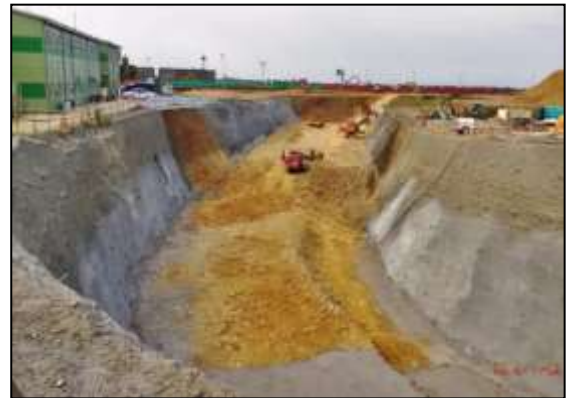
圖 4.1.4-4 斜坡明挖工法
