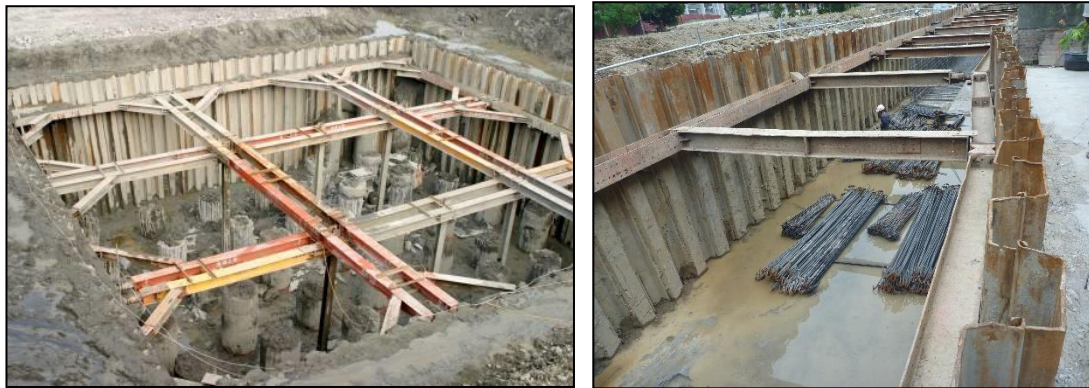
圖 4.1-24 鋼板樁輔以內支撐施工照片
