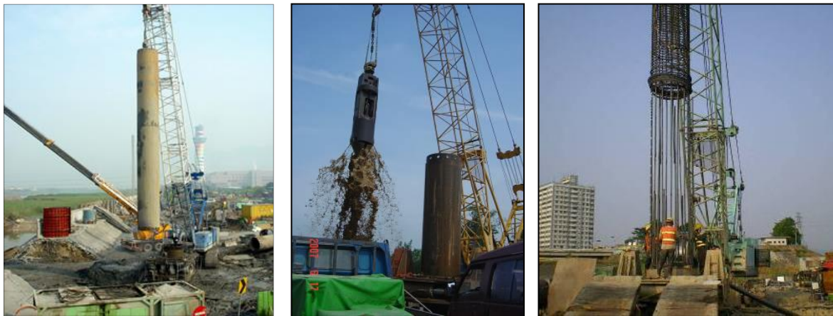
圖 4.1-23 全套管樁施工照片
