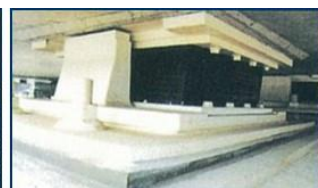
高阻尼橡膠支承 (HDBR)
