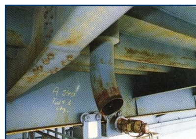
鋼結構腐蝕
