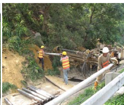
邊坡排水-長向水平排水管
