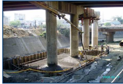
自充填混凝土施工免搗實
