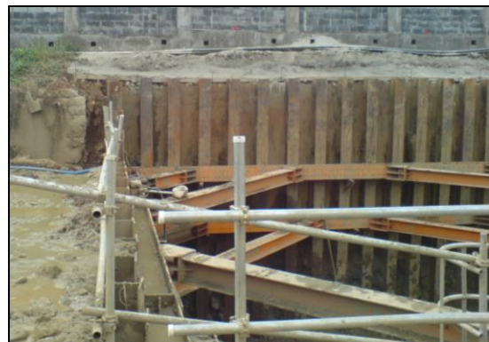
圖 4.1.7-5 垂直擋土輔以內支撐施工照片
