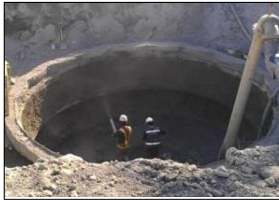
圖 4.1.7-4 井式基礎施工
