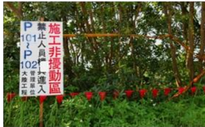
研擬最小施工擾動區，施工時圍設非擾動區，保護路外之優良農田/環境
