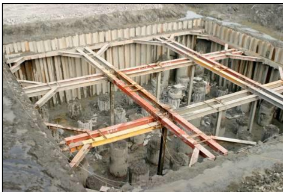
圖 4.1.7-5 垂直擋土輔以內支撐施工照片
