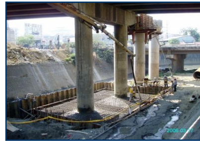
自充填混凝土施工免搗實
