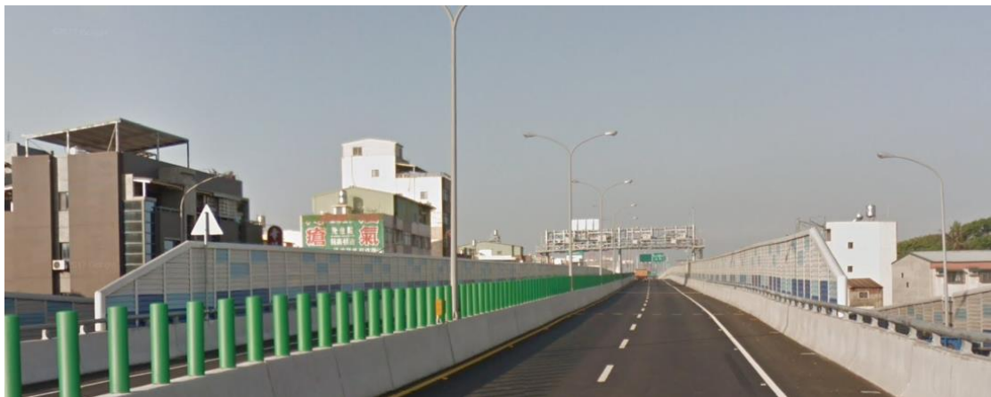
圖 5.1-34 增高型中央鋼筋混凝土護欄案例
