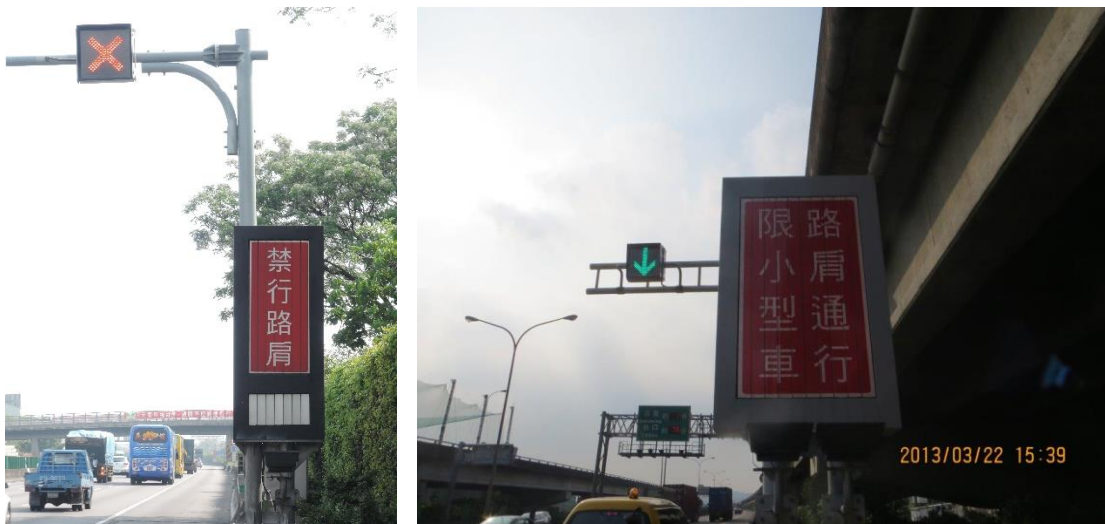
圖 4.1-7 SCS 搭配車道管制號誌顯示內容
