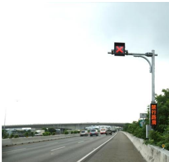
圖 4.1-8 CMS 搭配車道管制號誌顯示內容
