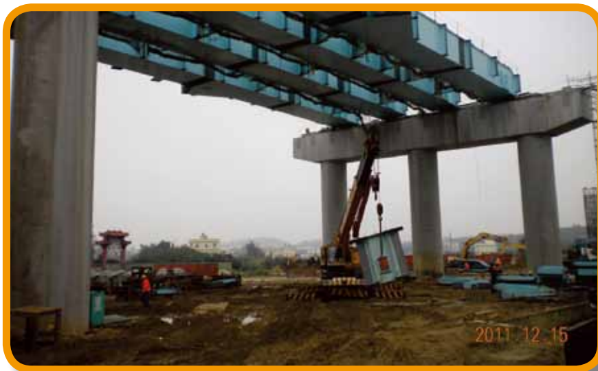
P5~P6 鋼箱梁吊裝作業
