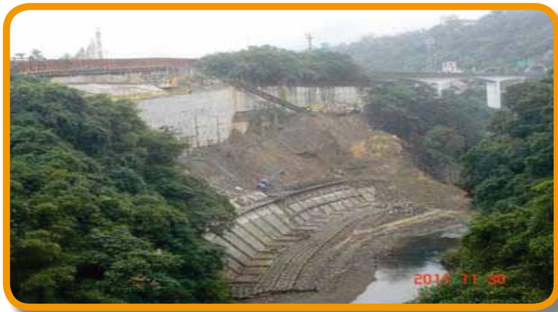
混凝土護岸、擋土牆及 MRC 回填施工
