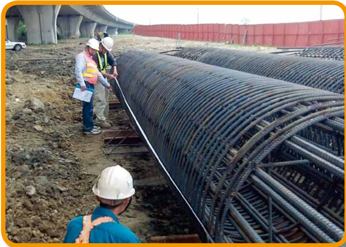
L1 匝道基樁鋼筋籠尺寸檢驗
