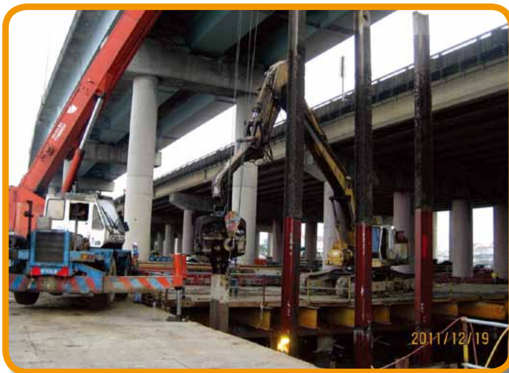
橋梁耐震補強工程第 M12 後續標工程淡水河橋墩柱補強
