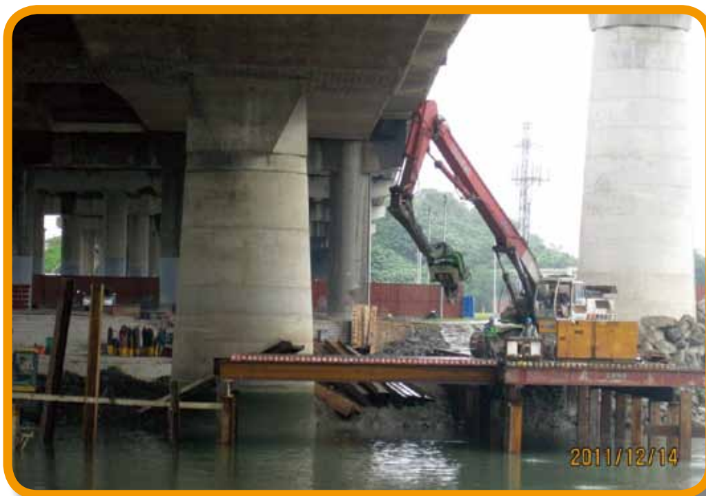
橋梁耐震補強工程第 M12 後續標工程淡水河橋墩柱補強
