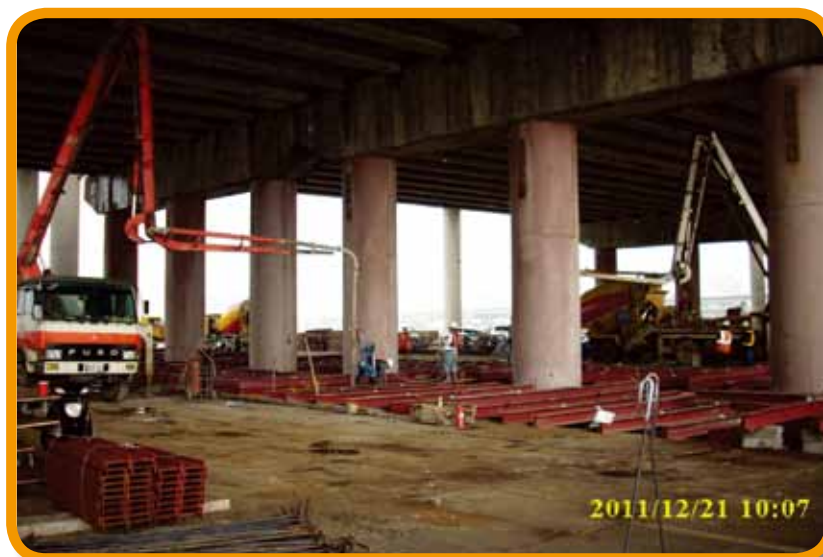
橋梁耐震補強工程第 M12 後續標工程淡水河橋墩柱補強
