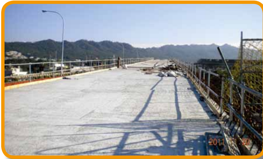
A 匝道 AA1~PA7 橋面板混凝土澆置完成
