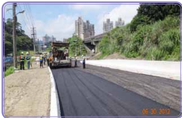
第 B14 標－ 匝道 L4 瀝青處理底層鋪設 (B.T.B) － B14 標
