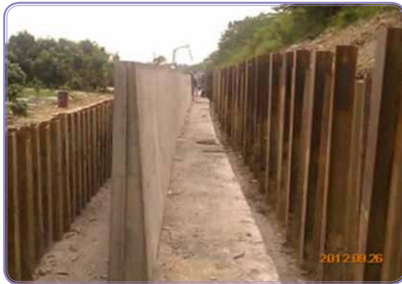
柳營交流道工程－擋土牆施工情形
