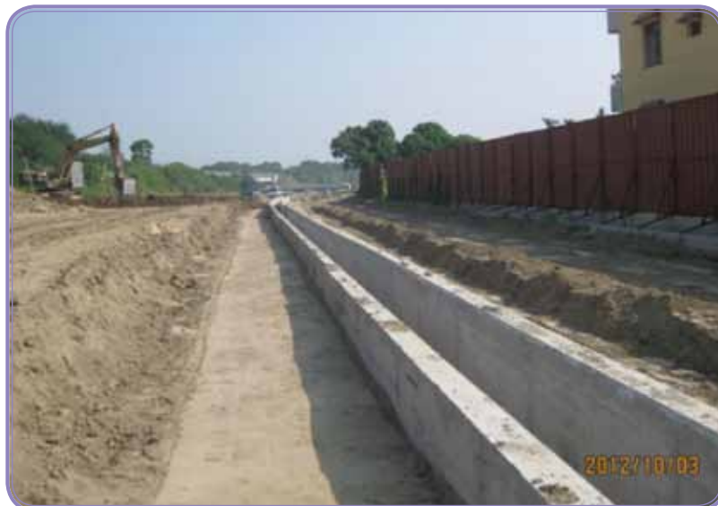
柳營交流道工程－排水溝結構完成回填施工
