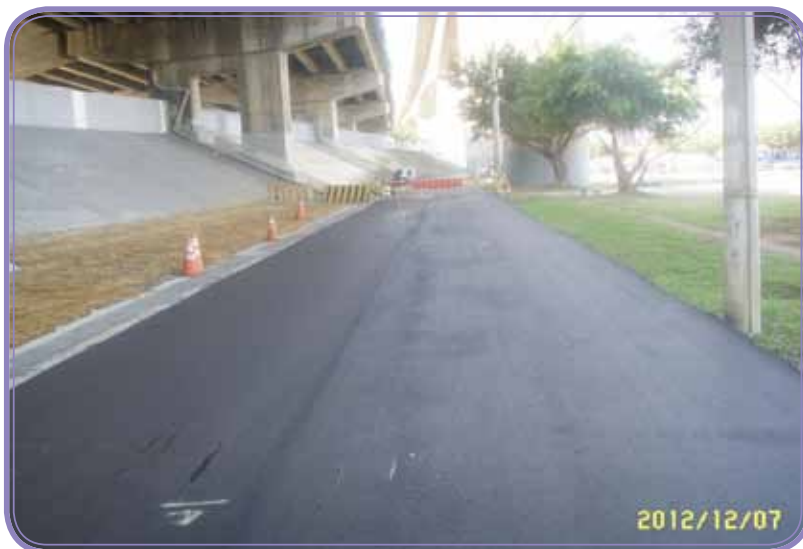
第 M12 後續標－圓山南引橋－臨河側自行車道及 P6~P7 防汛道路 AC 鋪設
