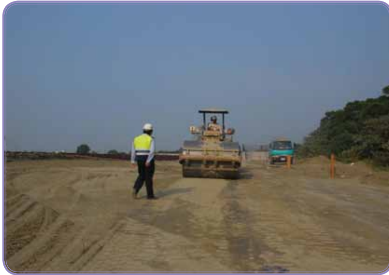
柳營交流道工程－匝道 1 路堤填築施工情形 (101 年 9 月 25 日)
