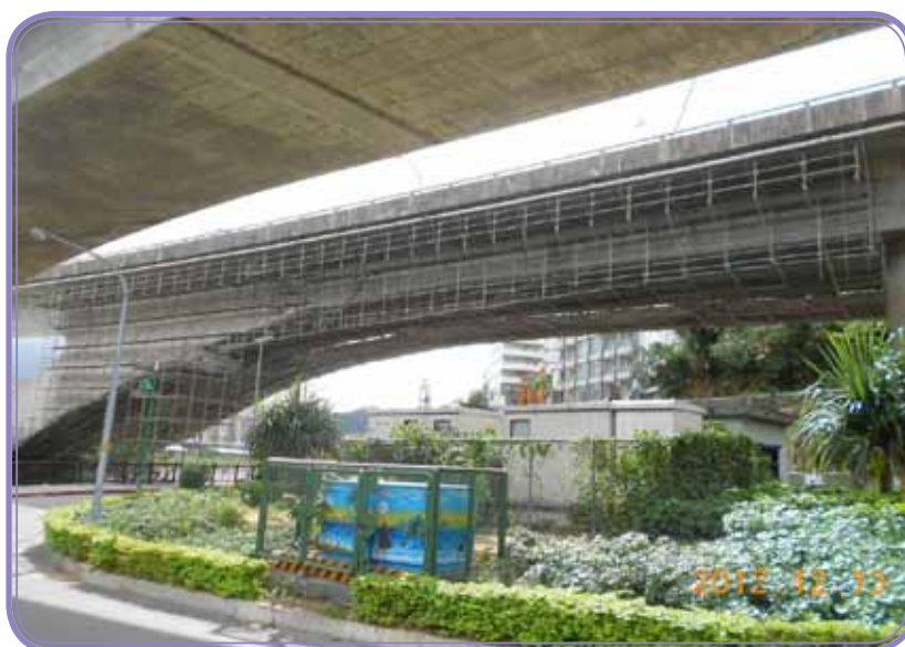
第 M31 標－碧潭橋 5S~6S 施工架組立
