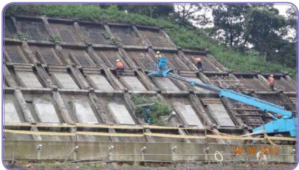
第 B14 標－主線南下原有格梁護坡新設地錨面板
