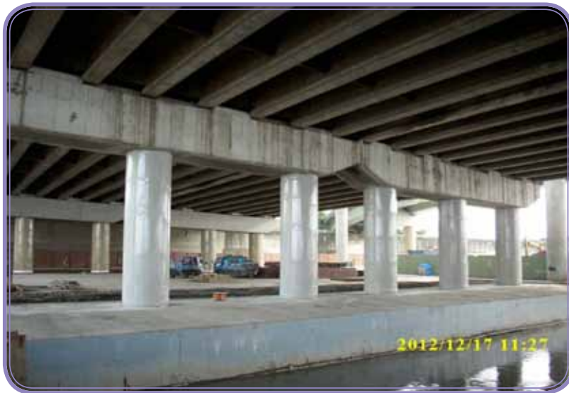
第 M12 後續標－淡水河橋－P4 墩柱鋼板包覆二型防水處理
