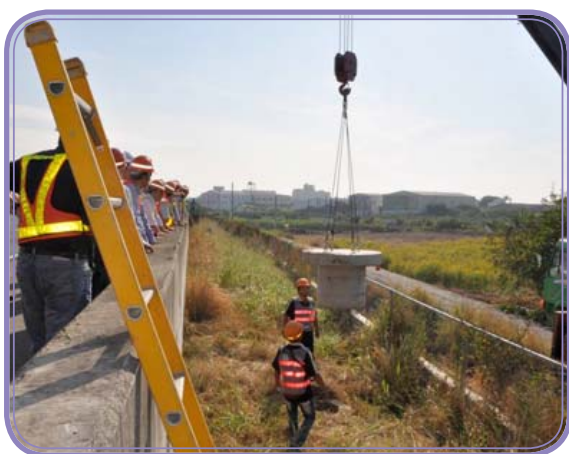
2 噸 RC 人孔蓋施工
