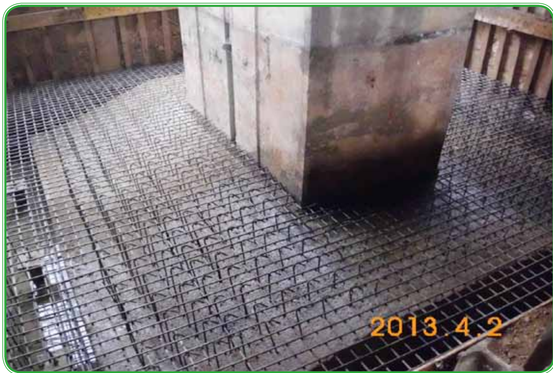
第 M32 標 龍潭高架橋 P13S 鋼筋綁紮作業
