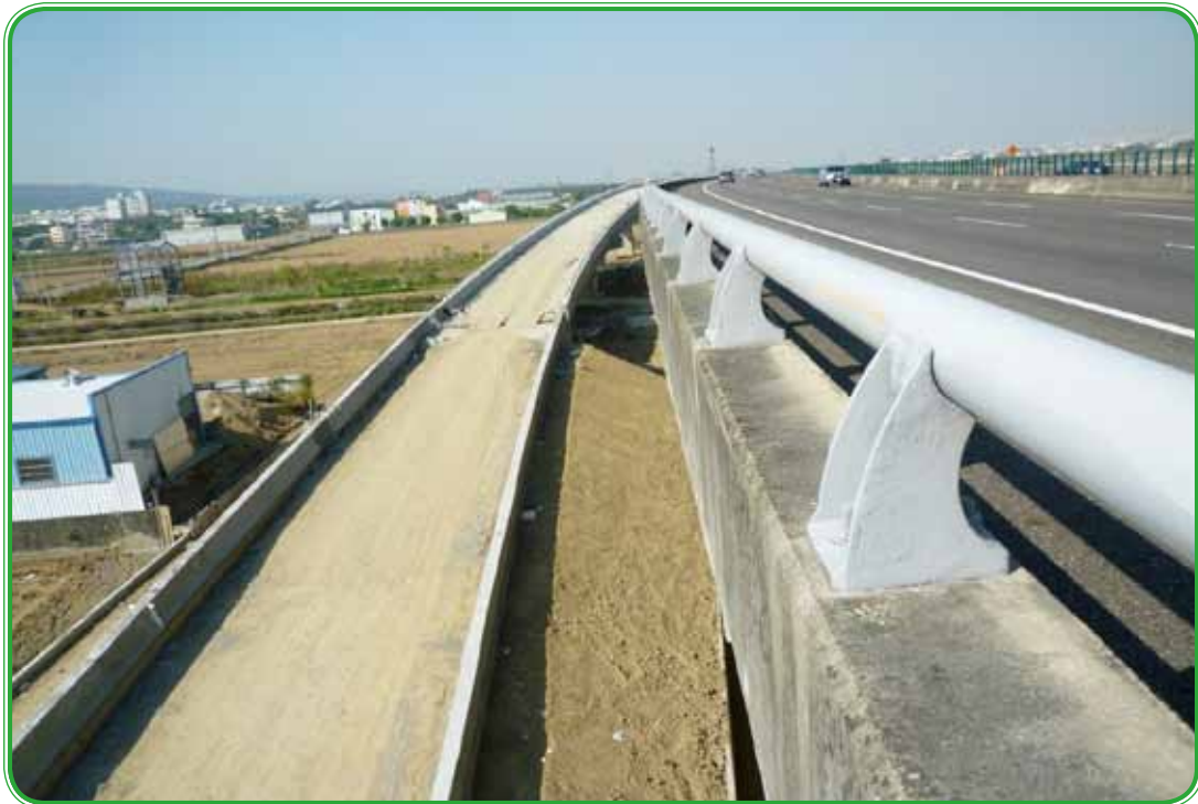
第 C14 標 R1 匝道 RC 護欄施工現況
