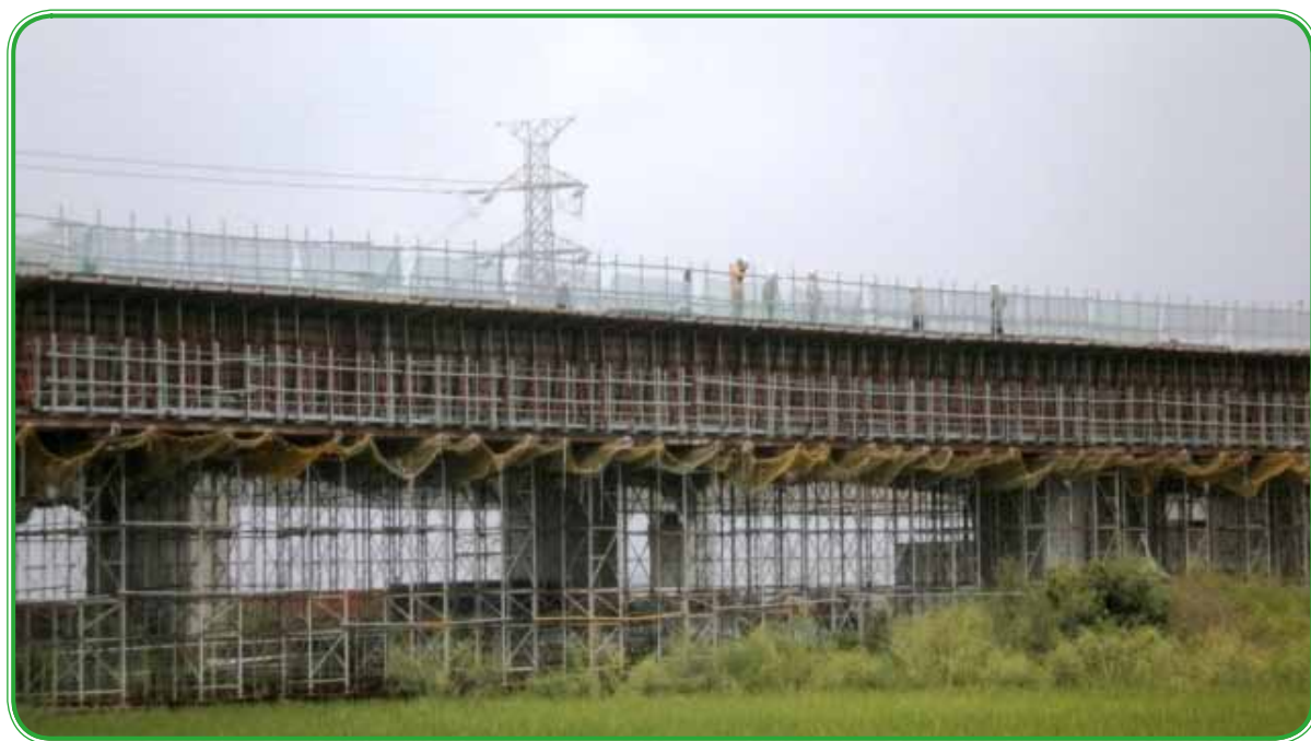
第 D24 標 匝道 3 場撐箱梁施工
