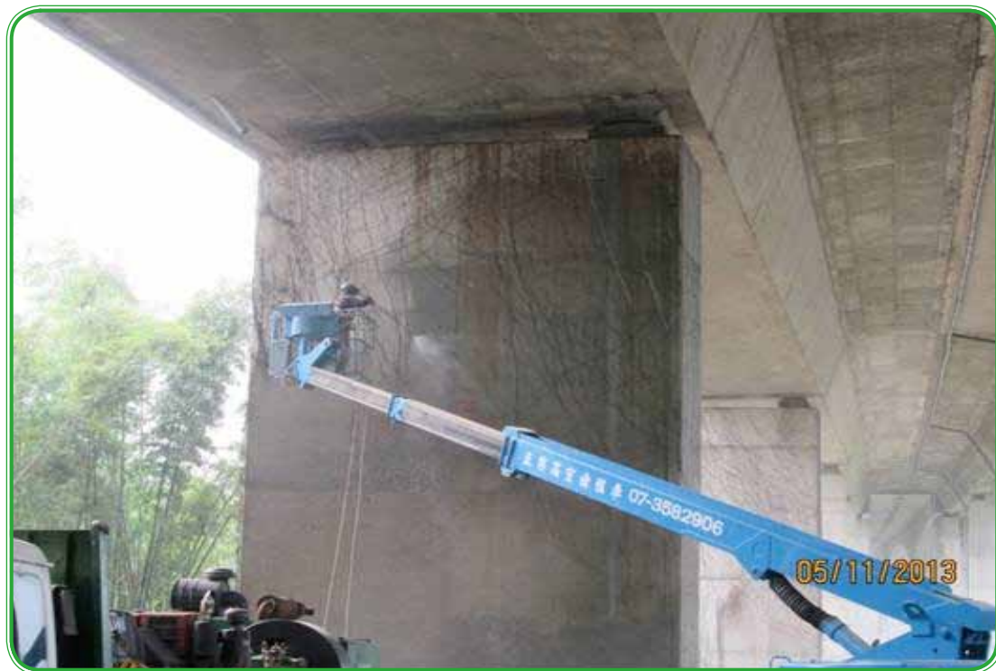
第 M36 標 田寮 2 號高架橋 P35R 墩柱混凝土表面水刀打毛
