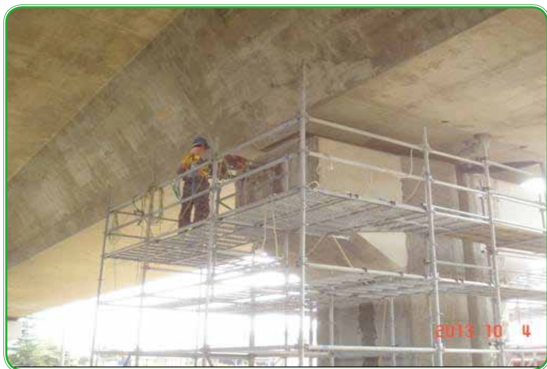
第 M36 標 高雄環線高架 (三) 橋墩柱 P15L 植筋
