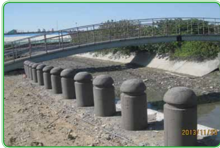
M12B 標 第 1 工區車阻拆模
