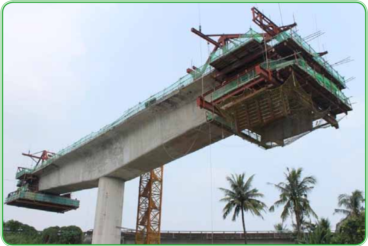
第 L31 標 匝道 A P9 懸臂工作車施工
