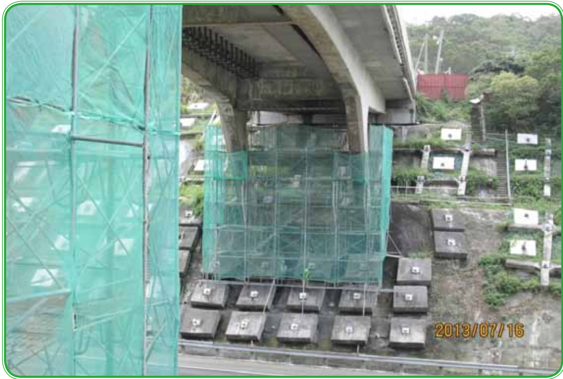
第 M34 標 雲南路墩柱 FRP 包覆情形
