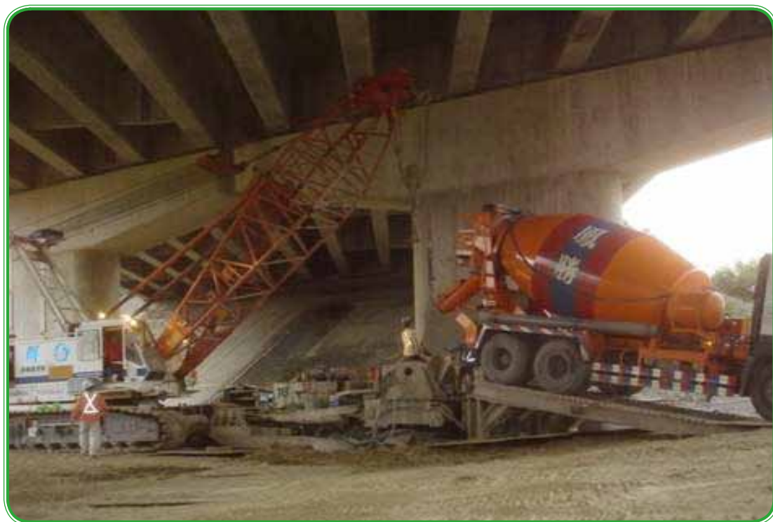
第 M36 標 典寶溪過水橋 P5R-G2 全套管鑽掘樁 (100cm \phi ) 施作
