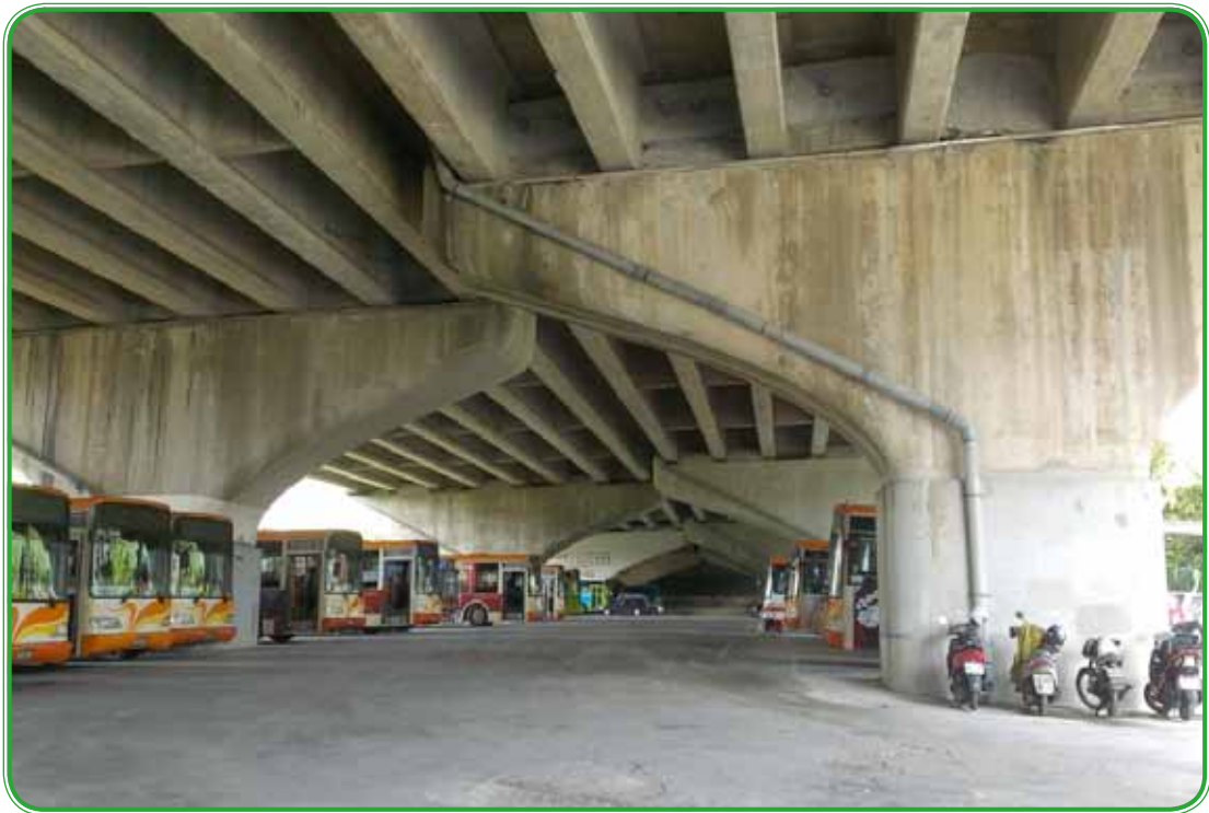
M31 標 舊庄高架柱補強完成
