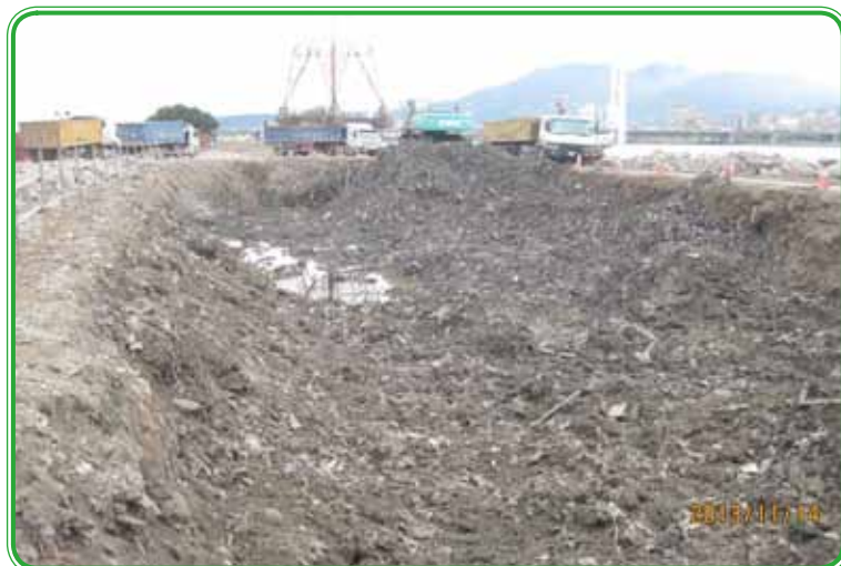
M12B 標 第 2 工區廢棄物開挖清運作業
