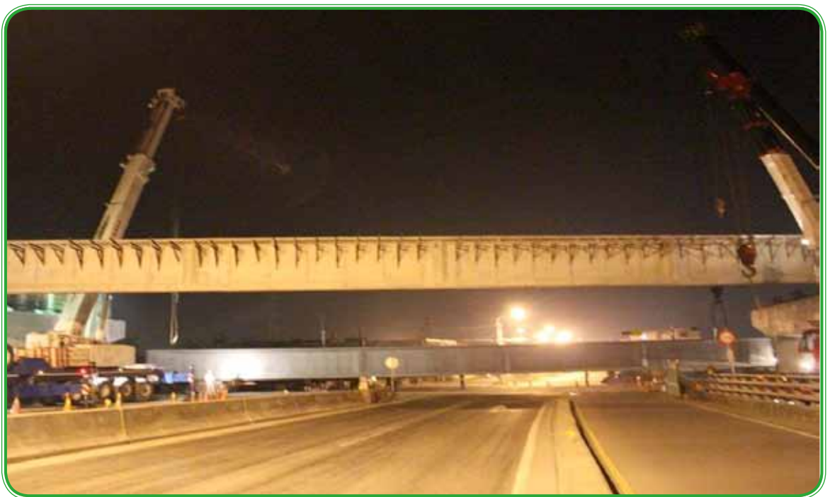
第 L31 標 屏 103-1 P5~P6 跨台 3 線夜間吊梁作業
