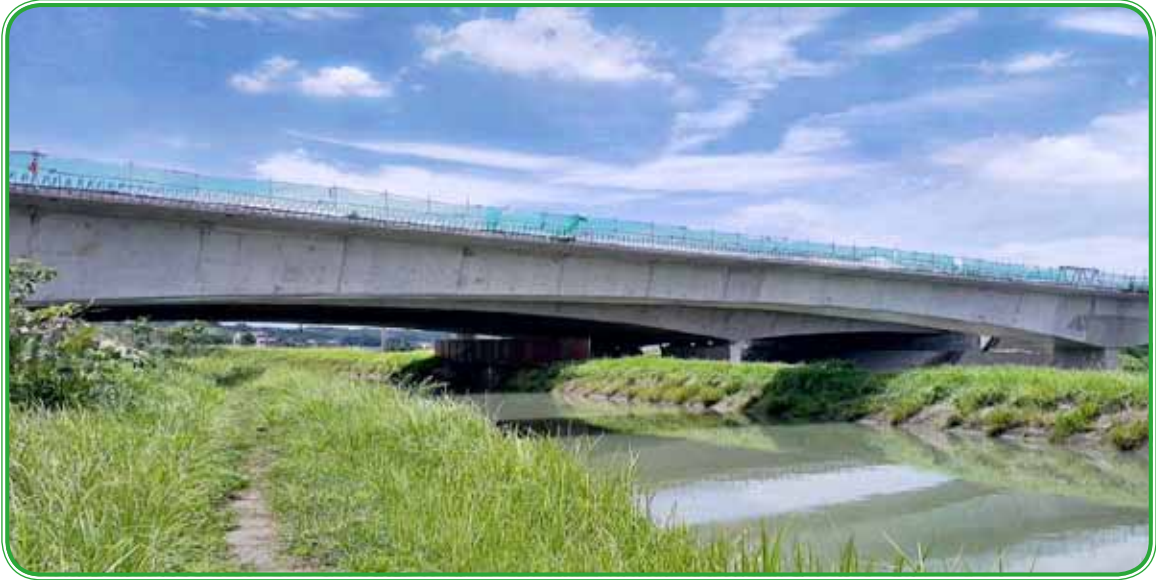
第 D24 標 匝道 1 懸臂箱梁橋施作完成
