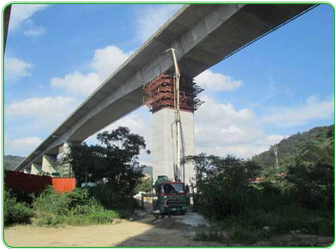
M31 標 墩柱 RC 包覆混凝土澆置
