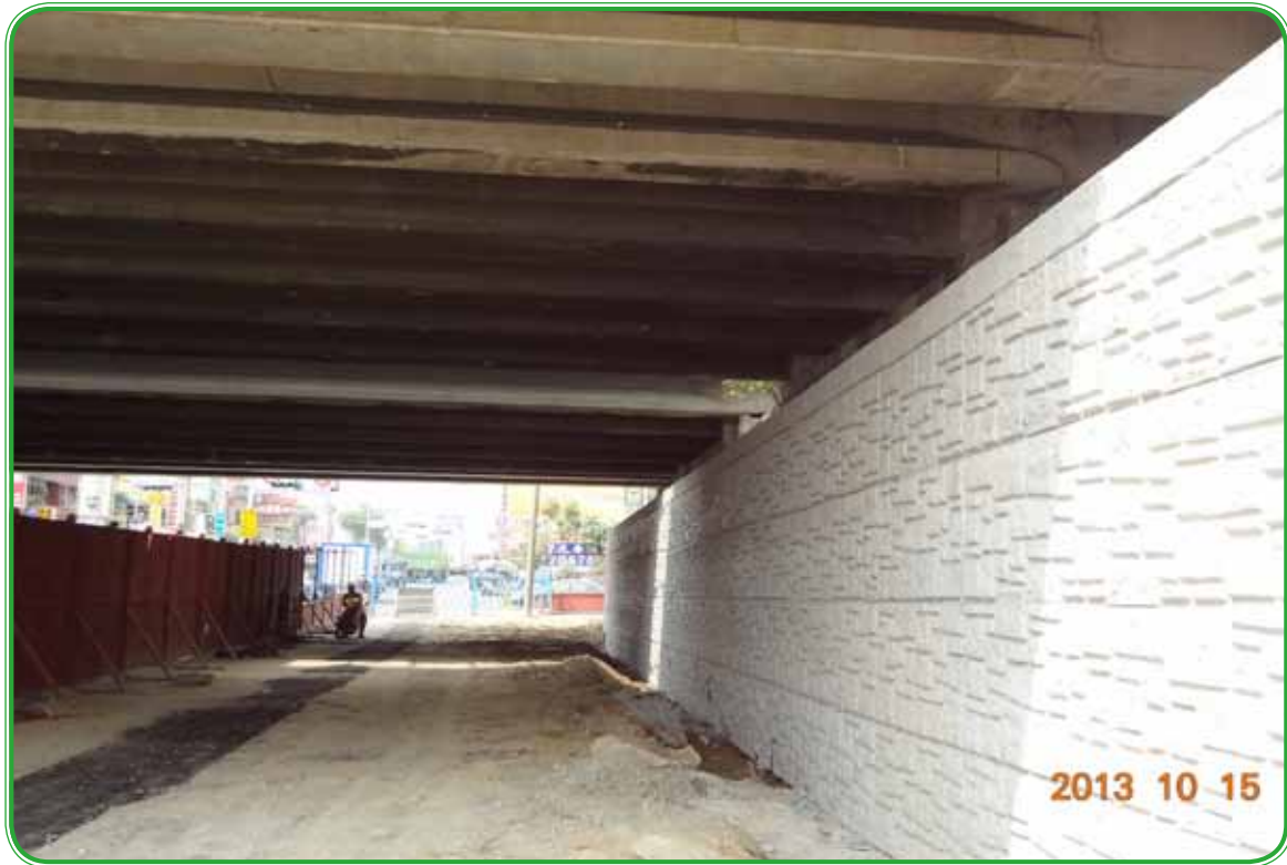
第 514 標 縣道 180 穿越橋 A1 橋台造型模版完成
