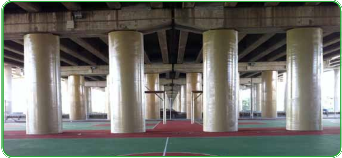
第 M12 後續標 洩洪橋 P8 墩柱鋼板包覆二型防水處理
