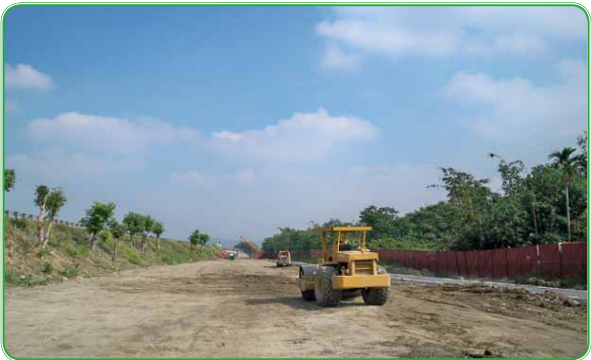
第 D14 標 FP1(0k+500~0k+700) 原地面滾壓施工現況
