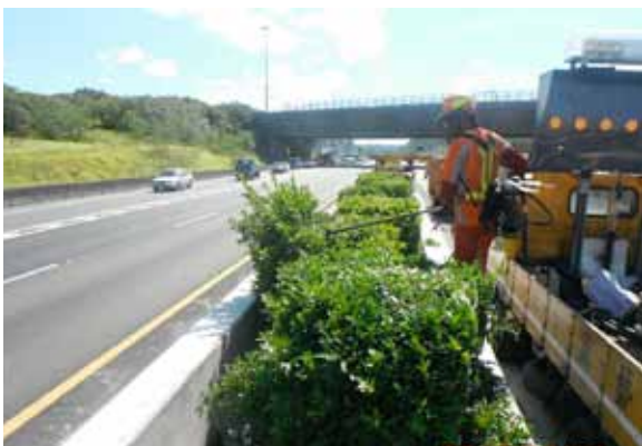
國道 1 號 36-39k 中央分隔帶小葉榕以半自動機械修剪情形
