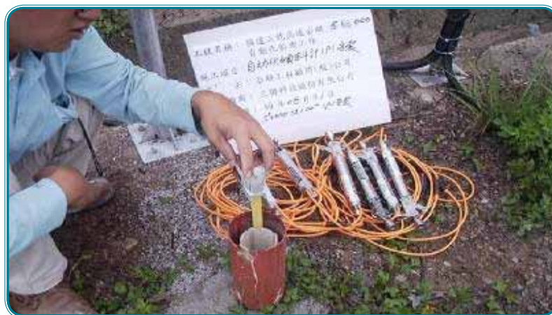
圖 2 自動化傾度管裝設情形
