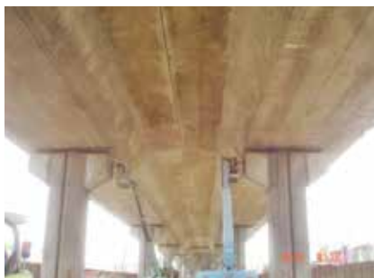
▲高環(三)P50 混凝土止震塊植筋鑽孔
