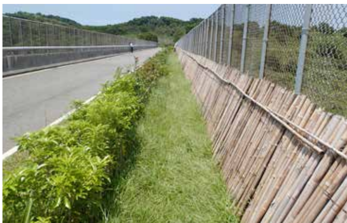
圖 9 ▲國道 3 號通霄 1 號跨越橋分隔出 1/3 空間作為生物廊道提供動物使用，經持續監測已有白鼻心、野兔等物種出入紀錄。
