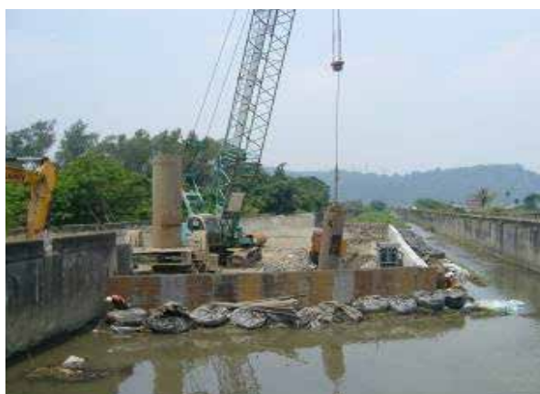
▲ L3 箱涵全套管基樁施工
