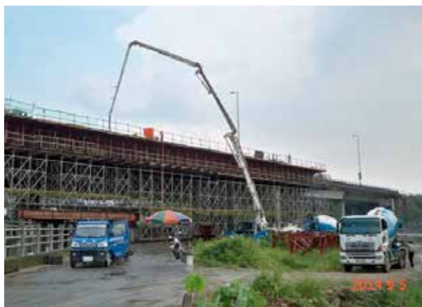
▲ RW-02 擋土牆牆身混凝土澆置
