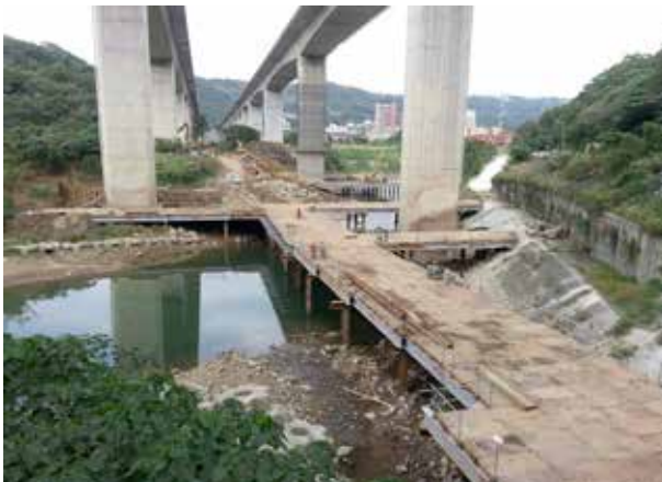
▲ 景美溪北橋 PN15~PN17 及景美溪南橋 PS21 施工構台搭設
