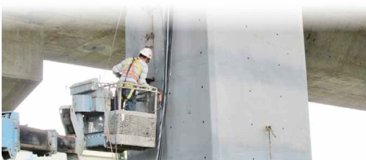
▲高環 (三) P28L 墩柱鋼板包覆施作
