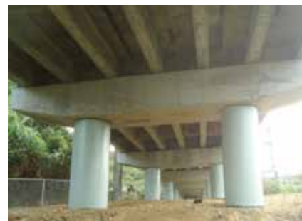
▲中和交流道匝道 B(二) 鋼板補強包覆完成
