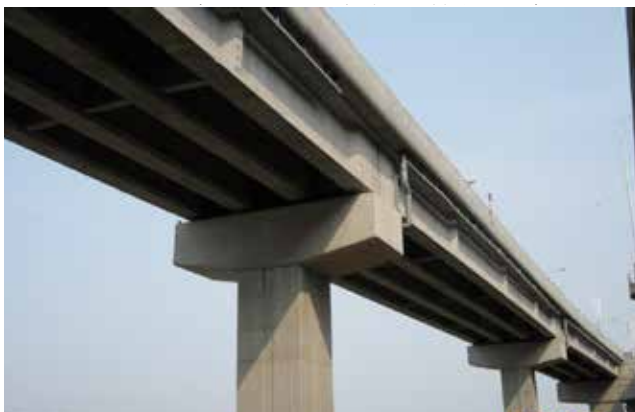
▲ R1 南下出口匝道預力 I 型梁及墩柱
