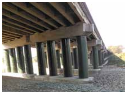
▲三峽溪橋鋼板補強包覆完成
