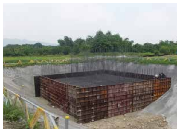
▲ DA1 橋台基礎鋼筋綁紮及組模
