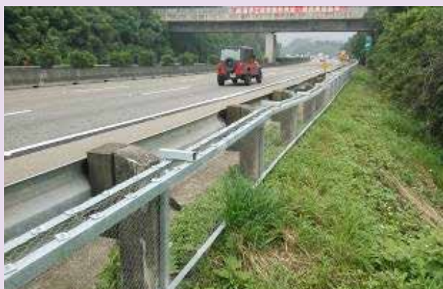
圖 10 ▲國道 3 號 101k ~ 102k(左側照片) 及 286k ~ 288 k(右側照片) 路側設置金屬防護網，防止動物橫越高速公路。
