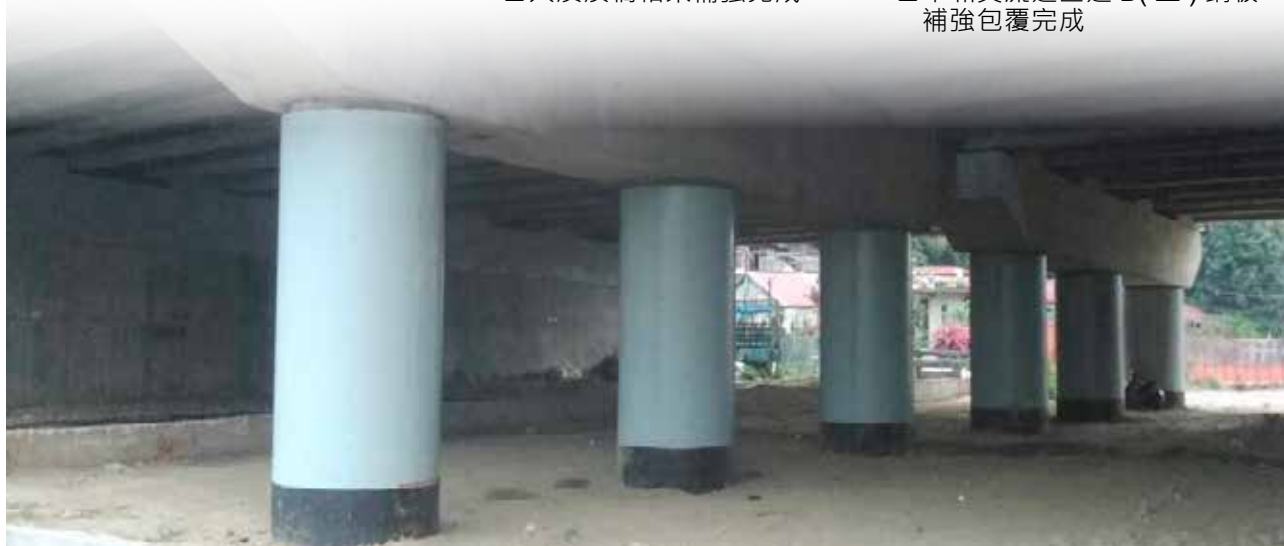
▲柑林埤橋鋼板補強包覆完成
