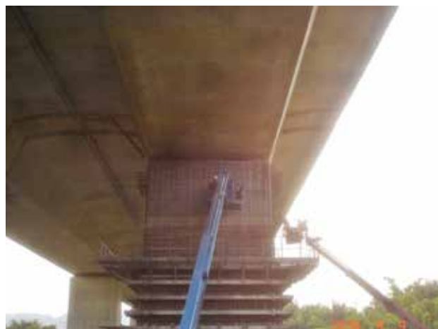
▲田寮 2 號橋 P24R 混凝土止震塊植筋
