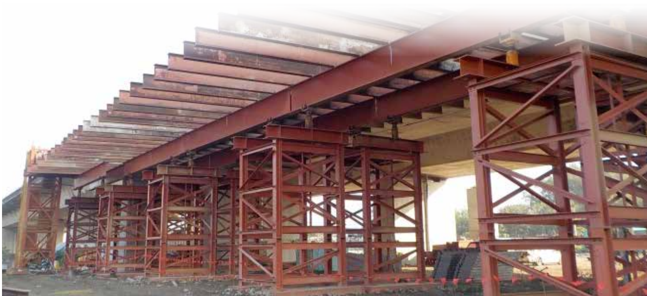
▲ 田 PS1~2 型鋼支撐架設
