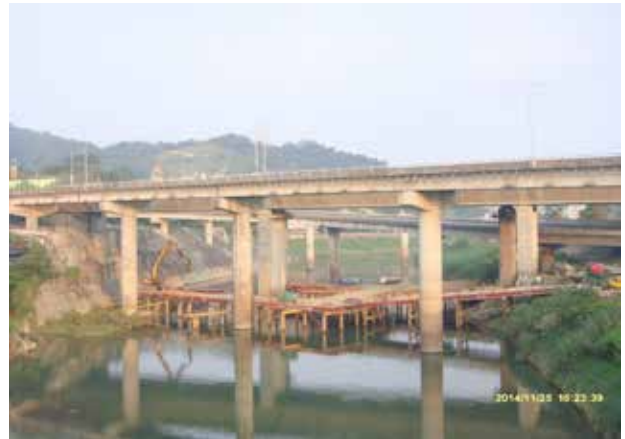
▲ 北側基隆河橋構台搭設
