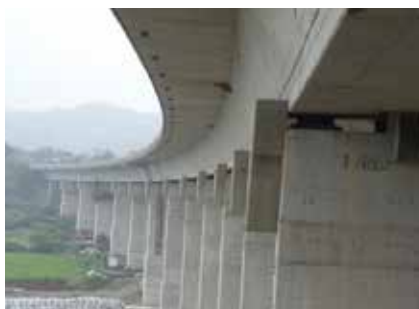
▲頭前溪帽梁止震塊補強
