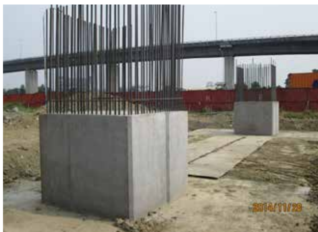
▲ P1 橋墩墩柱施工
