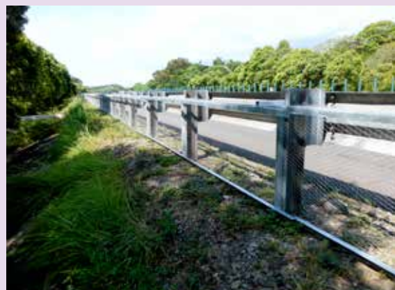
圖 10 ▲國道 3 號 101k ~ 102k(左側照片) 及 286k ~ 288 k(右側照片) 路側設置金屬防護網，防止動物橫越高速公路。
