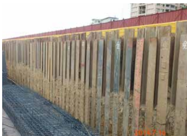
▲北上側匝道 0k+260 懸臂式擋土牆基礎鋼筋綁紮
