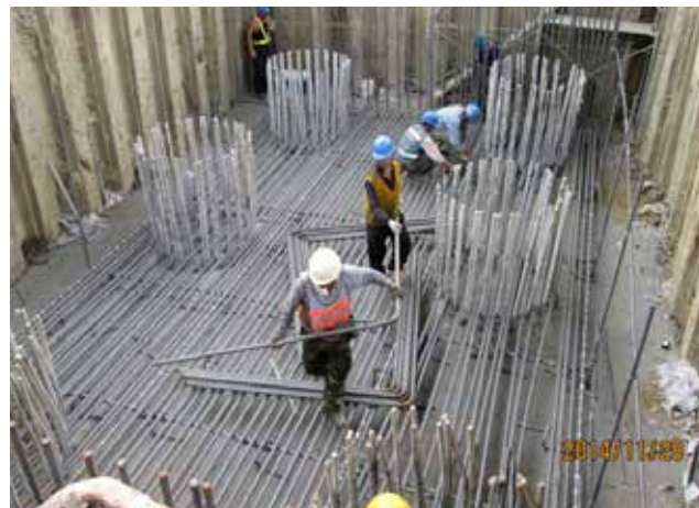
▲ P2R 橋墩基礎鋼筋組立
