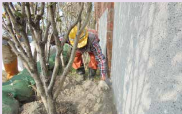
圖 8 ▲大甲段於國道 3 號 N155k+200 ~ 154k+450 隔音牆前，以客土袋堆疊防止土壤流失，並增加覆土量及保水性 (左側照片) · 有效改善木槿之生長與開花 (右側照片)。
