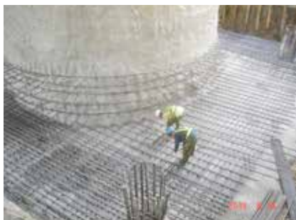
▲田寮 2 號橋 P47L 基礎鋼筋綁紮
