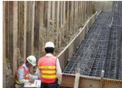
▲ 懸臂式擋土牆基礎施工
