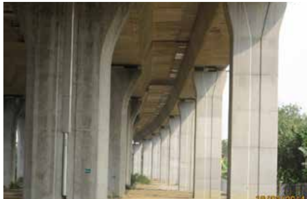
▲ L1 北上入口匝道預力箱型梁及墩柱
