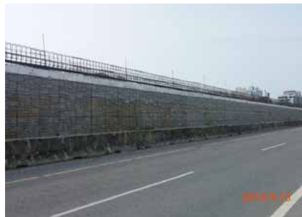
▲主線北上側 324k+560~324k+622 懸臂式擋土牆完成
