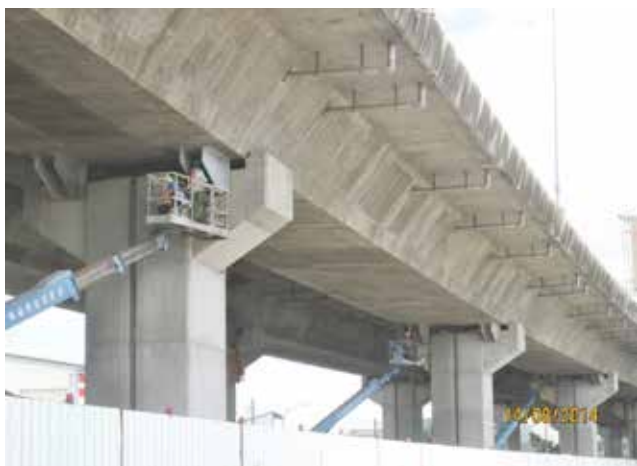
▲高環 (三) P59~P61 鋼板止震裝置錨栓鑽孔
