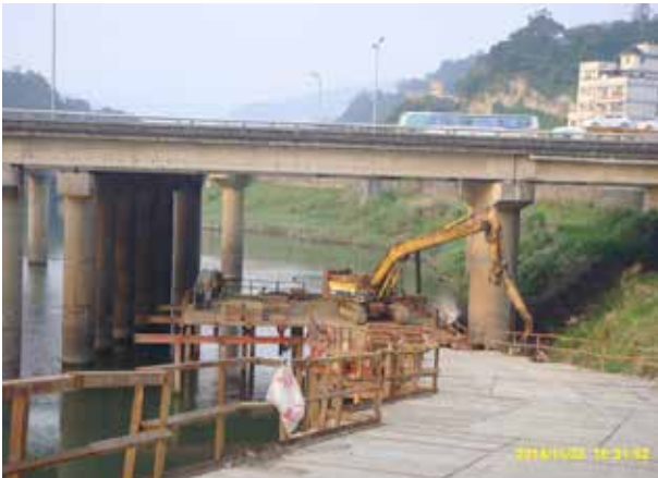
▲ 汐止匝道 6 跨東側基隆河橋構台搭設
