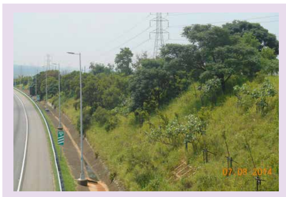
圖 7 ▲大甲段轄區路段 (國道 3 號南下側 174k+822 ~ 175k+422) 土質保水性差，且濱臨海風植生不易，經栽植耐風耐旱植種並加強客土與養護，已達遮蔽不良景觀 (墓葬區) 及邊坡綠美化效果。
