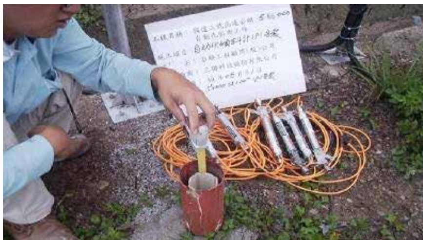
圖 2 ▲自動化傾度管裝設情形
