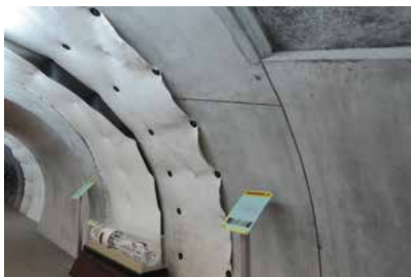
▲雪山隧道傳統鑽炸工法及 TBM 工法 施工步驟展示牆 (2015.02.06)
