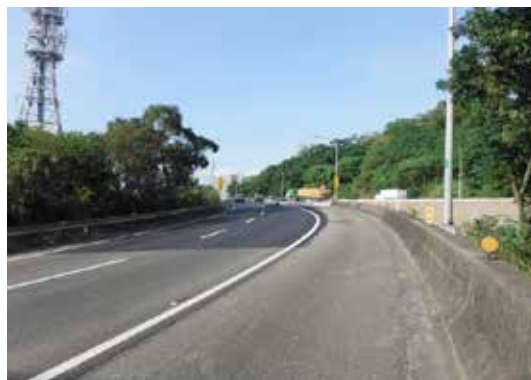
鋪面刨除重鋪，標線配合調整後
