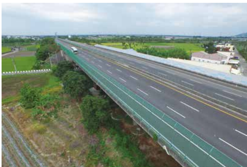
圖 8. 國道 3 號 252k 北上側架設防護網減輕影響。
