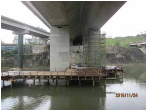
▲ M31 標 墩柱 RC 包覆混凝土
