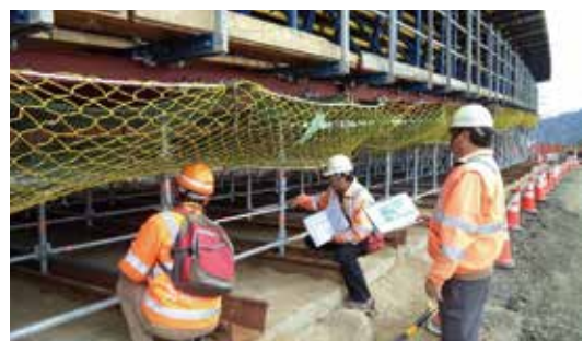
▲第 B34 標 - 辦理 AN1~PN1 箱型 梁支撐架首件檢驗品質查證
