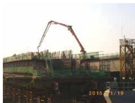
▲ L3 匝道 AP1~AP2 底腹板澆置施工現況
