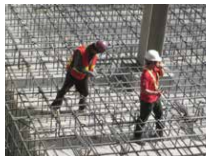
▲第 M36 標 田寮 2 號高架橋 P8R 基礎鋼筋綁紮
