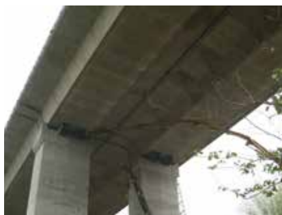
▲第 M36 標 田寮 2 號高架橋 P25 鋼板止震裝置施作
