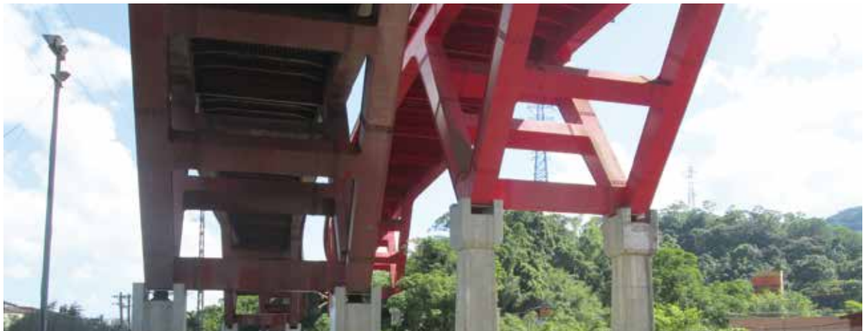
▲ M31 標 鋼構補強完成
