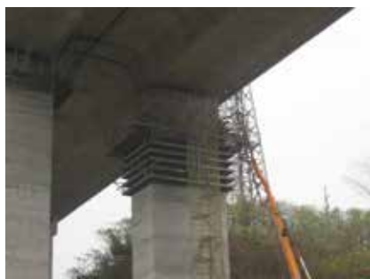
▲第 M36 標 田寮 2 號高架橋 P25L 墩柱包覆混凝土澆置
