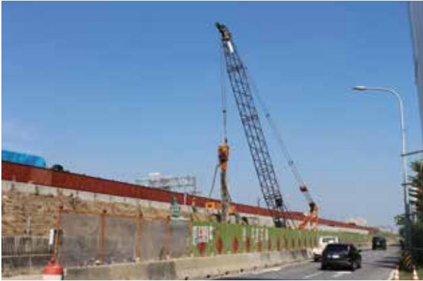
▲第 591 標 匝道 L1 PC 板樁施工
